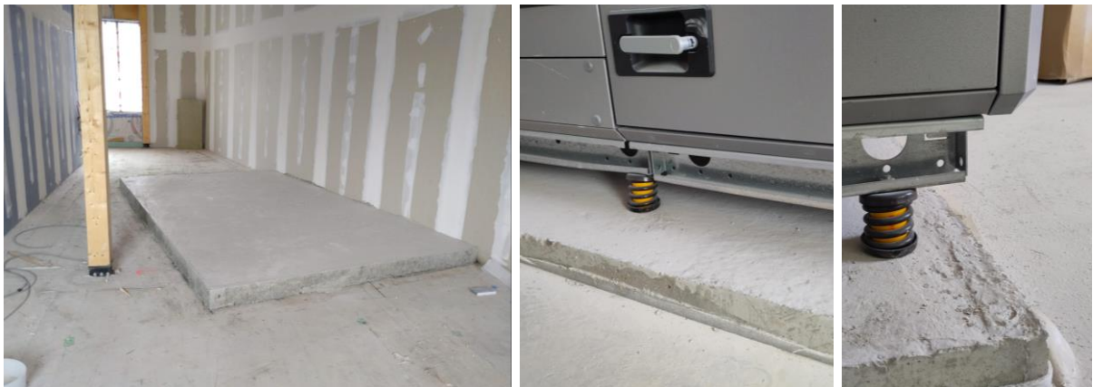
Figure 6 : Alourdissement en socle de CTA / Ressorts spécifiques sous CTA
