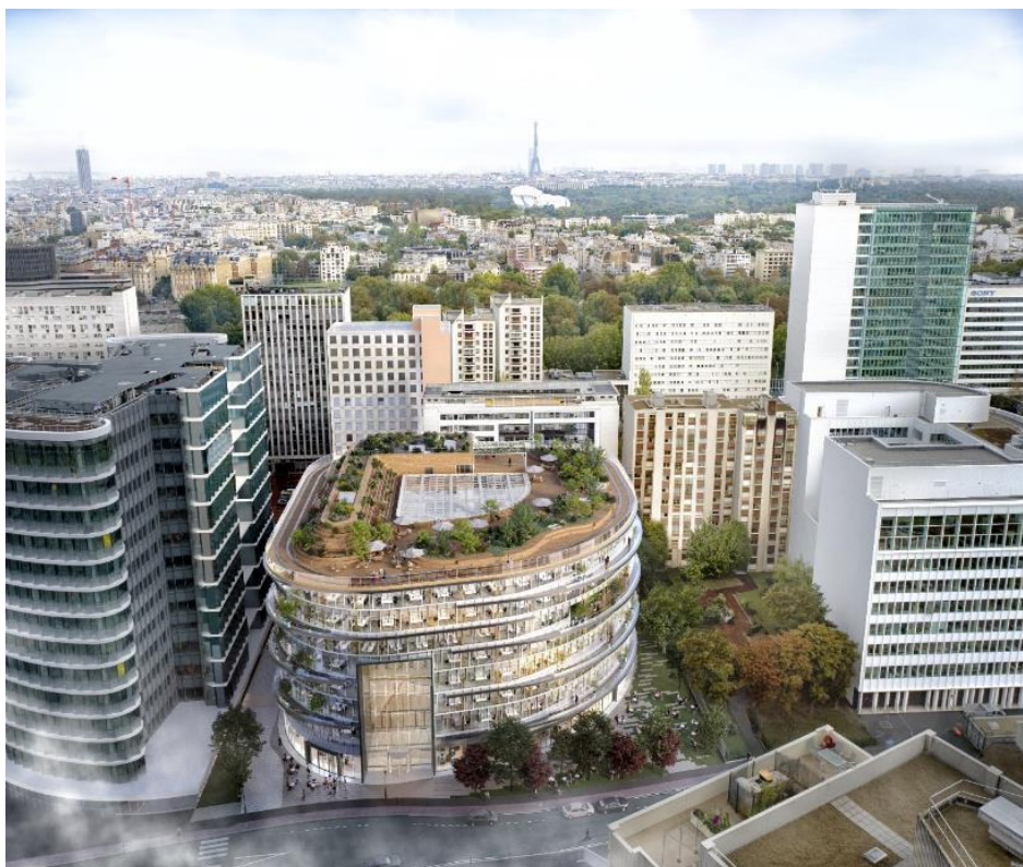
Une toiture-terrasse verdoyante de 1400 m 2 , véritable oasis urbaine pour La Défense ■ 2024 ■ ©Bechu & Associés
