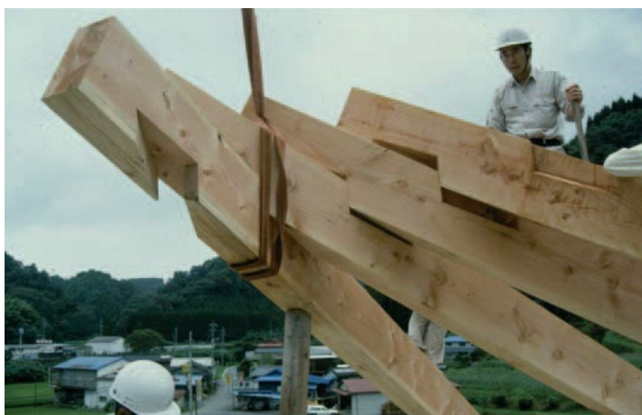
Image 10 : Détail d'assemblage à mi-bois de la charpente du hall d'exposition du Burnaku Puppet Theatre (crédit K. Ishii)
