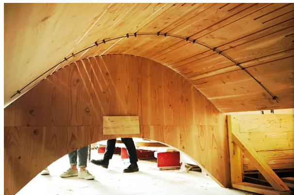
Cintrage avec les clavettes reliées par les tiges filetées ©ArtBuild
