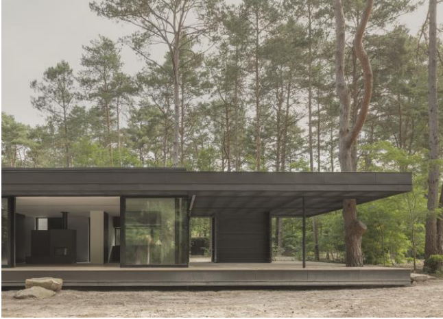
Image 8 : Vue vers la façade sud de la maison principale © Schnepf*Renou
