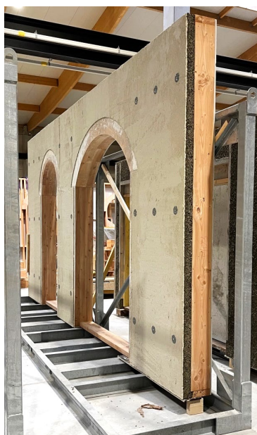
Image 2 : photo du mur sur chantier
