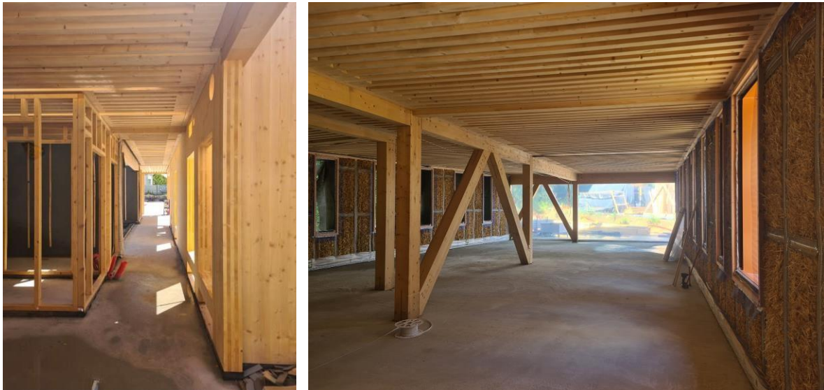
Image 6 : Porteurs CLT + Planchers
