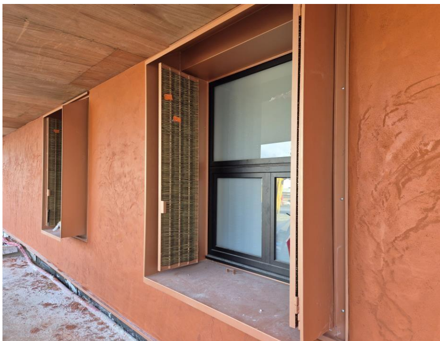
Image 9 : Enduits extérieurs à la chaux.
