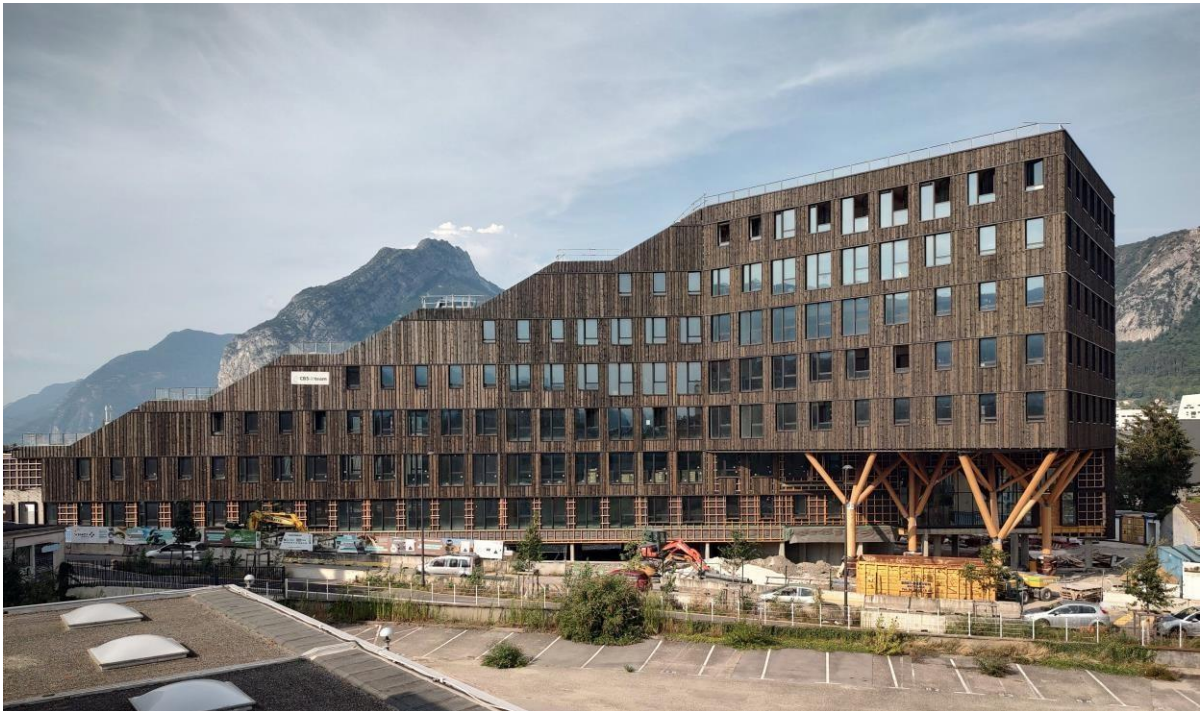
Image 1 : Photo de chantier
