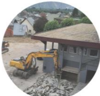
Démolition des extensions des années 1980
