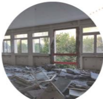
Barre existante : démolition de quelques allèges de fenêtres
