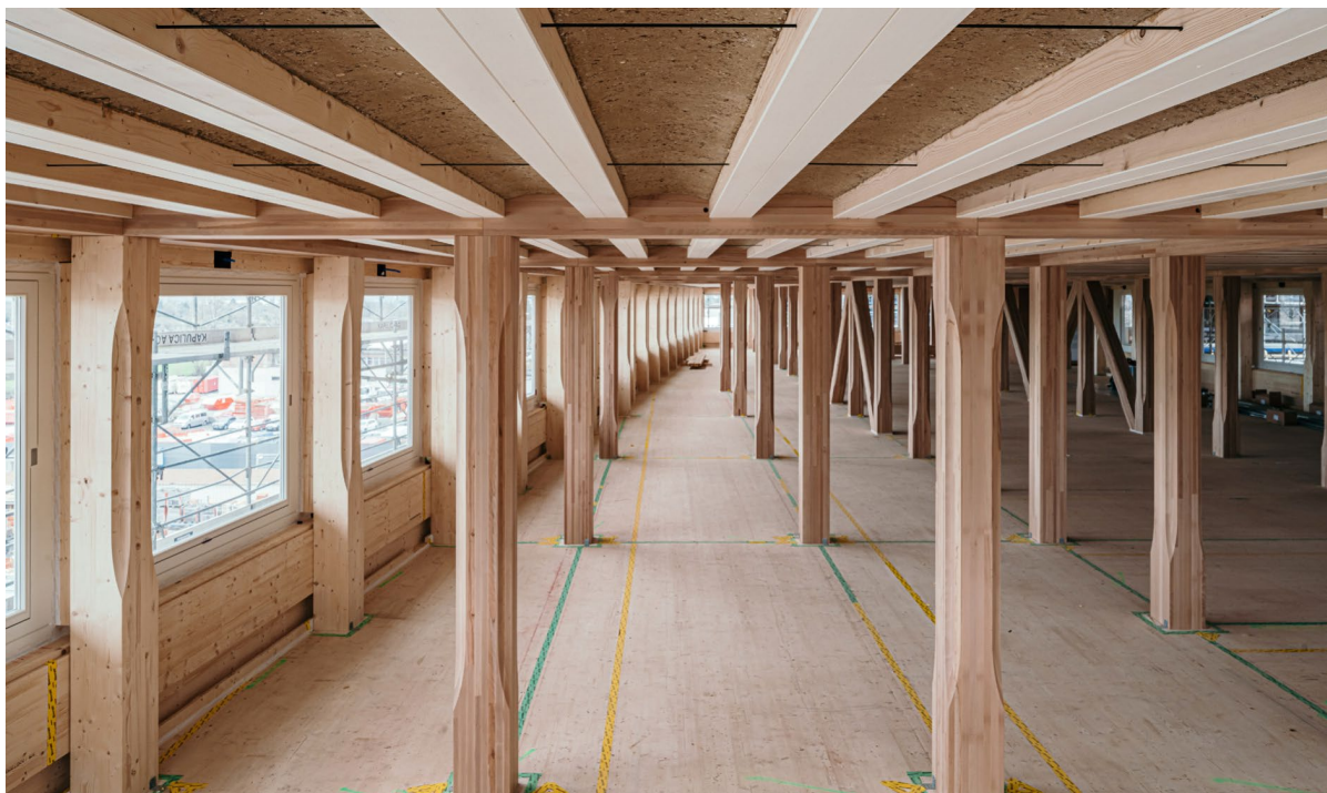
Image 1: Intérieur du chantier avec vue sur le plafond à voûtes en pisé et en bois – Hortus, Basel
