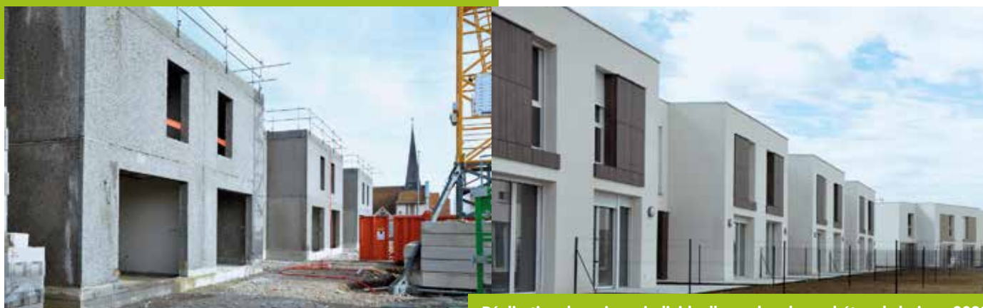
Réalisation de maisons individuelles en bandes en béton de bois en 2022
