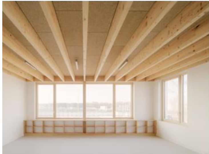
Figure 2 : Vue d'une salle avec structure du plancher apparente Crédits photo : Maxime Verret
