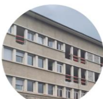
Façade barre existante : démolition de quelques allèges de fenêtres
