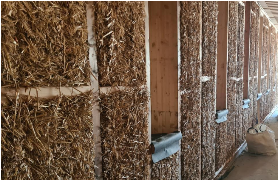
Image 7 : MOB Paille en attente de l'enduit de terre argileuse.
