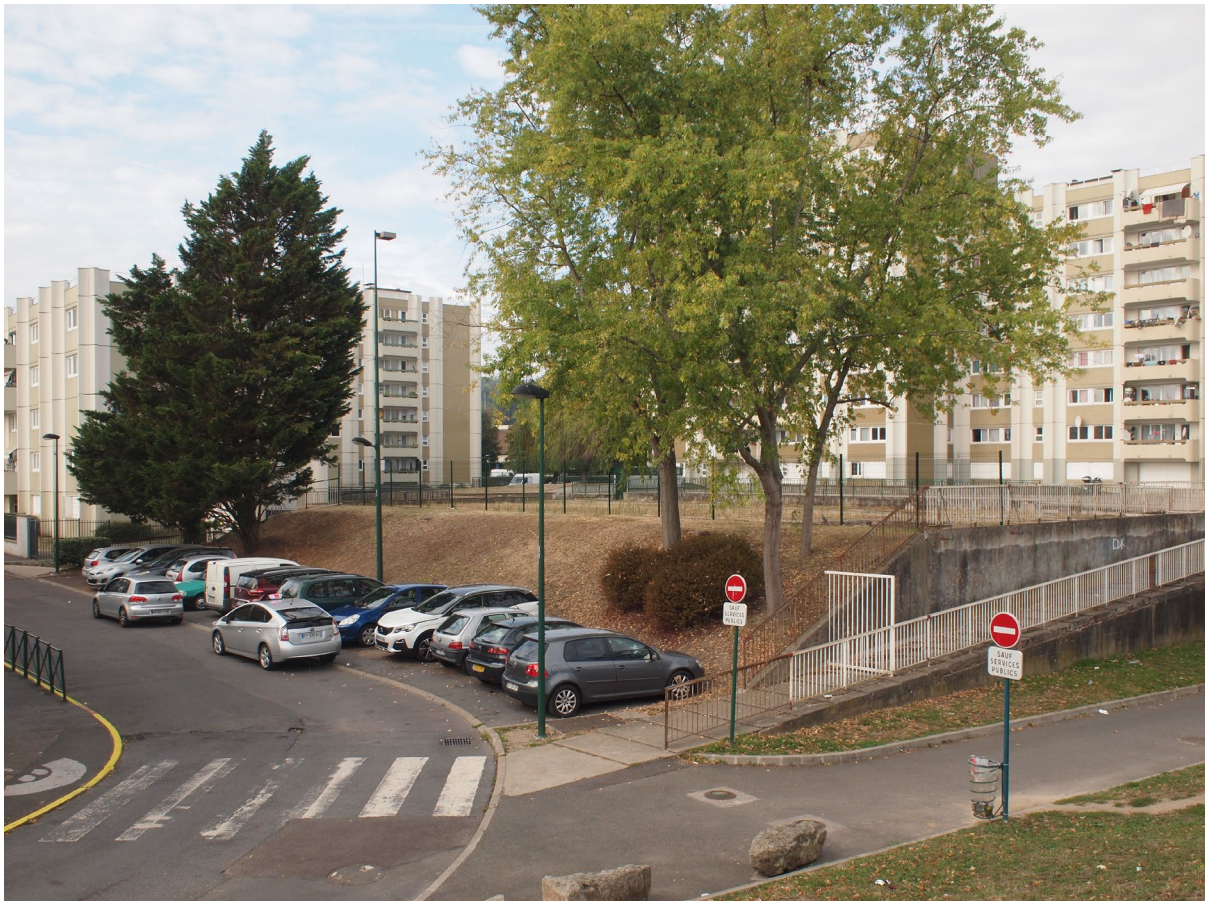
Image 1 : le site avant travaux (photo SCOP Atelier 15) – Le parking existant est semi-enterré derrière un talus. Sa surface est un délaissé urbain sans qualification.
