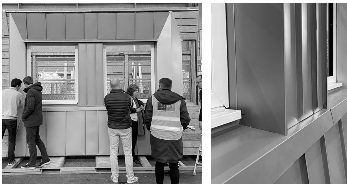
Image 6 : Validation du prototype réalisée à l'usine / Détails de finition du bardage aluminium à joint debout
