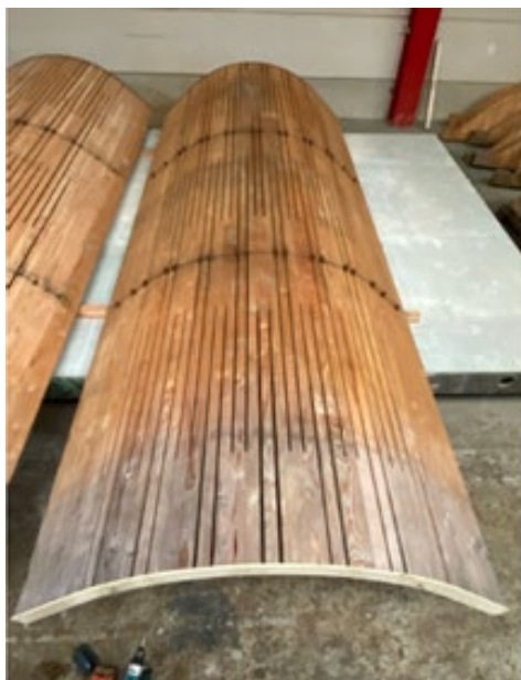
Panneaux CLT suite au stockage à l'aire libre, travail de nomenclature ©ArtBuild
