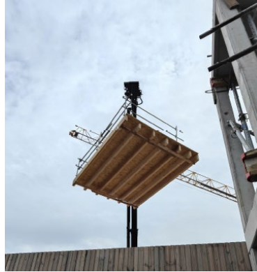
Plancher Pré fabriqué
