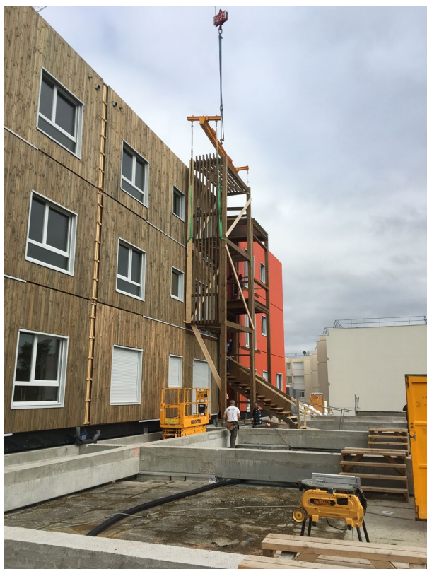
Image 6 : photo : SCOP ATELIER 15 – Mise en place d'un ensemble préfabriqué de loggias.
