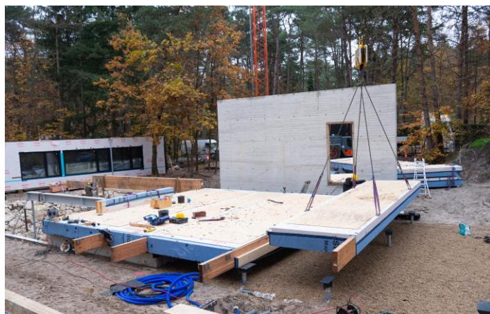
Image 7 : Pose des éléments en bois-paille © KARAWITZ
