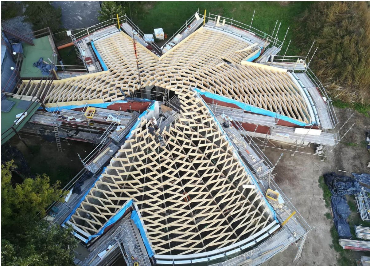
Image 7 : Vue aérienne de la charpente réciproque du Centre Frans Masereel en construction (crédit J. Verrecht)
