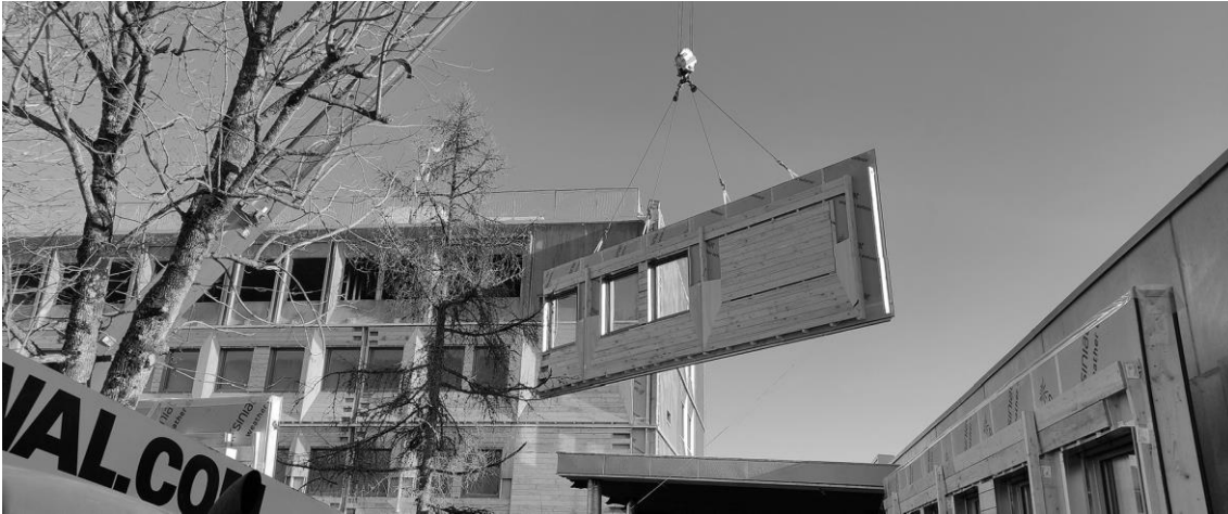
Image 7 : Pose à la grue mobile des Modules 2D de façade par l'entreprise SYface
