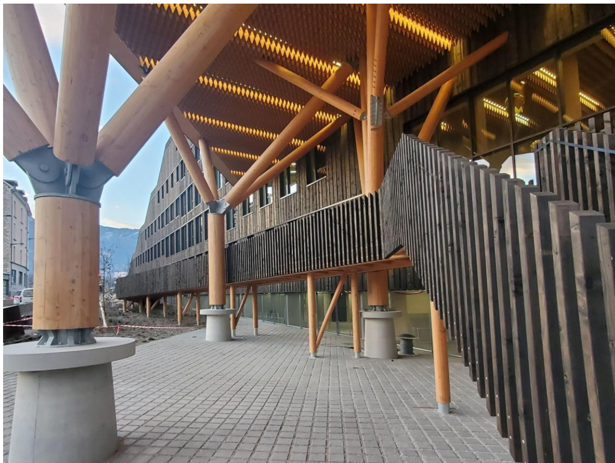
Image 3 : Photo de chantier
