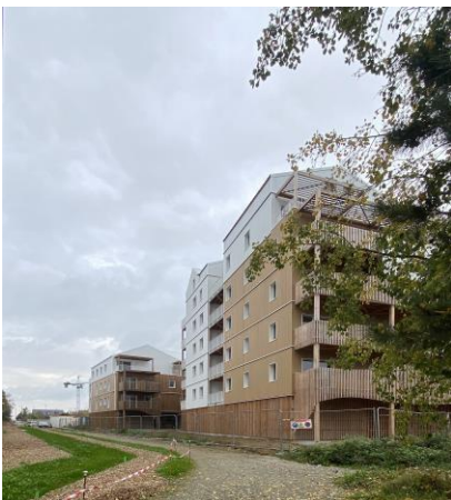
Vue du chantier
