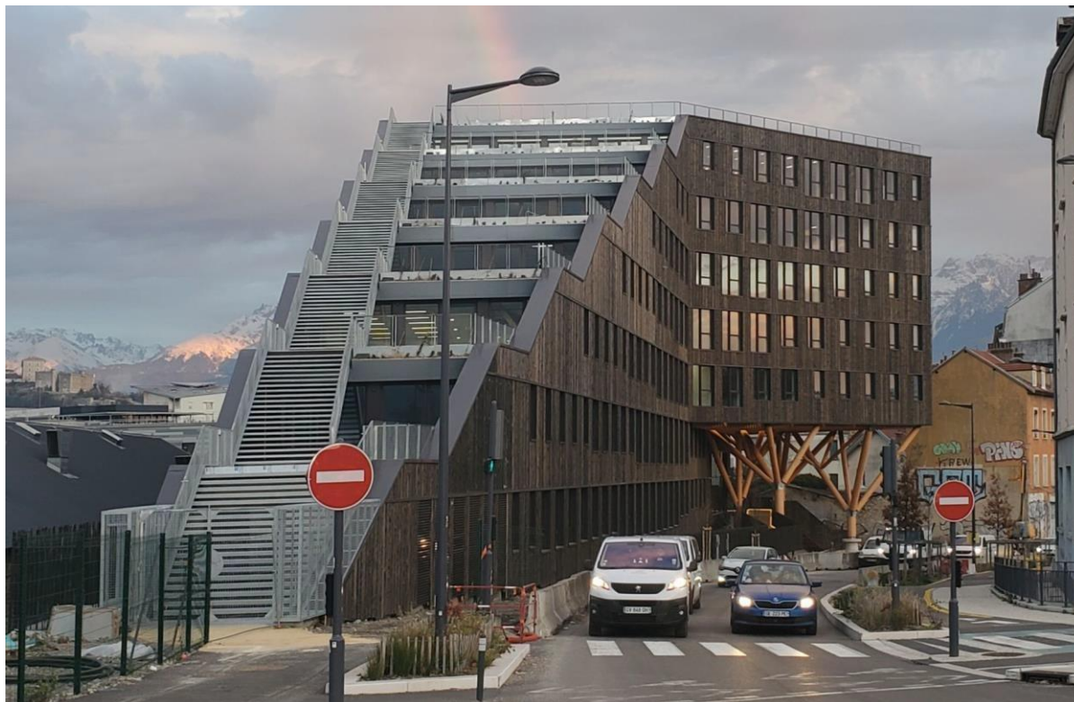
Image 2 : Photo de chantier
