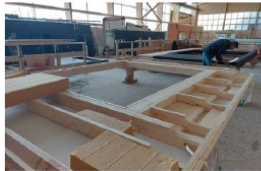
Préfabrication d'un mur ossature dans les ateliers // Pyrénées Charpentes
