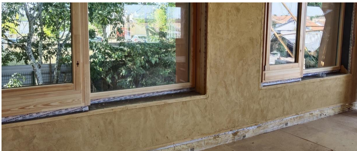
Image 4 : Face intérieure des façades en enduit de terre argileuse pour l'inertie thermique.
