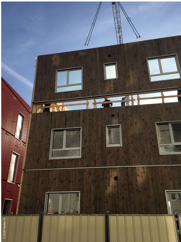
Image 5 : photo : SCOP ATELIER 15 – Levage de murs SYBOIS préfabriqués en usine.
