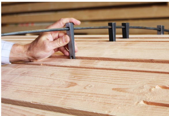
Insertion des clavettes biseautées dans les rainures ©ArtBuild
