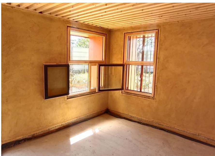
Image 10 : Enduits intérieurs en terre argileuse
