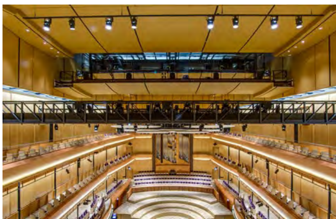
Image 4 : Stavanger Konserthus, Ratio Arch. : Plafond réfléchissant mobile composé de 8 éléments pesant chacun 30 tonnes – © Dirk Schoenmaker
