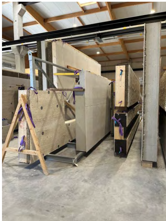
Montage de la structure et des panneaux en béton de chanvre préfabriqués (crédit photo Laps Architecture)
