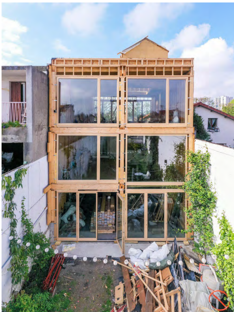
Figure 8 : Façade coté jardin durant les travaux (Antoine Duhamel)
