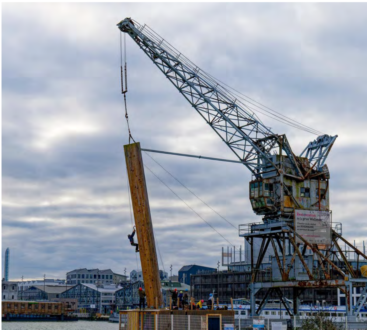
Une première mondiale : la voie de Cascade de bois Grue Wellman Bordeaux Bassin à flot – crédit @ Yannick Leblond
