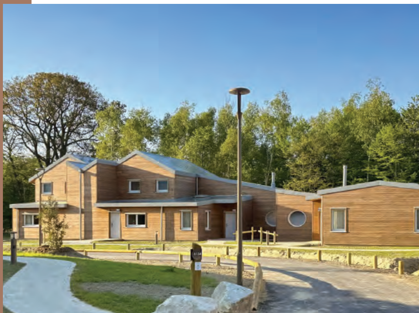
242 cottages réalisés en solution hors-site 2D à Bailly Romainvilliers
