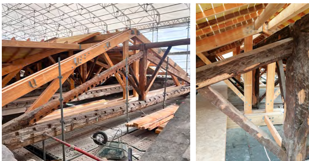
Image 6 : La cohabitation entre les fermes neuves et les fermes existantes de l'aile Nord
