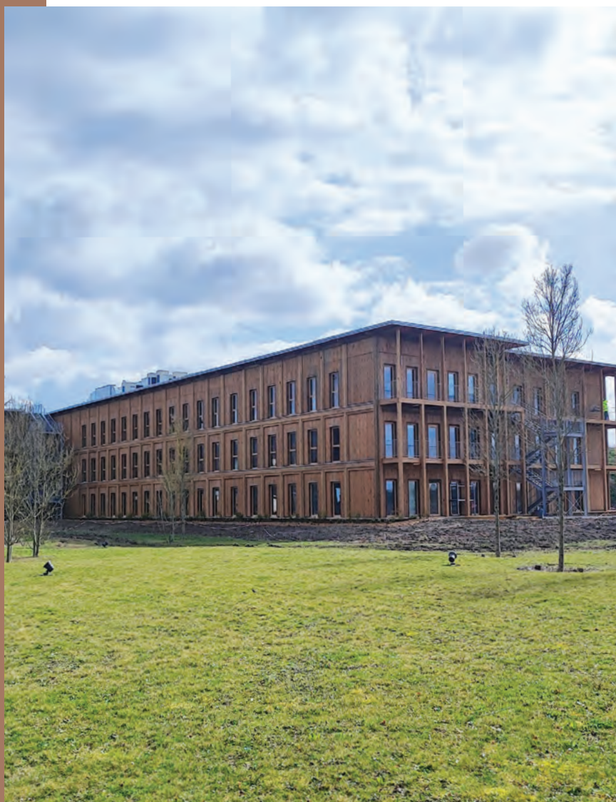
Bâtiment de bureaux réalisé en solution hors-site 3D à Cognac
