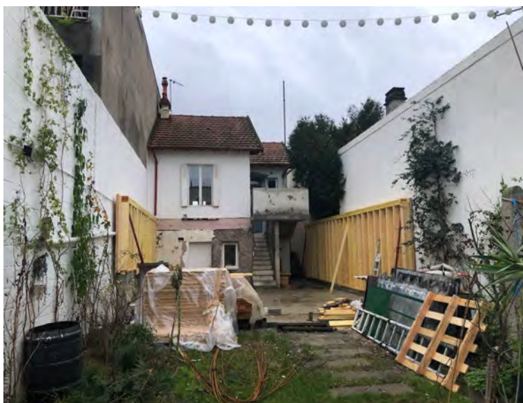
Figure 9 : Maison existante coté jardin durant les travaux (Benjamin Loiseau)
