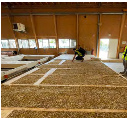
Préfabrication des modules de façade
