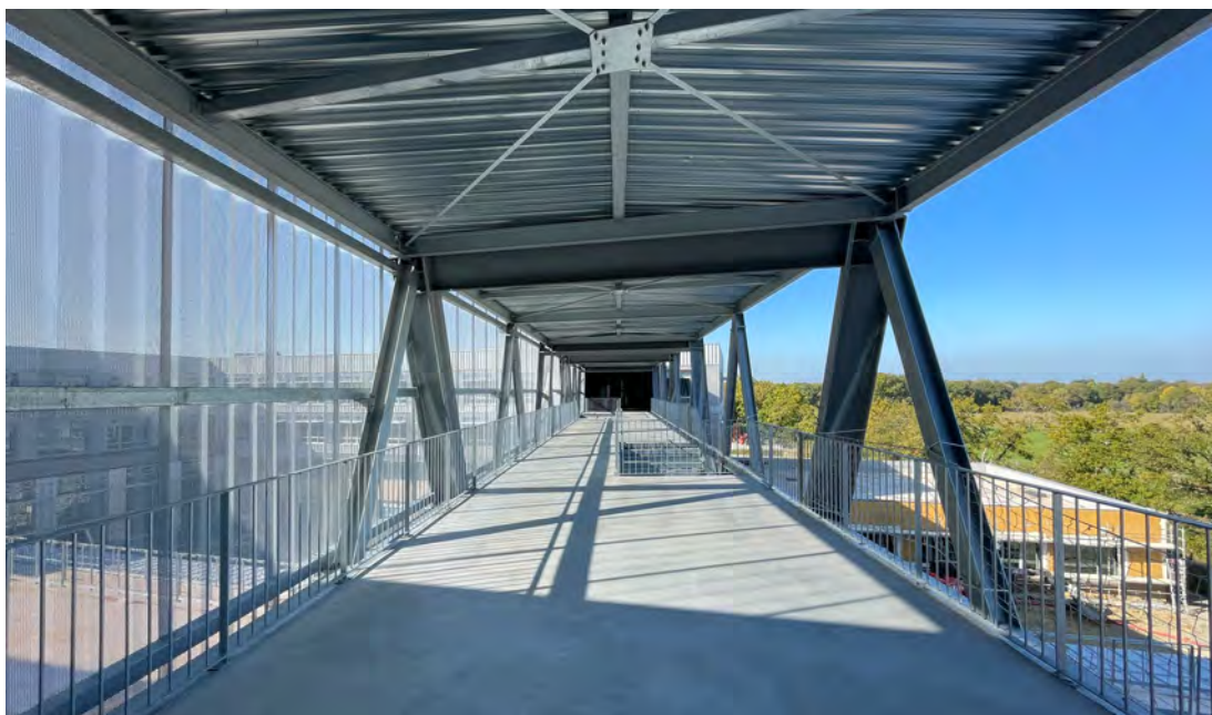
Vue depuis la passerelle
