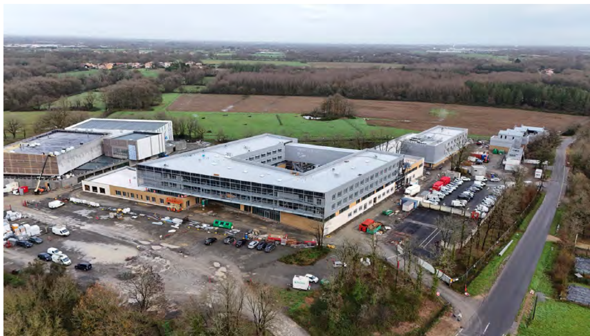
Vue aérienne du lycée
