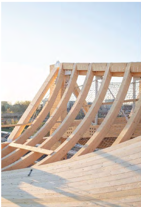
Mise en OÈuvre du double voligeage, @ Duboys Fresney
