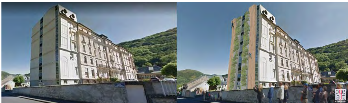
Mur pignon existant Le Mont Dore Auvergne (63)
