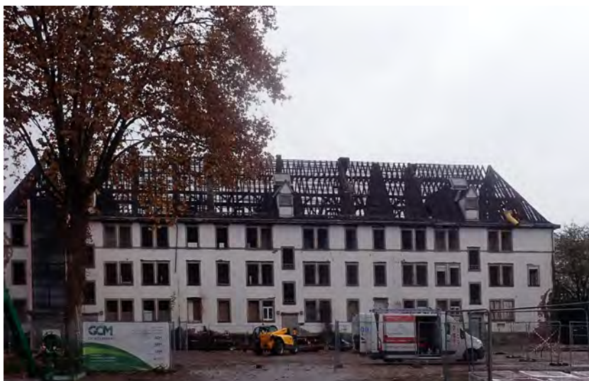
Déconstruction de la charpente © nunc architectes
