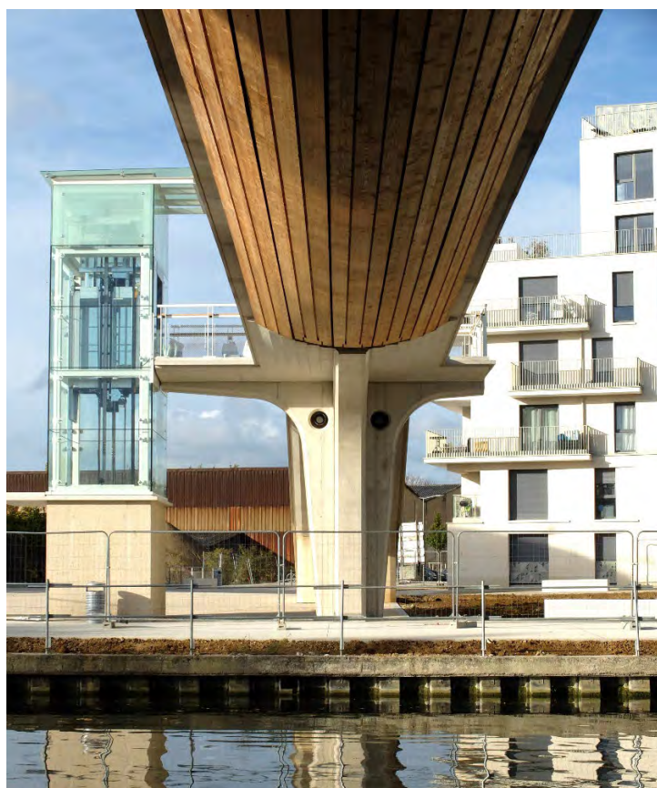
Fig. 2. Sous-face de la passerelle vue depuis le Quai Sud
