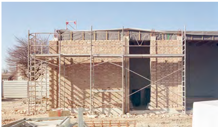
Construction d'un mur brique sur l'aile logistique © Guillaume Porche
