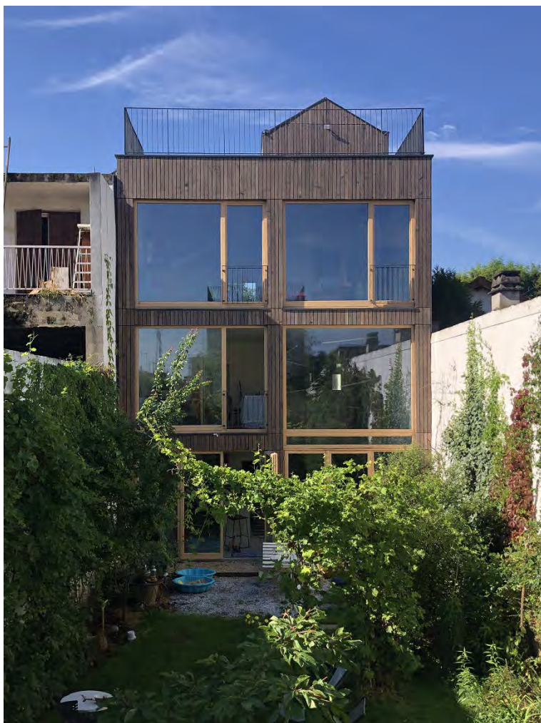
Figure 1 : façade du cours (Benjamin Loiseau)
