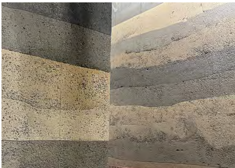
Image 7 : Le béton stratifié du voile du Rez-de-jardin faisant écho aux galeries souterraines
