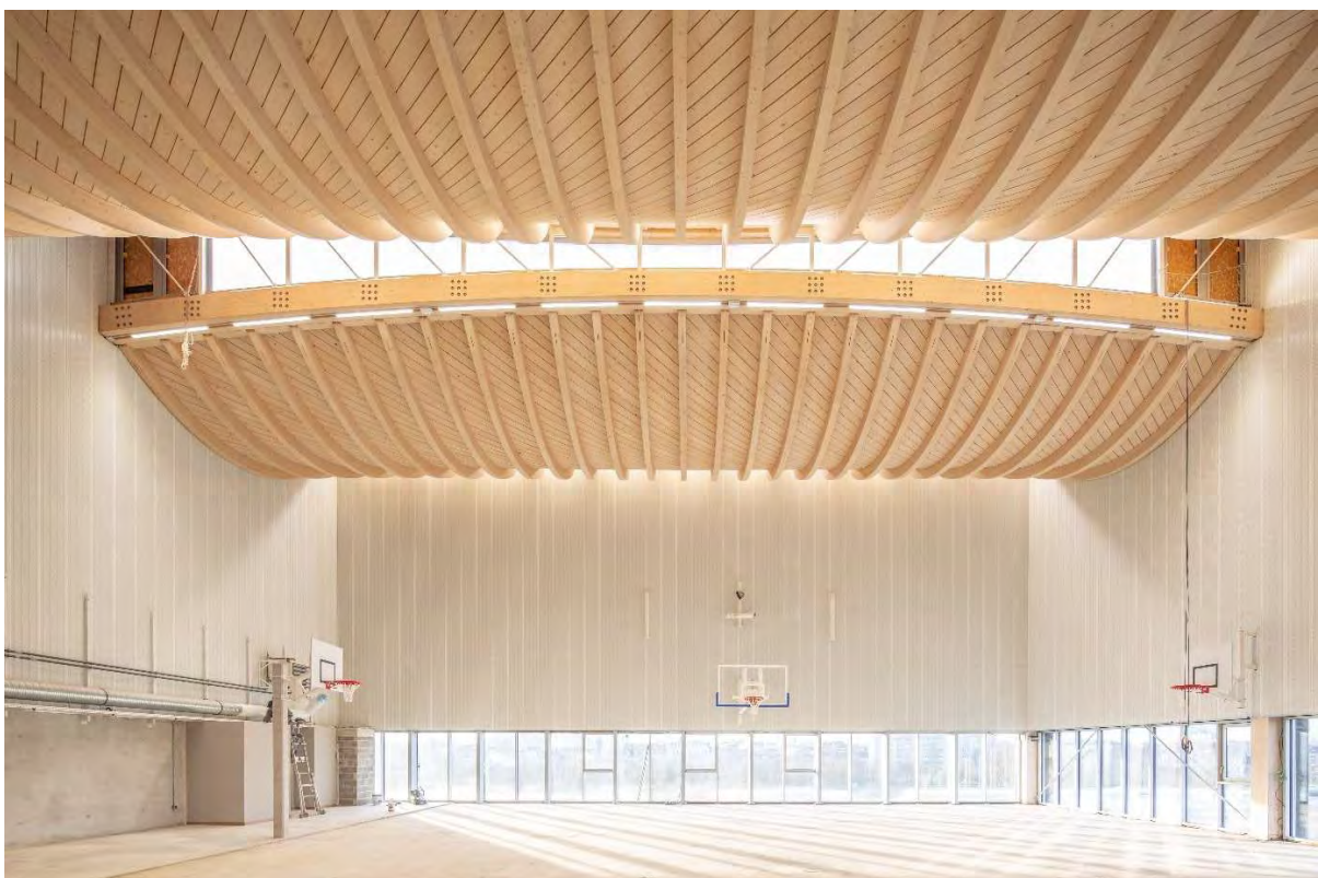
Vues intérieures de la salle multisport, en cours de chantier, @ Duboys Fresney
