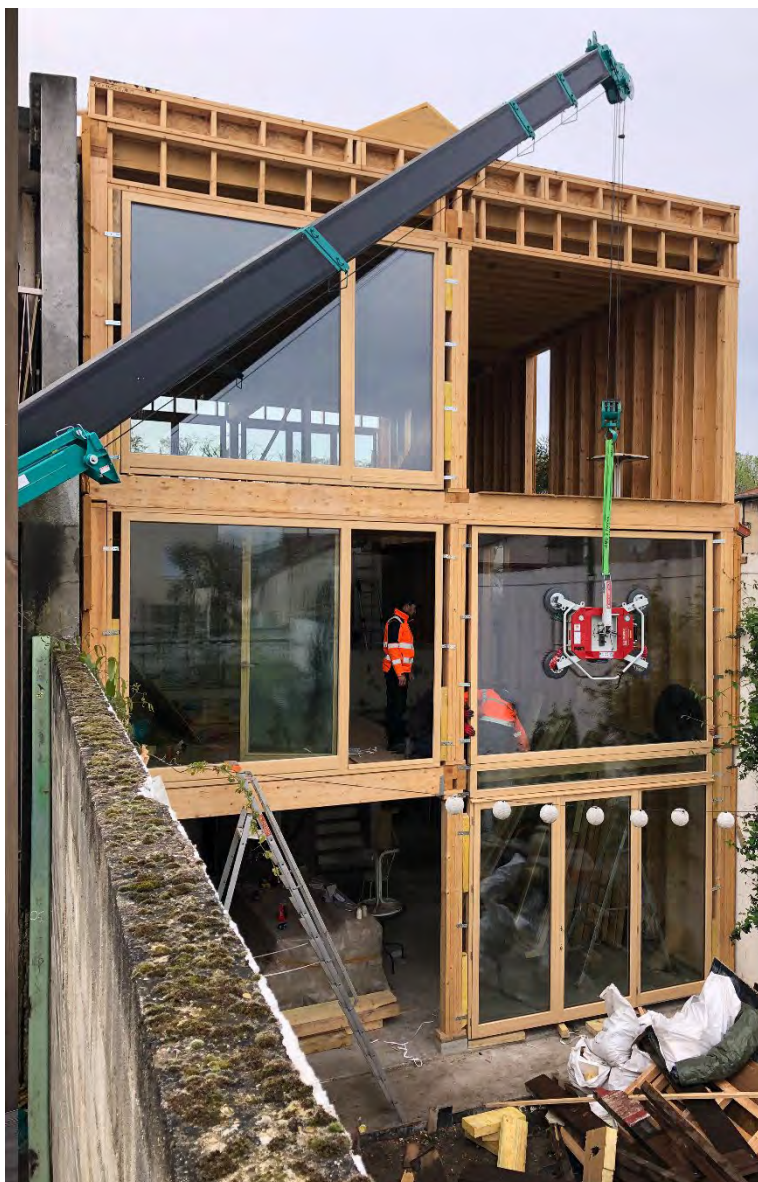
Figure 7 : Mise en place des menuiseries (Benjmain Loiseau)
