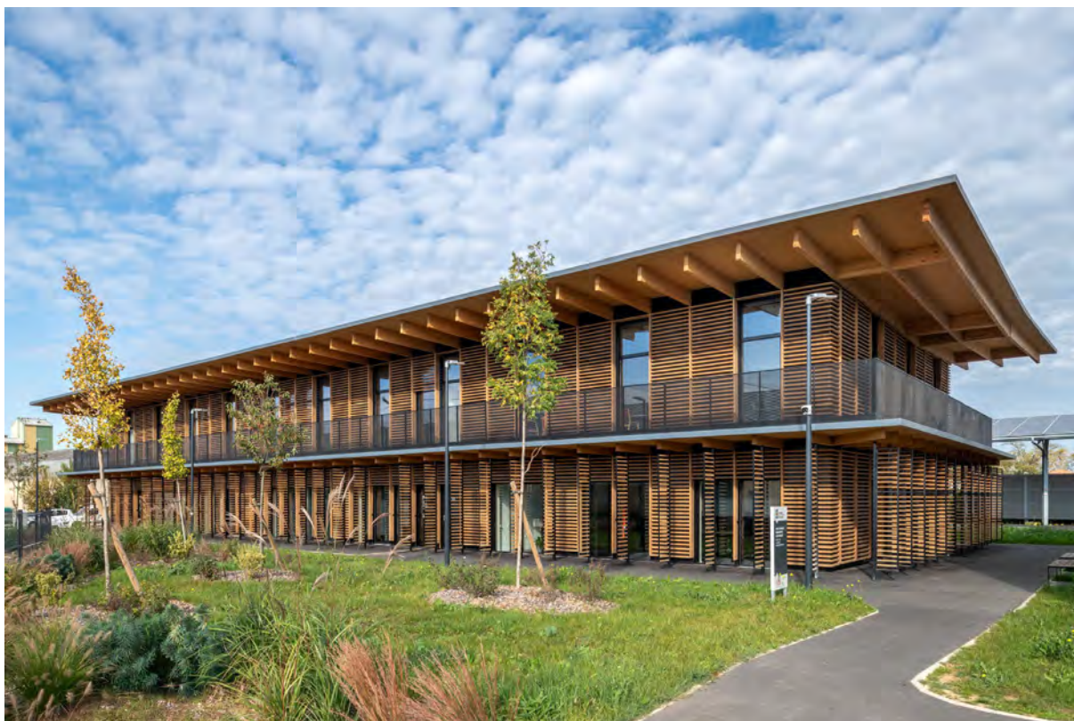
Bâtiment administration – Photo : ©Jean-François Tremège
