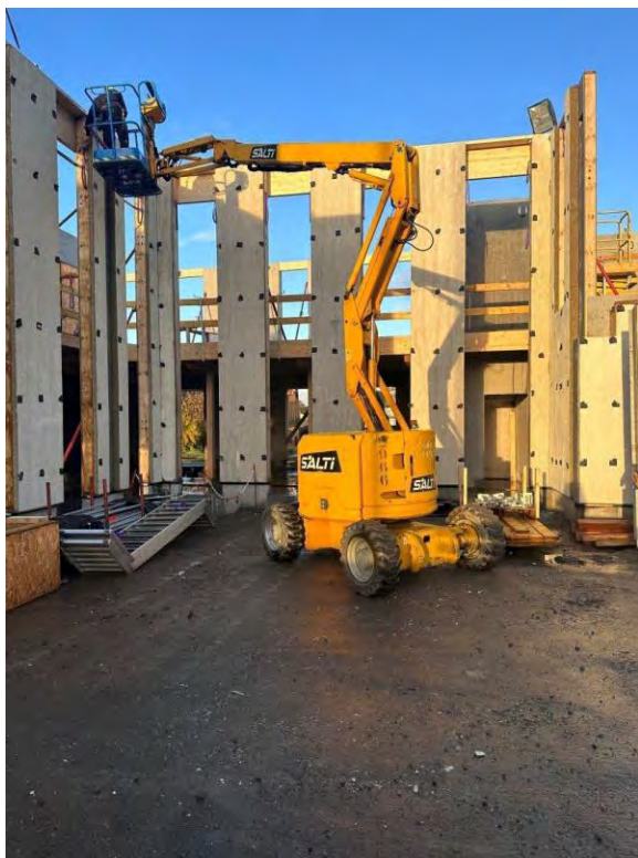
Montage de la structure et des panneaux en béton de chanvre préfabriqués (crédit photo Laps Architecture)
