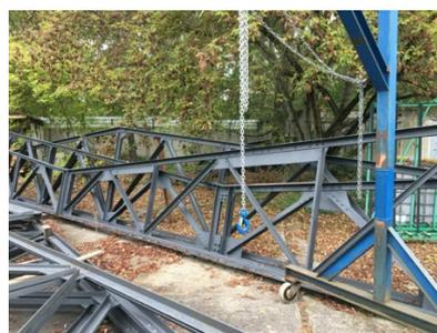
Abbildung 15: aufgearbeitete Träger
