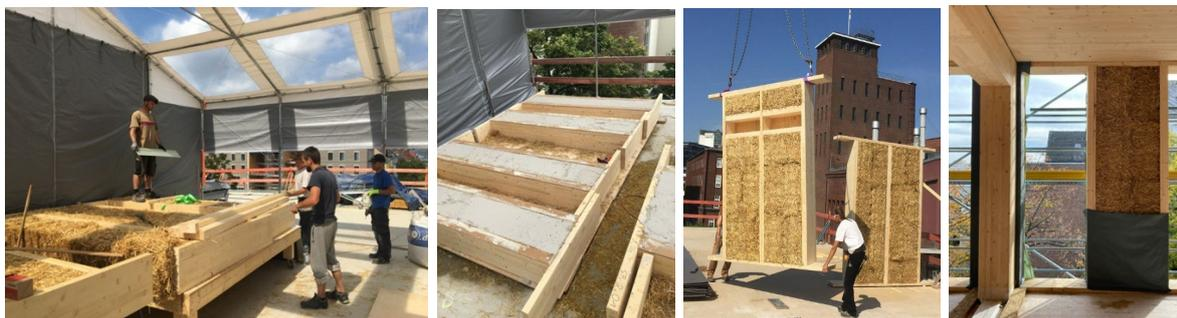
Abbildungen 21: Vorproduktion und Montage der Strohballenwand
