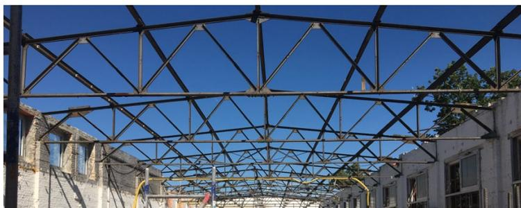
Abbildung 14: Demontage Dachtragwerk
