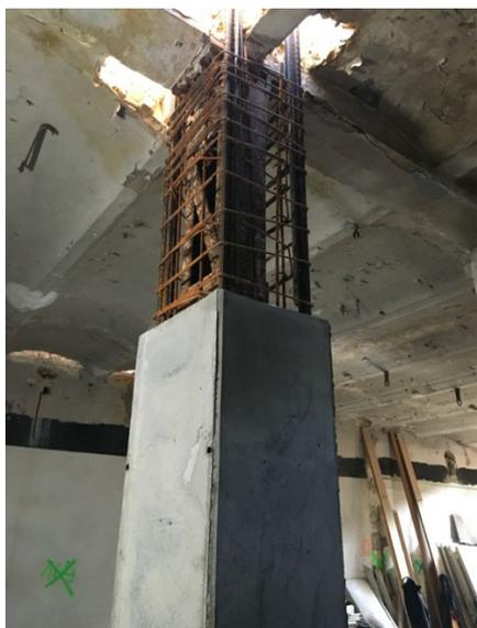
Abbildung 5: alter Stahl / neuer Beton
