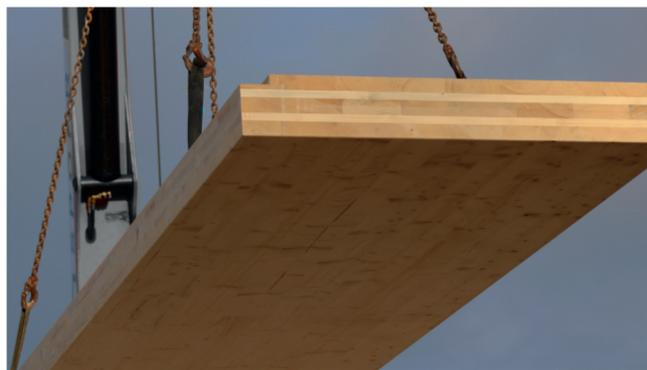
Als Hersteller von Brettsperrholz bietet HBS großformatige Massivholzelemente welche als Wand-, Decken- und Dachbauteile eingesetzt werden können.
