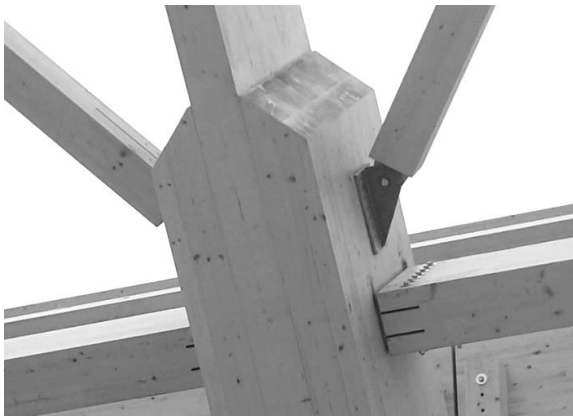
Abbildung 19: Mactan Cebu Airport, Sekundärträger und Diagonalanschluss, Fotos: RUBNER Holzbau
