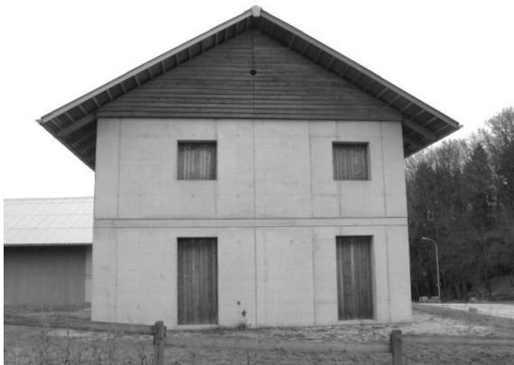
Abbildung 3: Unbehandelte Stülpshaltung - Fichte (westexponiert), nach 5 Jahren Bewitterungszeit, die erwartete Vergrauung ist relativ gleichmässig abgesehen vom Einfluss des Vordaches (Volkmer und Höltschi 2008)
