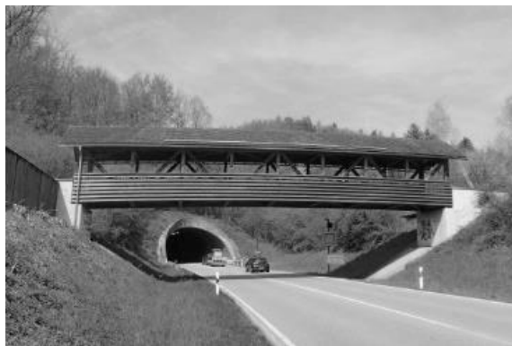
Abbildung 27: Brücke bei Schopfheim mit nachgerüstetem seitlichen Wetterschutz, Quelle: RP Freiburg
