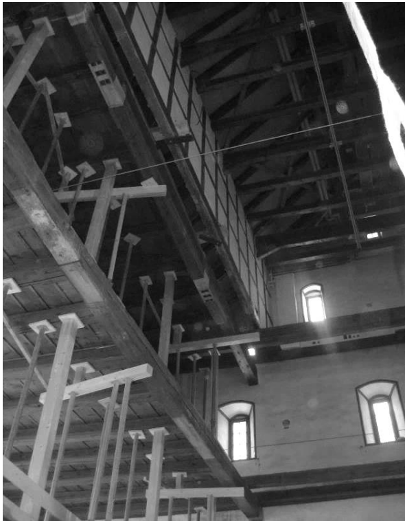
Abbildung 12: Abfangung Riegelwand 4. OG
