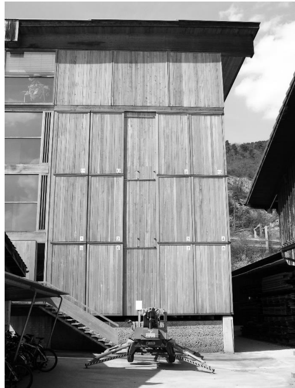
Abbildung 6: Südseite der Fachhochschule in Biel nach 9 Jahren Bewitterung und anschließender Reinigung
