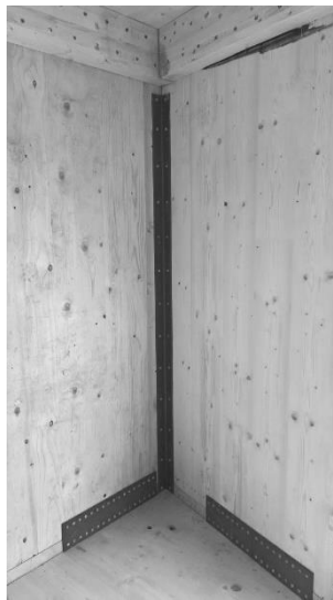
Realisierte Verbindungen mit Winkelprofilen und Lochblechen
