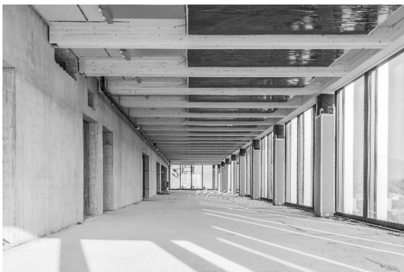
Abbildung 19: Rohbau vor dem Ausbau
