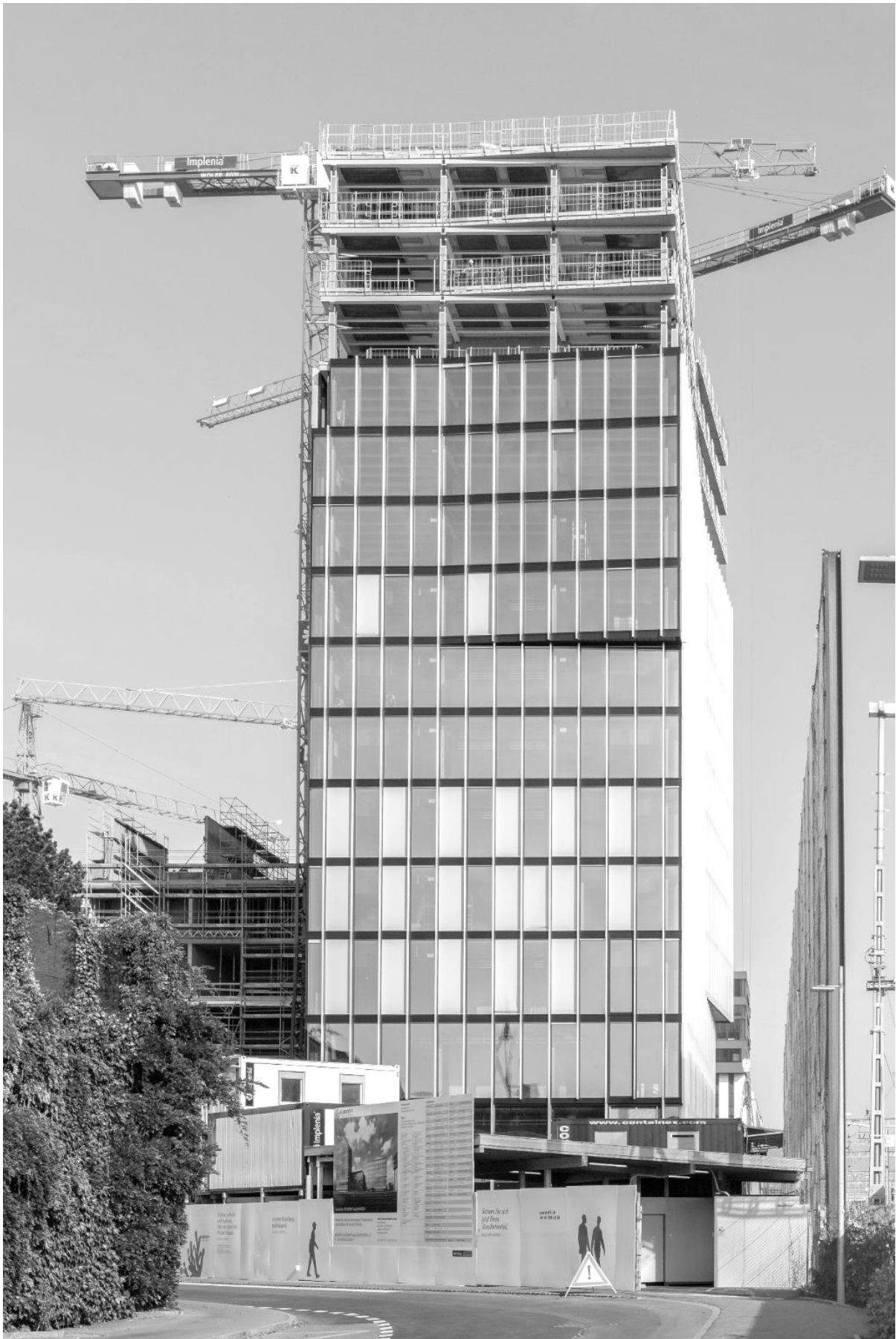
Abbildung 20: Suurstoffi BF1 fertig aufgerichtet mit der um drei Geschosse nachgezogener Metall-Glasfassade.
