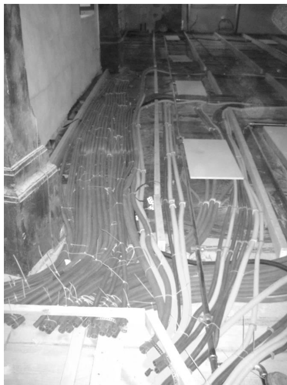
Abbildung 19: Installationen in Deckenhohlraum
