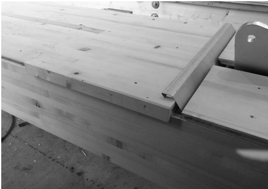
Montage konstruktiver Holzschutz (Verkleidung) an den senkrechten Stützen im Werk
