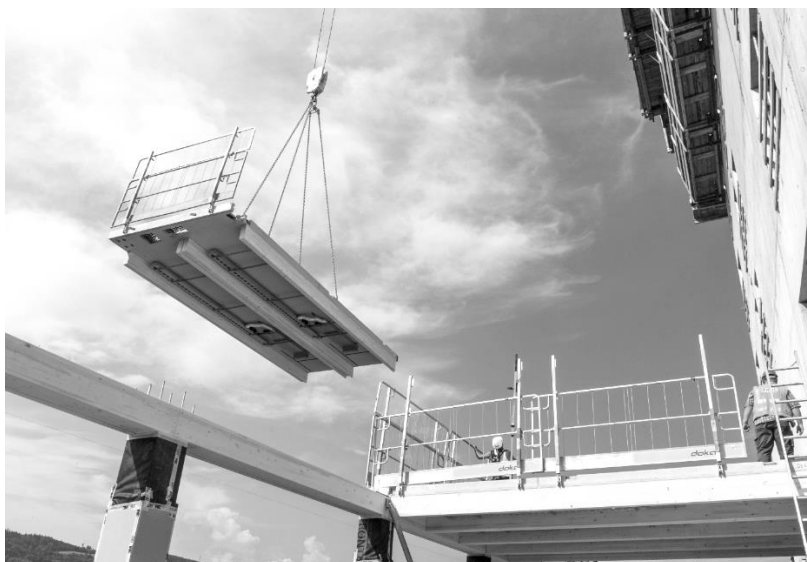
Abbildung 18: Montage des Holzbaus – mit den vormontierten Absturzsicherungen
