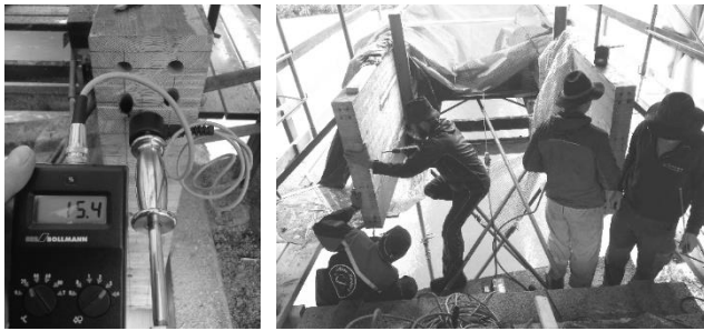
Kontrolle beim Einkleben der Bewehrung
