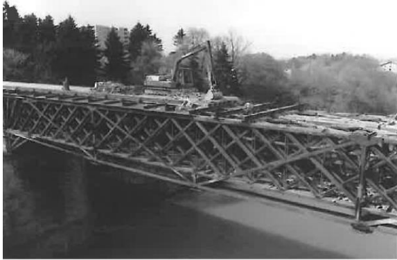
(a) Abräumen der Fahrbahn
