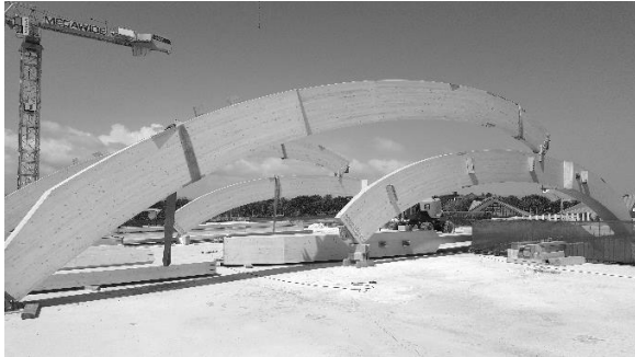
Abbildung 17 und 18: Mactan Cebu Airport, Trägermontage, Fotos: RUBNER Holzbau
