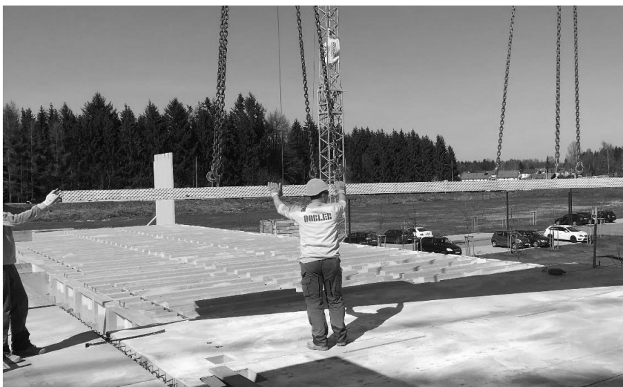
Abbildung 6: Richten einer HBV-Decke mit Balken und Betonfertigteil
