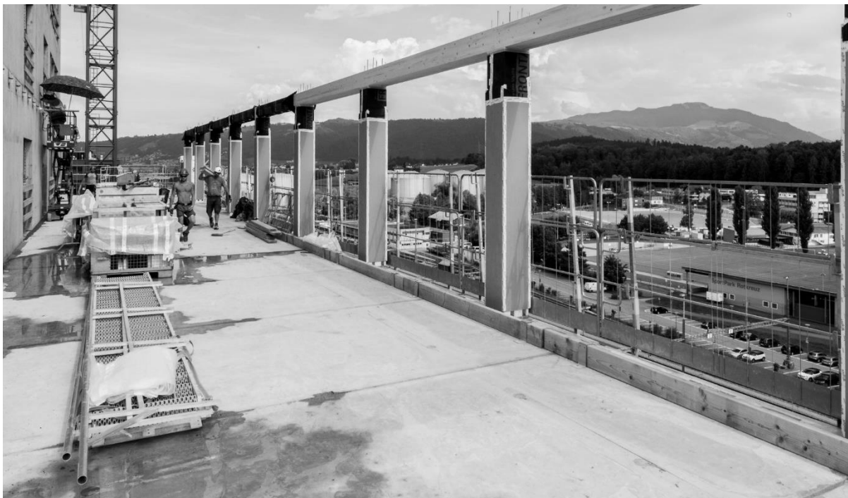
Abbildung 14: Witterungsschutz: dichte oberste Ebene (Überbeton) kombiniert mit einem Bauteilschutz.
