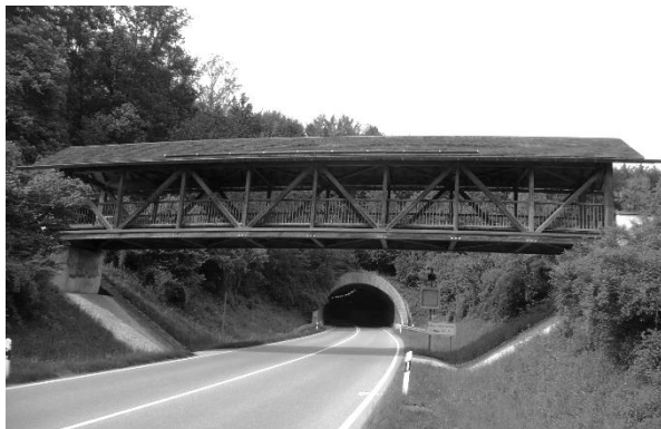
Abbildung 26: Überdachte Brücke bei Schopfheim, Quelle: RP Freiburg
