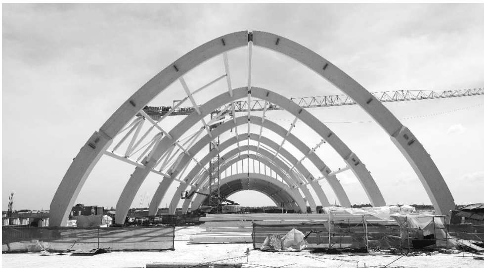
Abbildung 20: Mactan Cebu Airport, Fotos: RUBNER Holzbau
