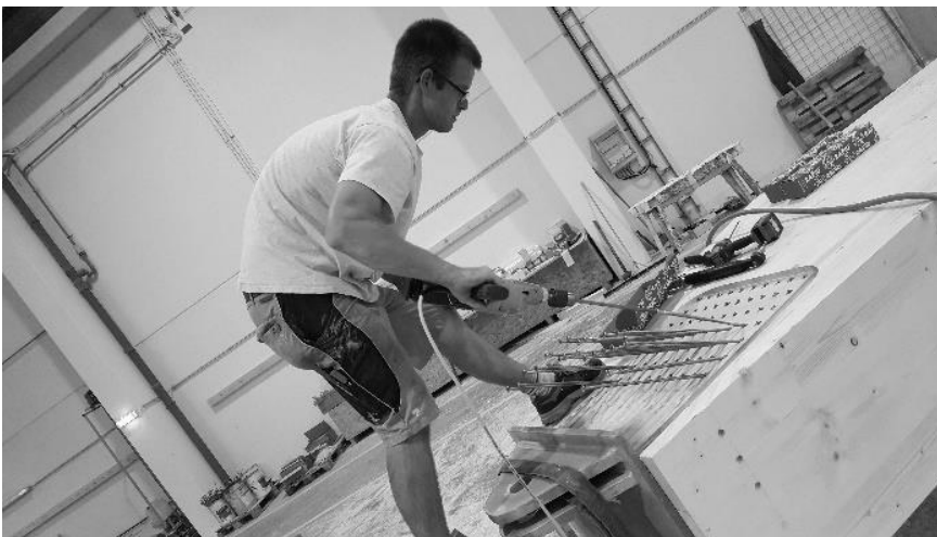
Abbildung 7: Mactan Cebu Airport, Einbau Fußgelenke, Foto: RUBNER Holzbau
