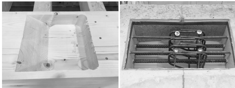
Abbildung 7: Aussenwandunterzug mit Fotos der Kervenverbindung
