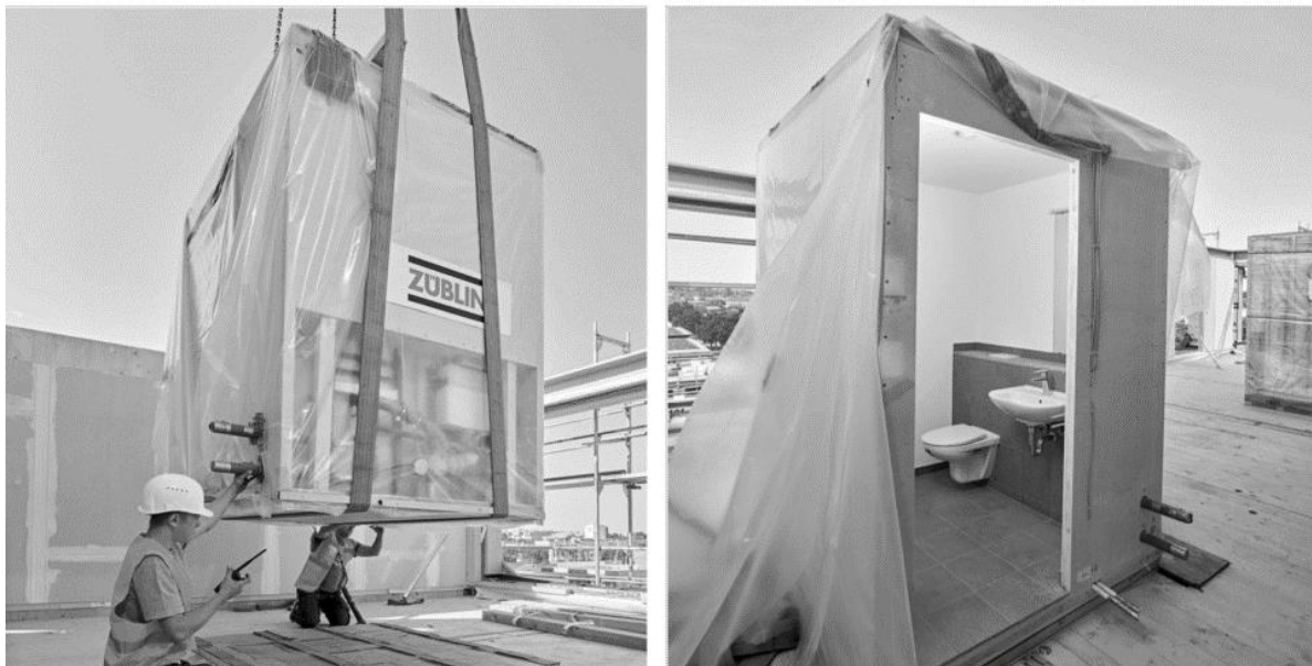
Abbildung 5: Badmodule mit Wänden aus Holz-Verbundwerkstoff
