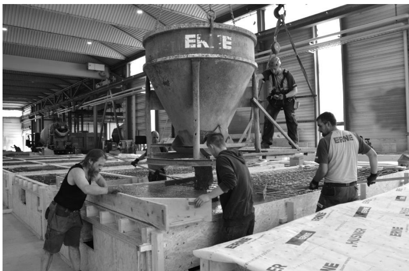
Abbildung 17: Betonieren der Betonelemente im Werk
