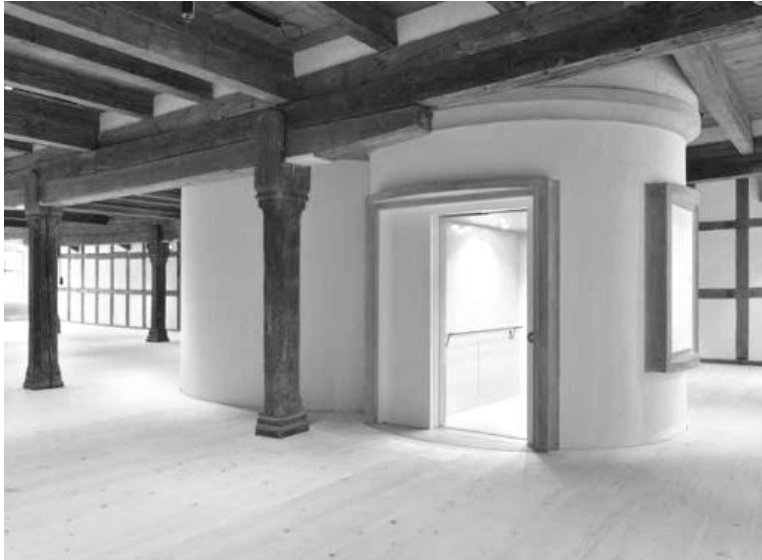
Abbildung 2: Neuer Treppenturm und Liftanlage
