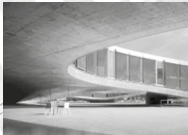
Sonderschalung Special Formwork
