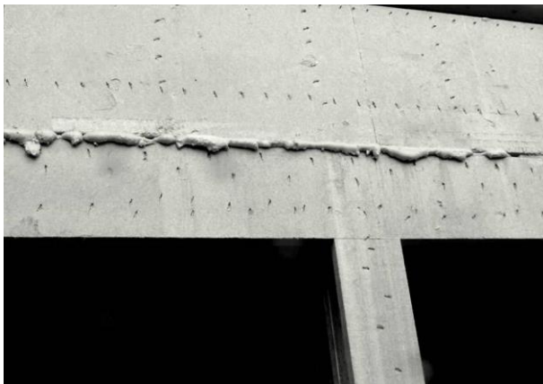
Abbildung 2: Anschlussfuge mit Schaum ausgefüllt
