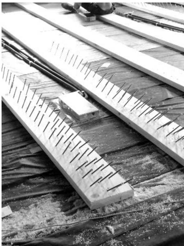
Abbildung 18: Ertüchtigung Balkenlage
