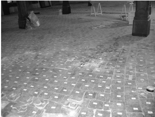
Abbildung 10: Nummerierung Tonplatten vor Ausbau
