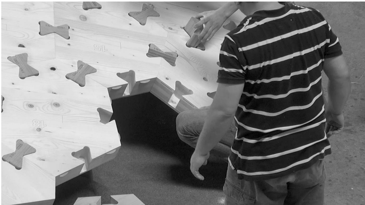
Abbildung 1: Aufbau des ersten Timberdome Prototyps, Innovation Area Holzmesse Klagenfurt 2018.
