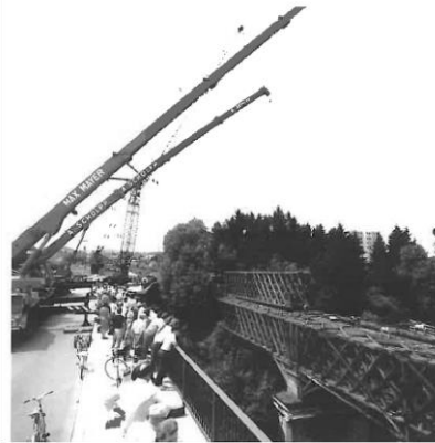
(b) Ausheben der Träger
