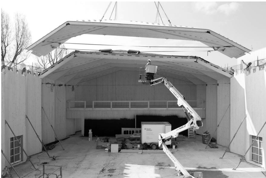
Abbildungen 13 und 14: Die Wand und Dachelemente werden auf der Baustelle baukastenartig zusammengesteckt.
