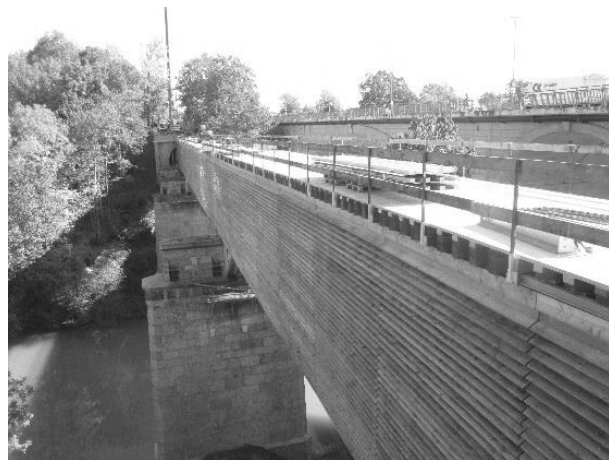
Abbildung 19: Außenansicht der Brücke vor Fertigstellung der Fahrbahn
