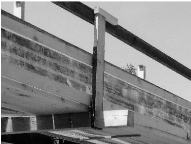
Trägersanierung d. Einkleben von neuem Holz
