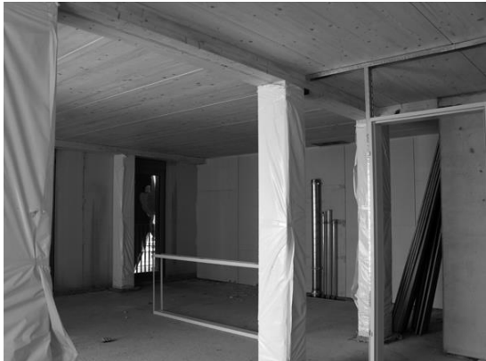
Abbildung 10: sichtbare BSH Decken
