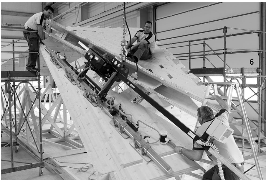
Abbildung 12: Manpower wurde benötigt beim Zusammenbau der Dachelemente in der Halle
