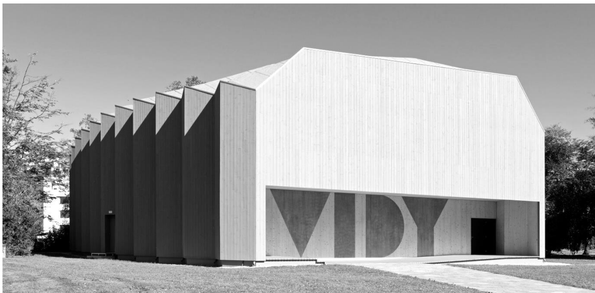
Abbildung 15: Nach Abschluss aller Fertigstellungs- und Ausbauarbeiten wurde der Pavillon am 11. September 2017 mit einer Ausstellung eröffnet
