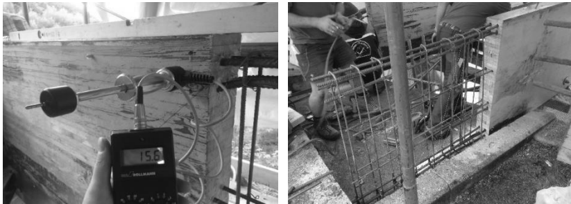
Eingeklebte Stahl-Bewehrung für Betonprothesen
