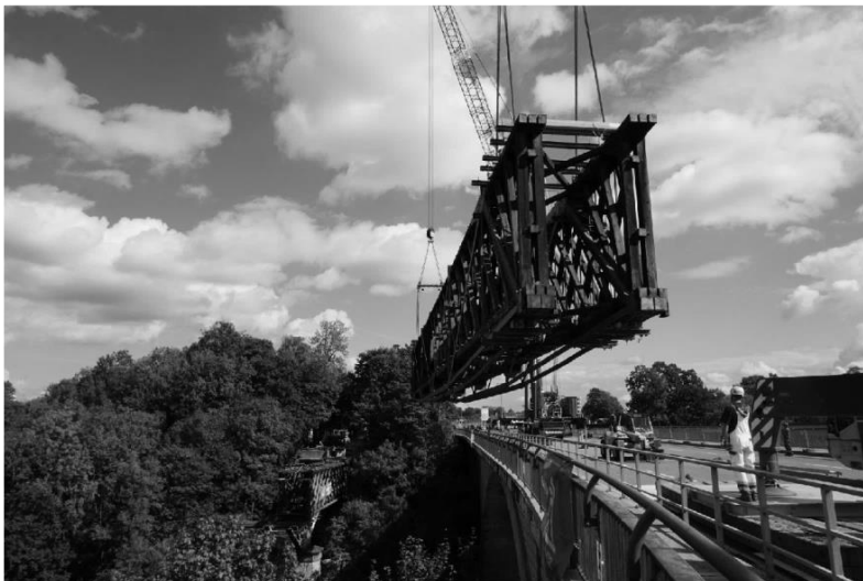
Abbildung 16: Aushubvorgang des mittleren Felds
