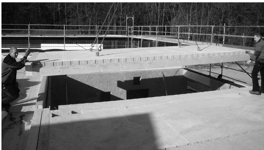
Abbildung 7: Richten einer HBV-Decke mit Holzelementen als Vollfertigteil
