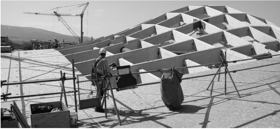
Abbildung 12: Zwei ebene, dreieckige Hohlkasten-Dachelemente füllen je ein «windschiefes» Gitterfeld. Die dabei entstehenden, facettierten Oberflächen wirken aufgrund der Größe des Gitterrasters dennoch fließend und bilden alle Schwünge der Dachfläche formschön aus. ©WIEHAG
