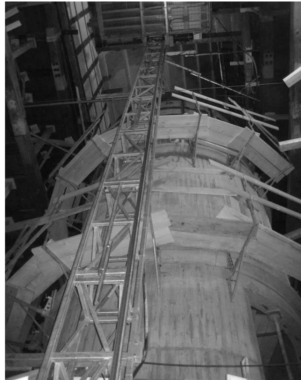
Abbildung 13: Treppenhausöffnung bis Dach
