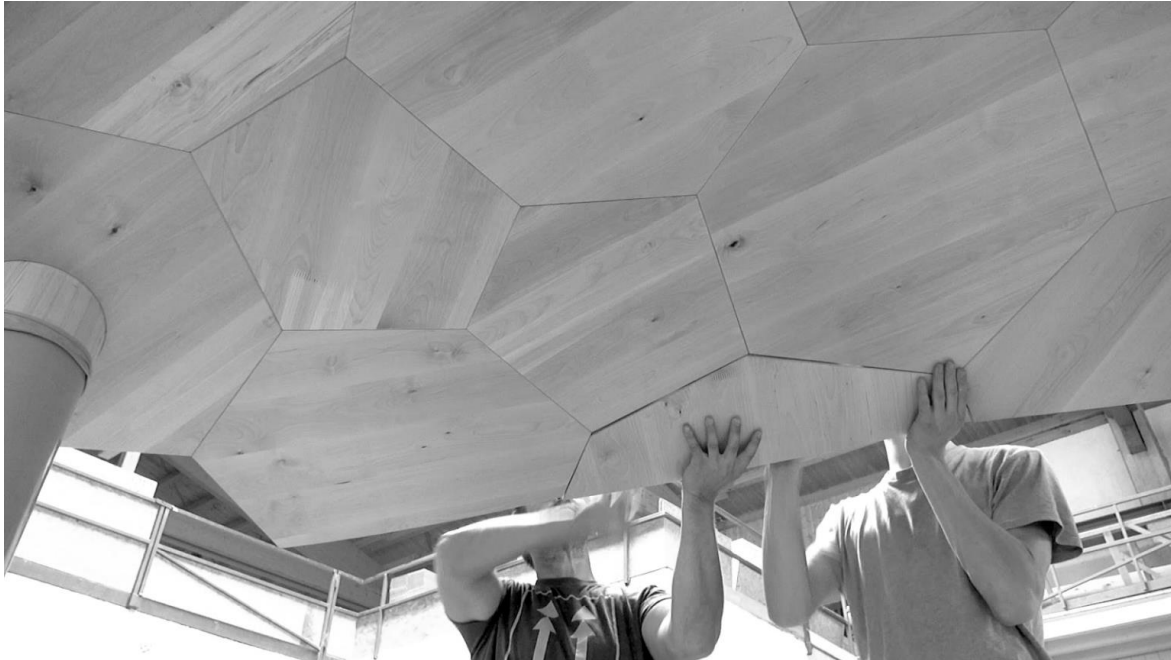
Abbildung 6: Fügung der Bauteile beim Testaufbau / Innenansicht der Konstruktion mit Exzellentoberfläche Birke
