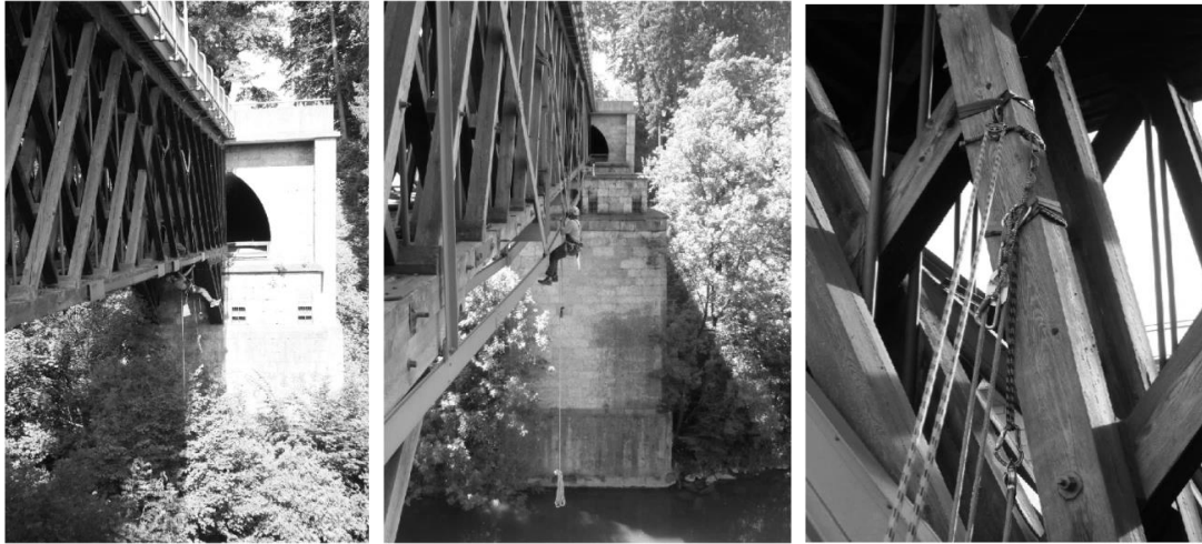
Abbildung 10: Bauwerksprüfung durch Klettertechnik
