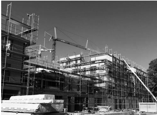
Abbildung 8: Baustelle Blick von Süd-Osten
