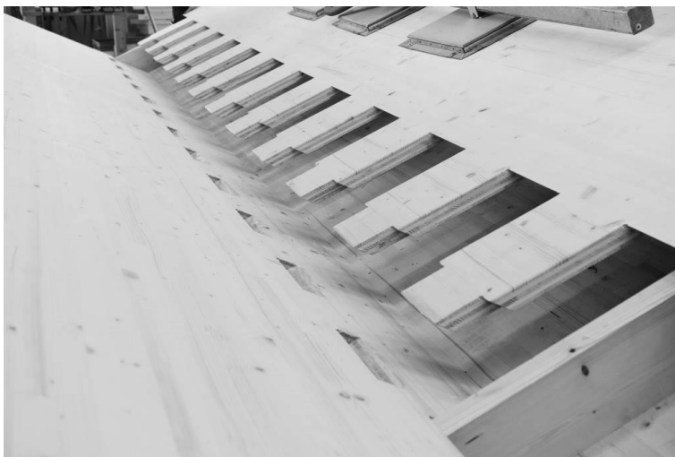
Abbildung 6: Zapfenverbindungen
