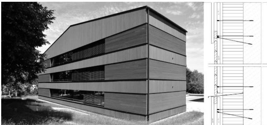
Abbildung 15: Strukturierte Fassade mit optimaler Montagerichtung der Brettlamellen; über dem Metallfries ist die Holzverkleidung horizontal montiert.
