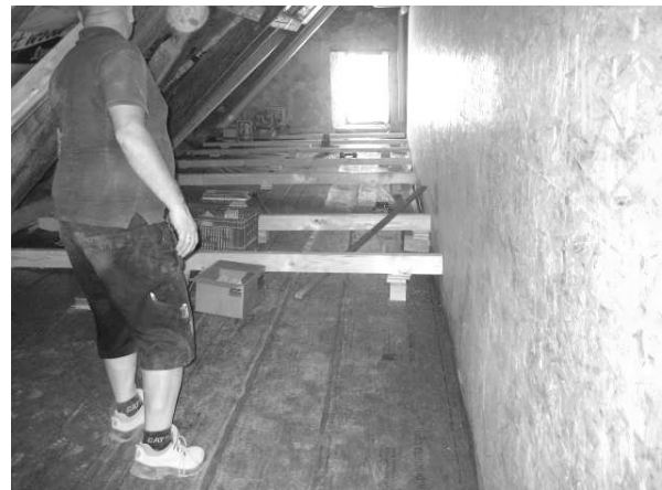
Abbildung 15: Ausgedämmter Bodenhohlraum
