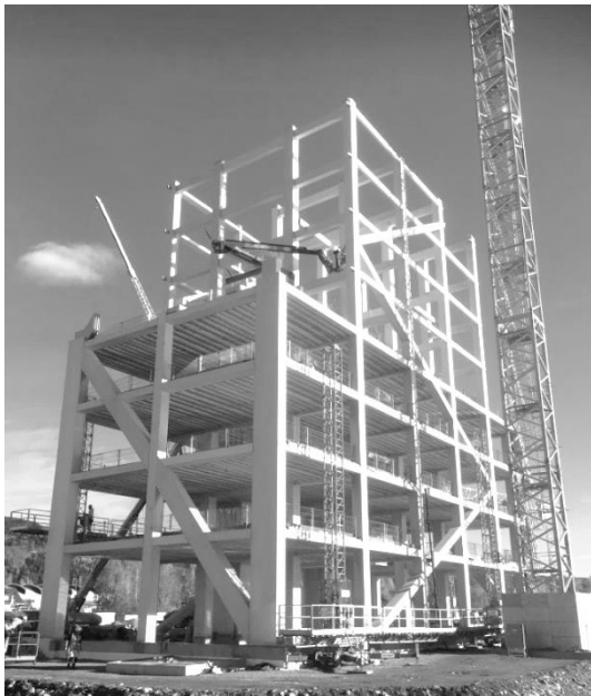
Abbildung 11: Aussteifungssystem des Mjøstårnet im Bau
