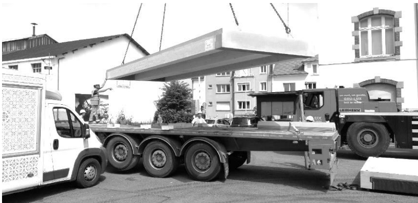
Abbildung 10: Montage der Hybriddeckenplatte beim Prototypenbau durch Cree Luxemburg.
