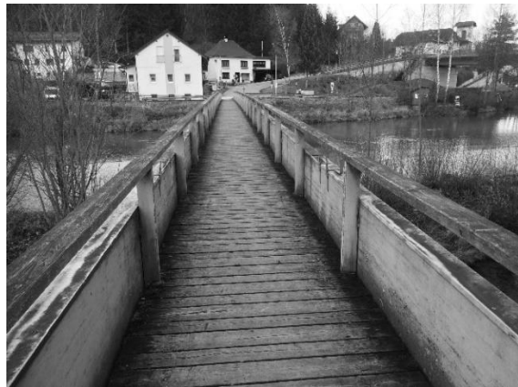
Parallel laufende Straßenbrücke, die 2017 ebenfalls saniert wurde
