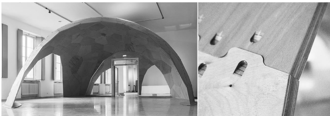
Abbildung 4: Rosenstein Holzpavillon (2017), ein Forschungsdemonstrator des TRR141 zum Thema Segmentschalen aus Holz. Links: Gesamtansicht. Rechts: Detailansicht der Plattenverbindung.
