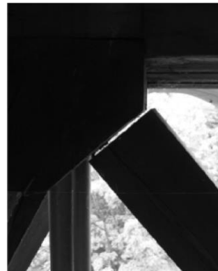
(b) Anschluss der Diagonale an die Schwelle
