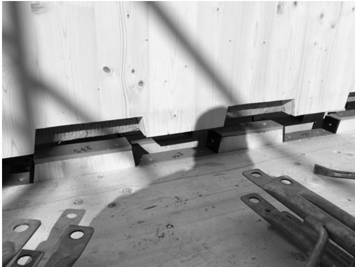
Verzahnung in den Scherfugen zwischen den geschosshohen Wandplatten
