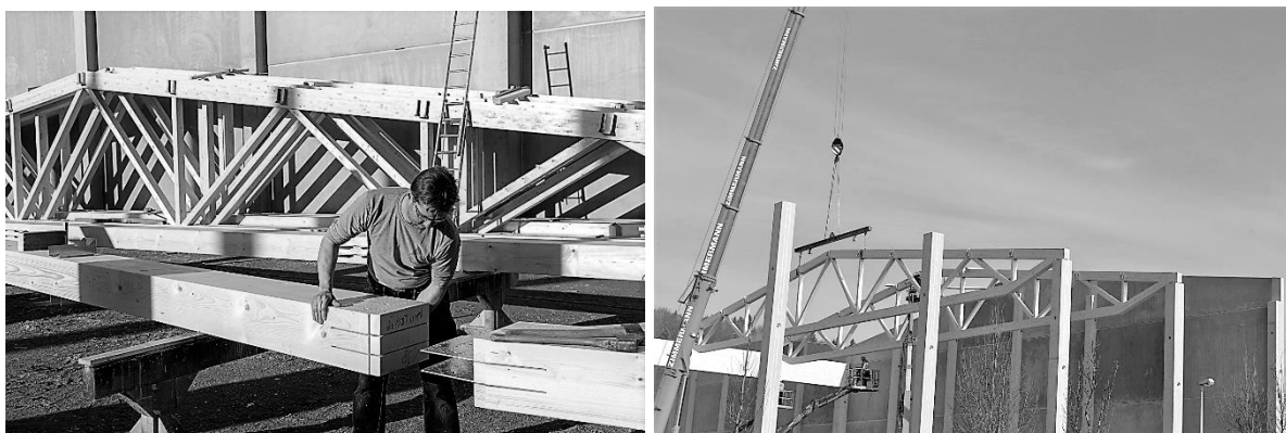
Abbildung 5: Montage vor Ort (Foto: Holzbau Amann)
