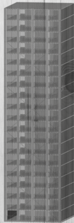
20 Stockwerke aus Holz
