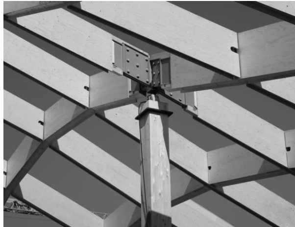
Abbildung 7: Biegesteifer Anschlussknoten für zwei sich kreuzende, holzbekleidete Stahlträger (mit Montage-Abstützung), daran anschließende BS-Holz-Stabzüge und dazwischen gehängte Träger-„Stücke“ in Form von Parallelogrammen. ©WIEHAG
