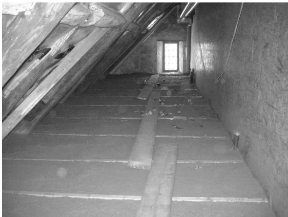
Abbildung 14: Schiftung Boden im Technikraum
