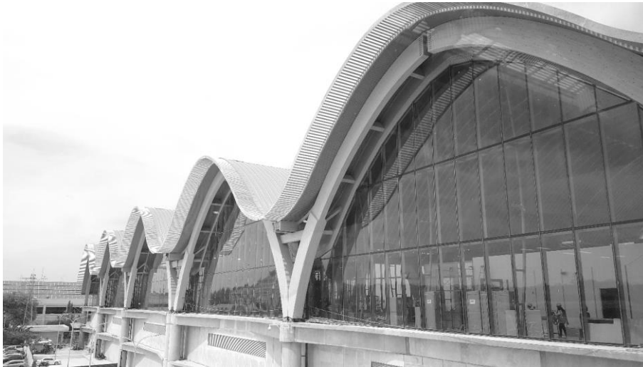
Abbildung 9: Mactan Cebu Airport, Randträger, Foto: RUBNER Holzbau
