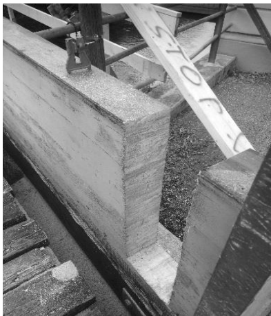
Probeschnitt am Auflager
