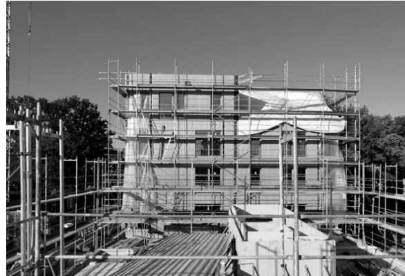
Abbildung 9: Baustelle Blick auf Haus 2
