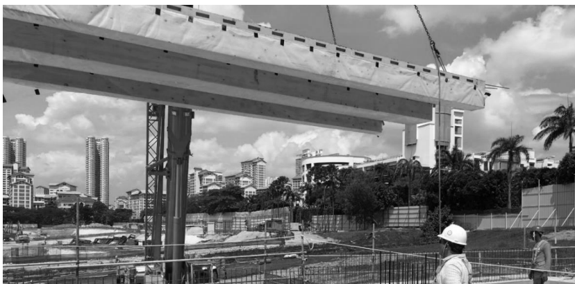
Abbildung 9: Montage der Hybriddeckenplatte beim Projekt EJC (Auftraggeber: Ministry of Education).
