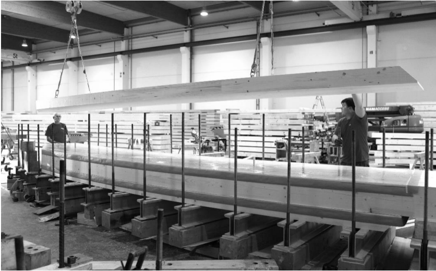
Abbildung 6: Mactan Cebu Airport, Blockverleimung erster Arbeitsvorgang, Foto: RUBNER Holzbau
