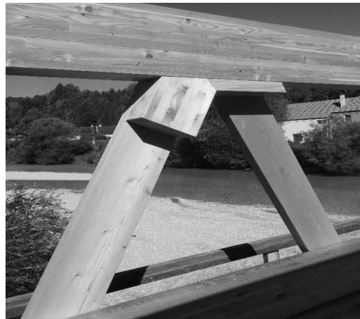
Druckstab Anschlussverstärkung
