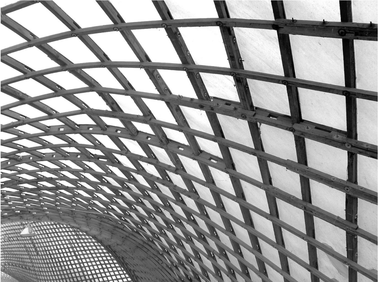
Abbildung 2: Die Gitterschale setzt sich aus Latten der Westamerikanischen Hemlocktanne zusammen.
