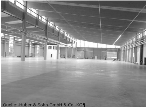
Abbildung 1: Gewerbebau in Holzbauweise
