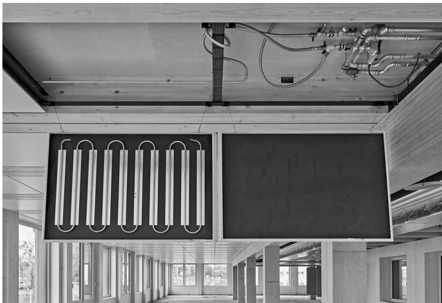
Abbildung 11: Bereits montierte vorgefertigte Holz-Beton-Verbund-Elemente mit integrierter Haustechnik
