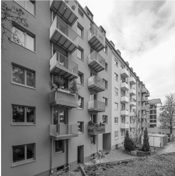
Abbildung 4: Hofansicht – WDVS, Foto: M. Kestel
