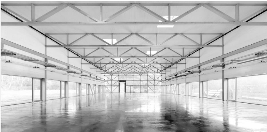
Abbildung 8: elobau Probstzella, Halle innen vor Fertigstellung und Ausbau
