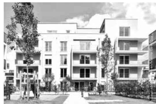
Wohnanlage Max-Bill-Strasse, München
