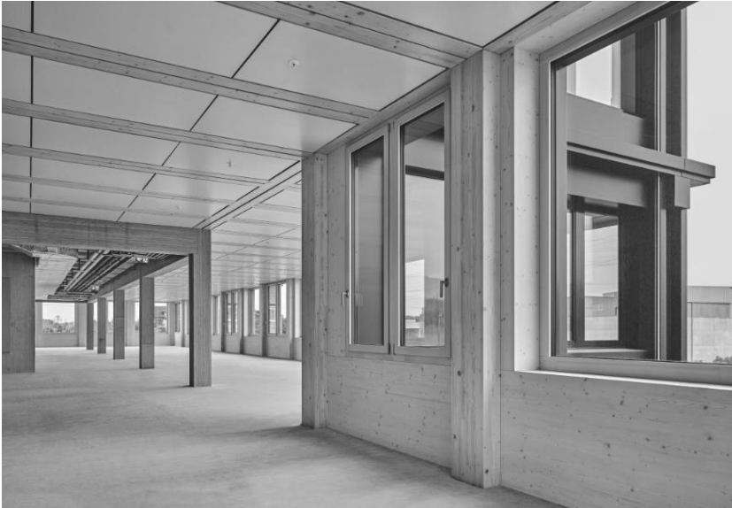
Abbildung: 4: Tragstruktur Fassade (Fichte/Tanne) und innerer Stützring (Bau-Buche). Foto: Roger Frei, Zürich
