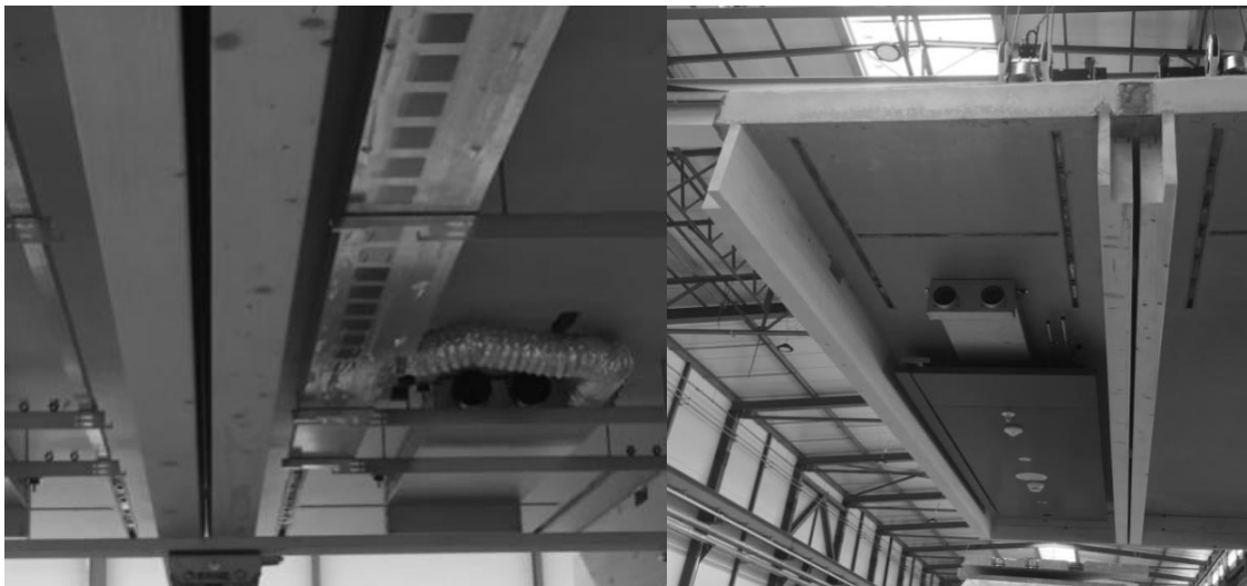
Abbildung 15: vorinstallierte Haustechnik mit fertiger Untersicht
