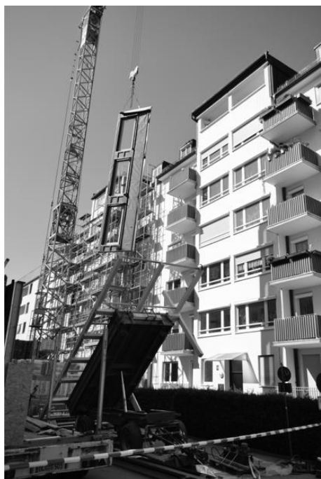
Abbildung 3: Strassenansicht – Montage der vertikalen TES-Elemente, Foto: HKS Architekten
