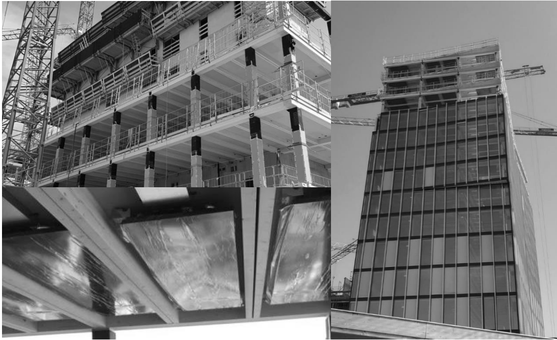
Abbildung 16: fertig montierte Elemente / Module
