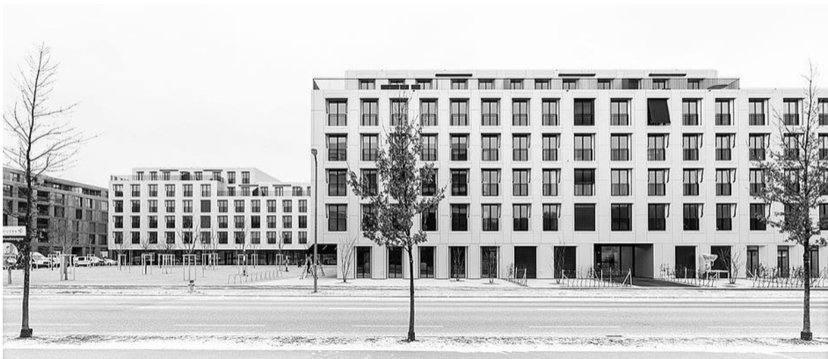
Abbildung 9: «sue&til» in Winterthur-Neuhegi Quelle: Holzbauaustria.at, Copyright Implenia
