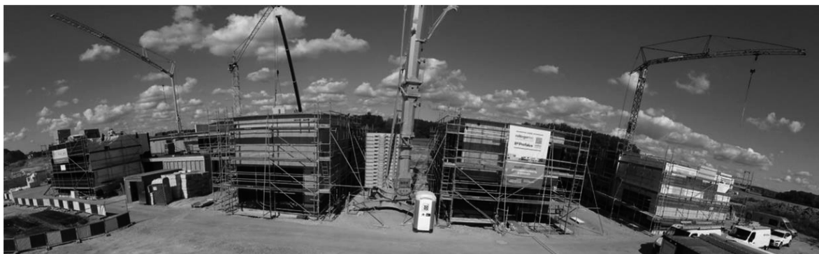
Abbildung 6: Ausführungsstand der Rohbauarbeiten im Spätsommer 2019
