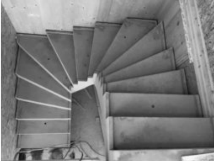
Abbildung 2: Innentreppe als Stahlbetonfertigteil
