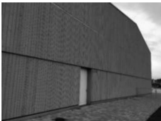
Abbildung 9: Fassade - behandelt mit einer Vorvergrauungslasur. Die Oberfläche wirkt sehr natürlich und ist kaum von einer unbeschichteten, bewitterten Fassade zu unterscheiden.
