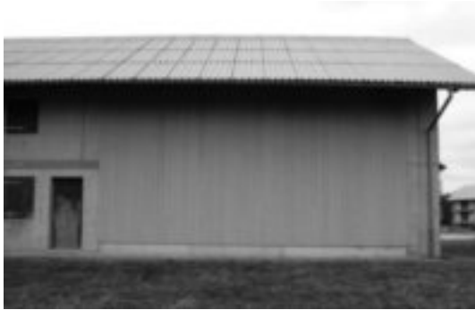
Abbildung 14: Fassade mit Dickschichtlasur ostexponiert nach 5 Jahren Nutzungsdauer, die Erscheinung ist sehr gleichmässig (Volkmer und Höltschi 2008)
