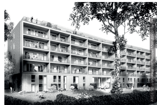
Mehrgeschossiger Holzbau, Walden 48, Berlin
