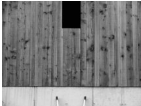
Abbildung 17: Vorvergraute Fassade (westexponiert) nach 5 Jahren Nutzungsdauer, das Erscheinungsbild ist relativ gleichmässig und vermittelt den natürlichen Holzcharakter (Volkmer und Höltschi 2008)
