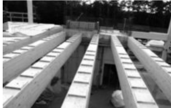
Abbildung 24b: Aufnahme Holzverbunddecke [B. Walter Ingenieurgesell. mbH]
