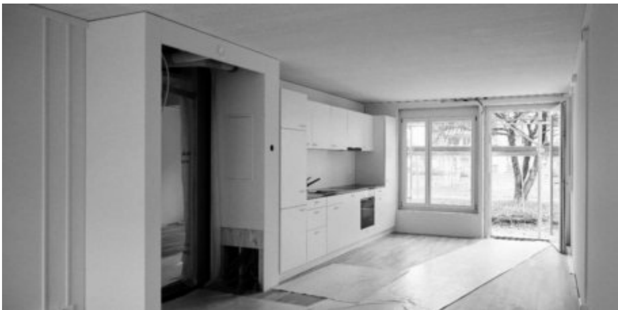
Abbildung 2: Vorgefertigtes Wohnmodul, Modulübergang wird nach der Montage fertiggestellt
