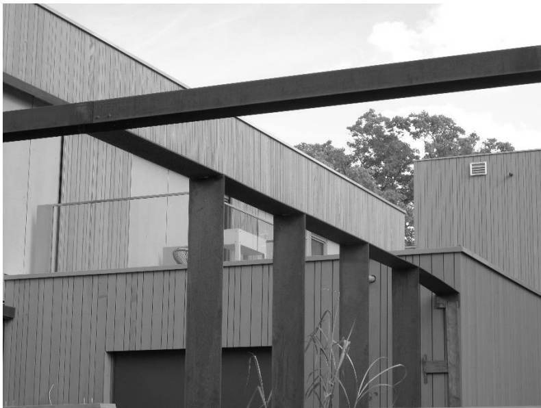
Abbildungen 6 und 7: Bauvorhaben WA 14 Ost: Baugemeinschaft team 3 / ARGE Architekturwerkstatt Vallentin + Johannes Kaufmann Architektur/ Dornbirn
