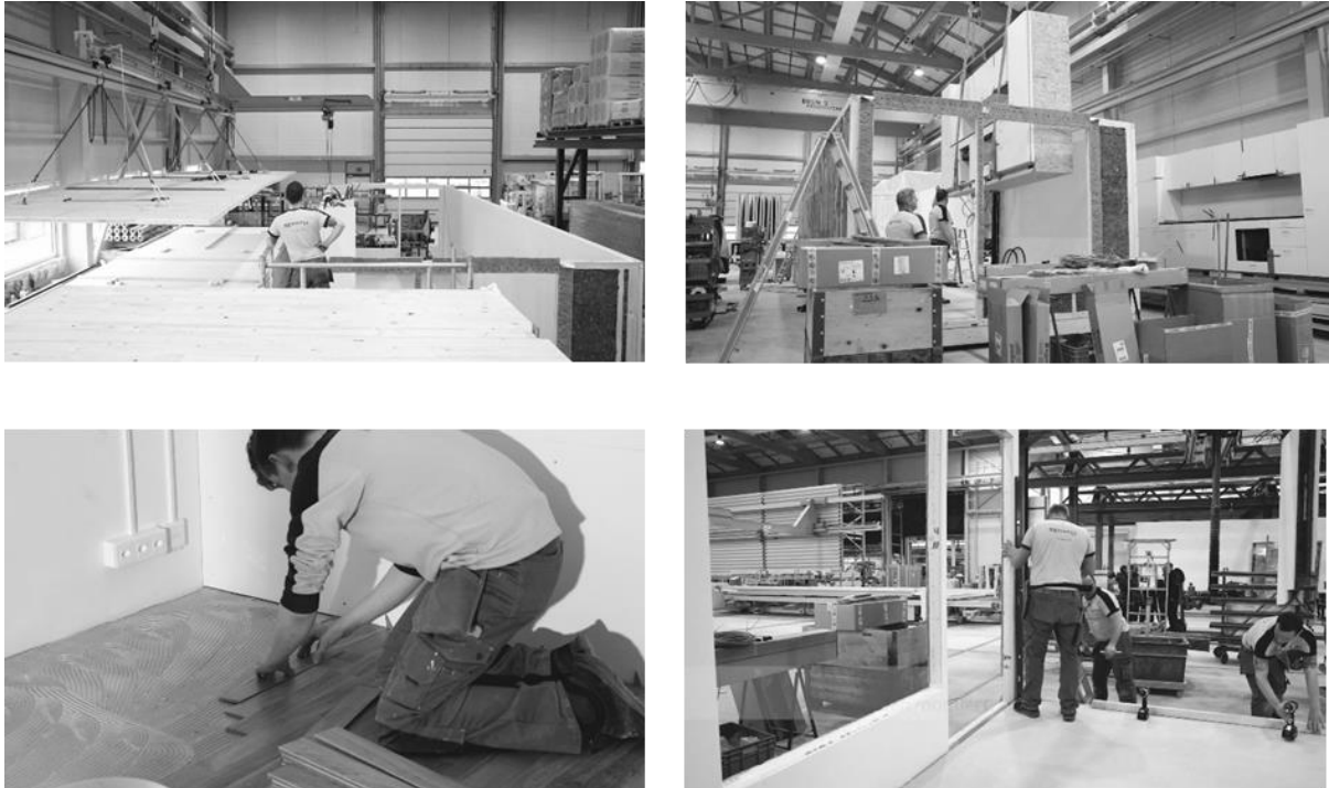
Abbildung 7: Fertigung der Raummodule in der Werkhalle der Renggli AG in Schötz.
