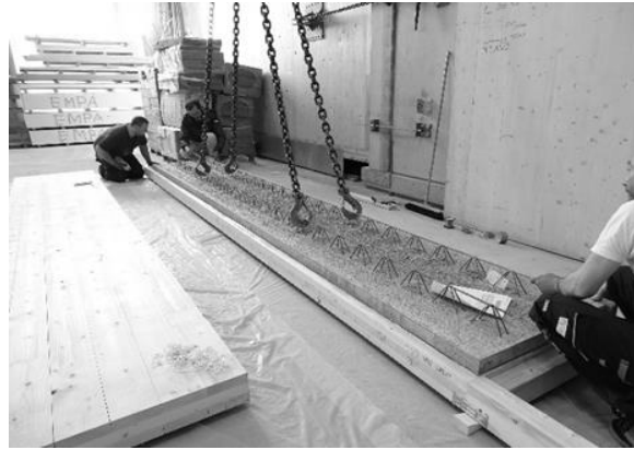
d) Ablegen des Betonfertigteils auf der Klebstoffuge
