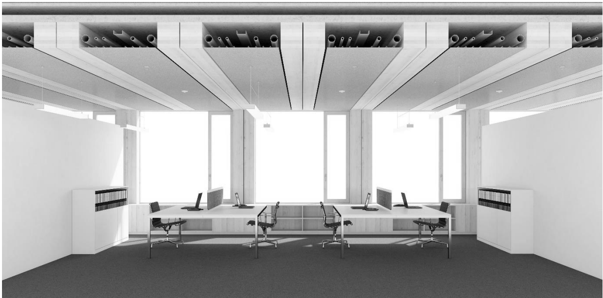
Abbildung 2: CREE-Decke mit haustechnischer Installation |© Thomas Knapp, Architekten Hermann Kaufmann
