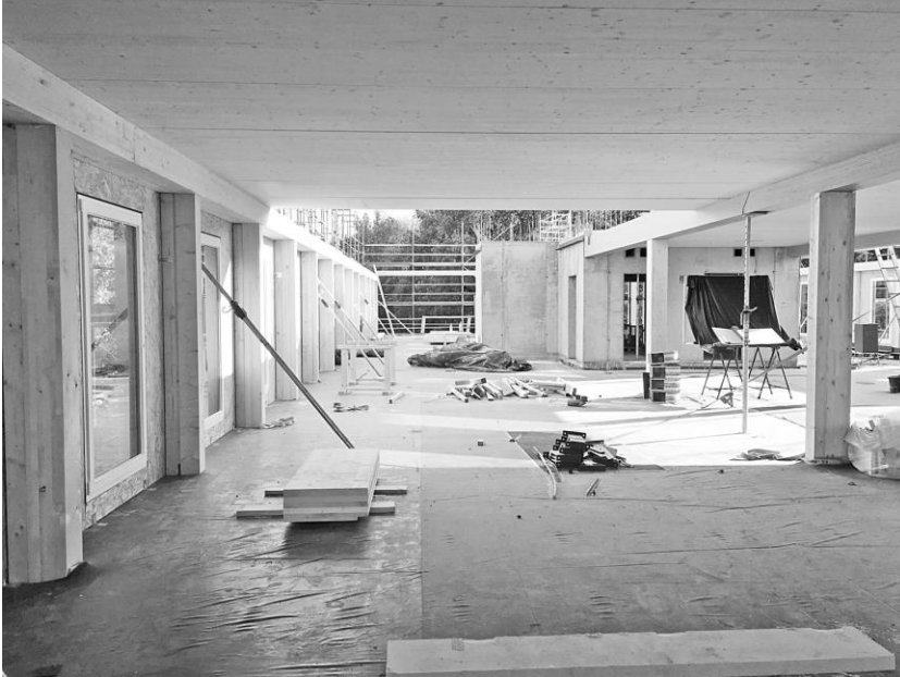
Abbildung 2: Rohbau mit Skelett aus Stützen und Trägern.
