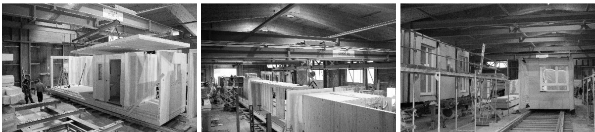
Abbildung 4: Modulmontage in der Feldfabrik
