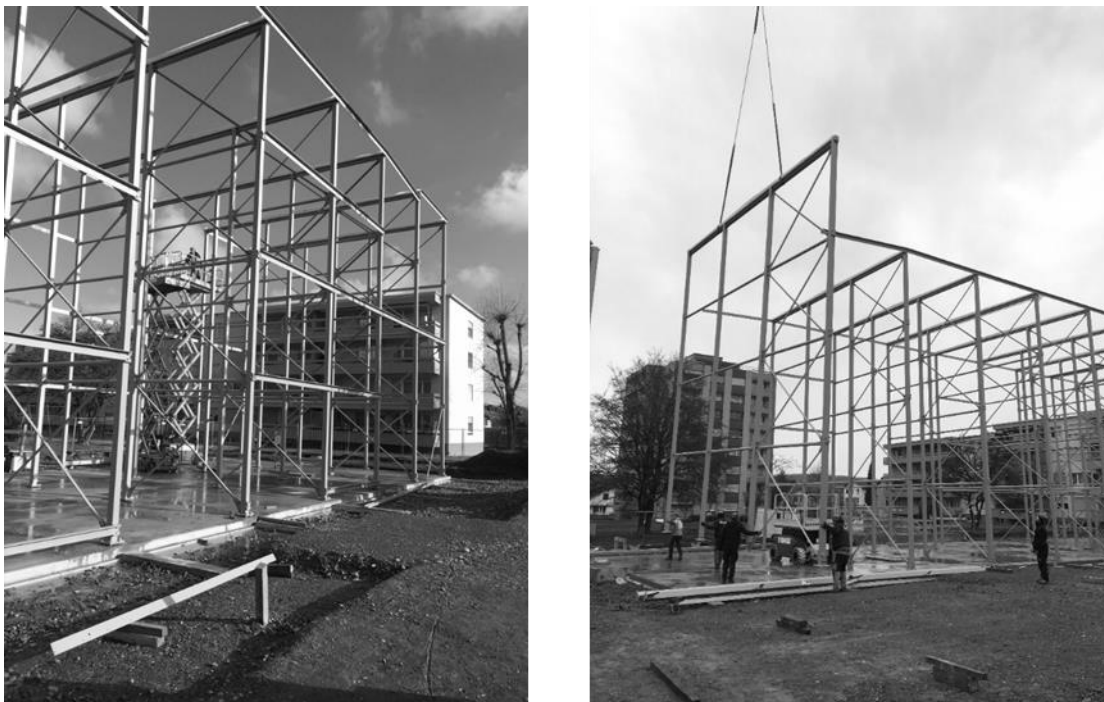
Abbildung 8: Das Stahltragwerk wird in Lenzburg aufgebaut.
