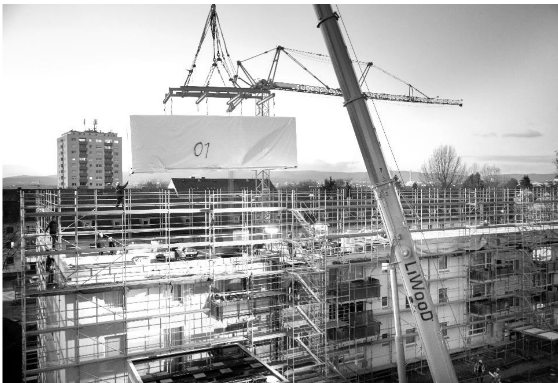
Abbildung 5: Versetzen des ersten Moduls von insgesamt 1.102
