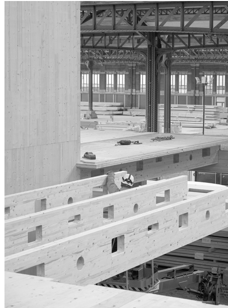
Abbildung 9: Montage BSH-Rippen (Quelle: ZÜBLIN Timber)
