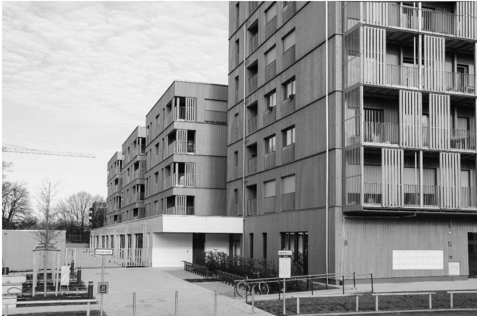
Abbildung 4: Bauvorhaben WA 14 West: GWG München, Müller-Blaustein, Arch. Rapp
