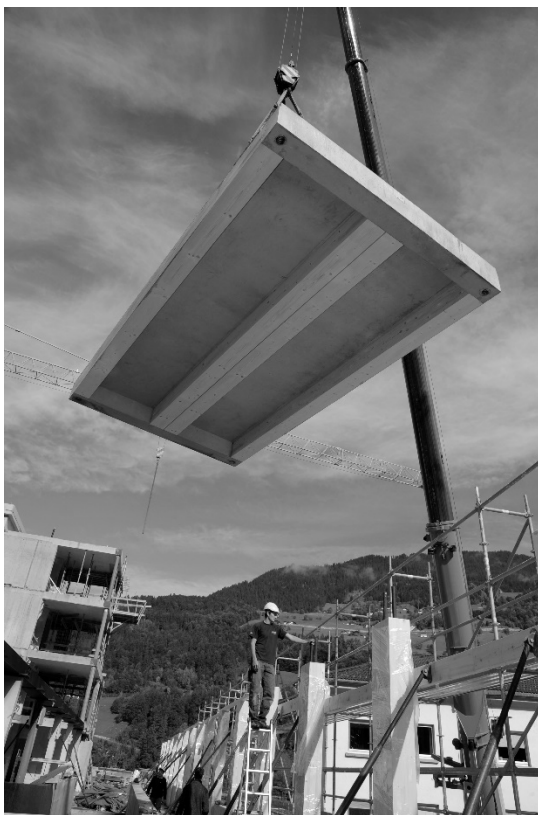
Abbildung 6: Die Deckenelemente bestehen aus BS-Holzbalken mit 8 cm dicken Stahlbetonplatten
