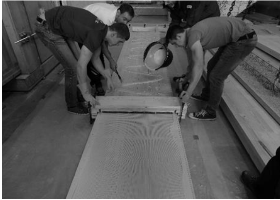
c) Abziehen der Klebstoffuge mit der halb-automatischen Klebstoffapplikationsmaschine
