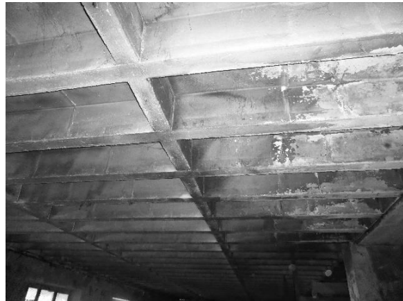
Abbildung 7b: Rippendecke [B. Walter Ing. GmbH]
