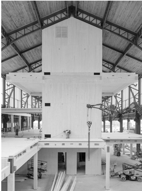
Abbildung 8: viergeschossiger BSP-Kern (Quelle: ZÜBLIN Timber)
