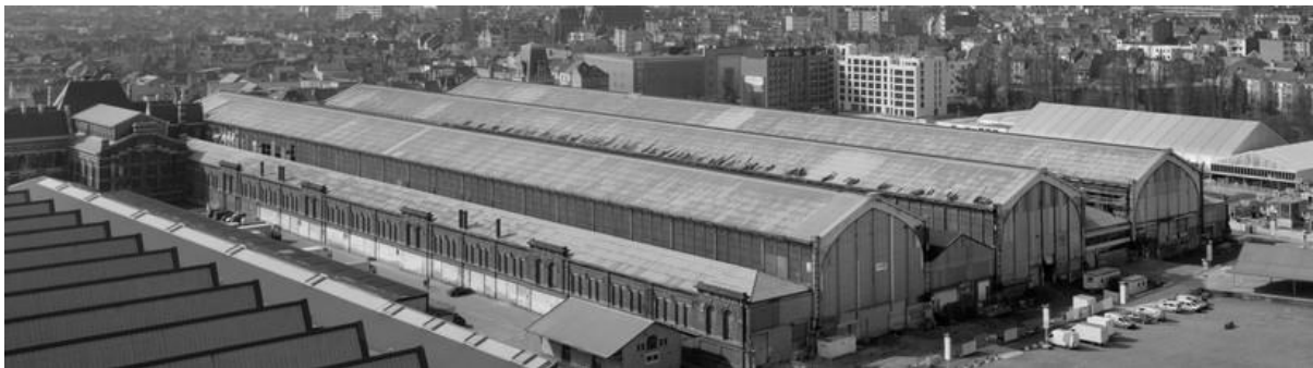
Abbildung 1: Ehemaliger Güterbahnhof Gare Maritime (Quelle: Extensa Group)
