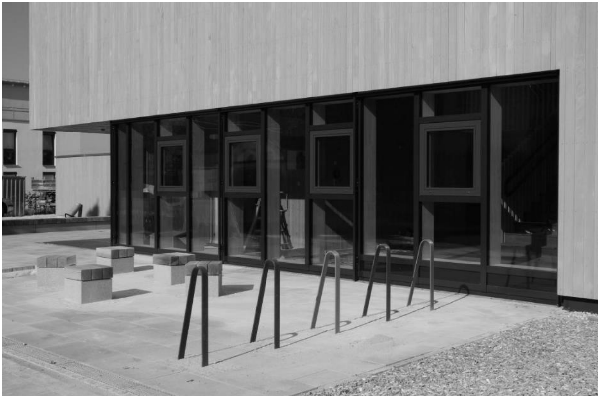
Abbildung 8: Vorplatz und Eingangsbereich
