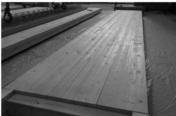
a) Brettsperrholzplatte vor dem Klebstoffauftrag
