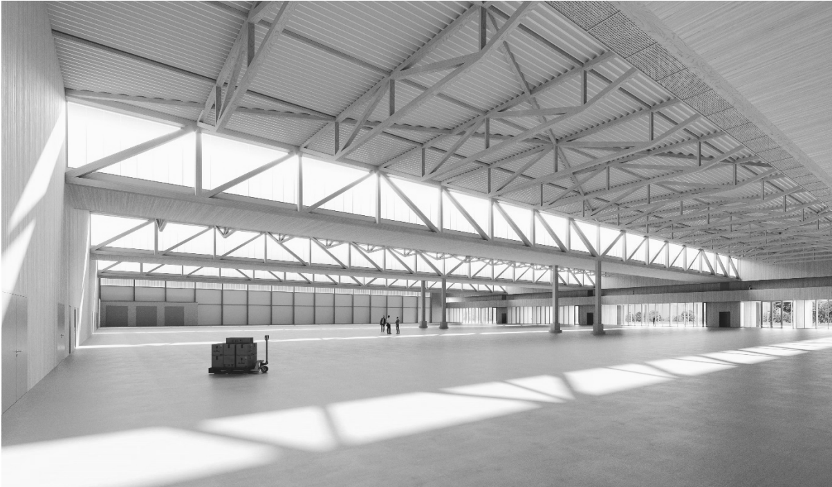
Abbildung 2: Das Haupttragwerk der neuen Halle bilden rund 82 m lange Fachwerkbinder
