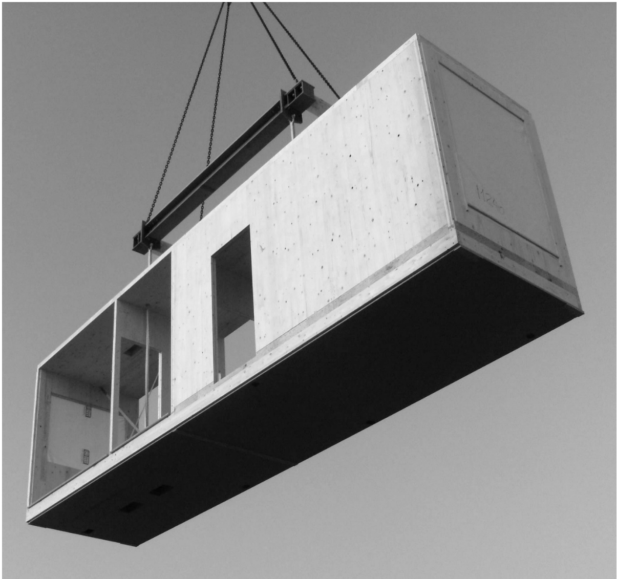
Abbildung 1: Versetzen eines Holzmoduls
