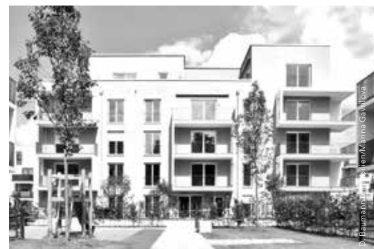
Wohnanlage Max-Bill-Strasse, München
