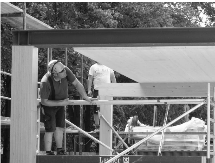
Abbildung 3: Montage der Deckenelement auf den Unterzügen
