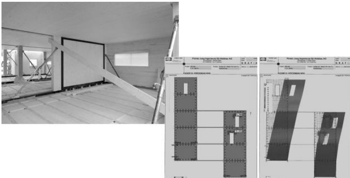
Abb. 21: Links: Baustellenfoto mit einer in den Hauptstützen und in den Unterzügen eingespannten Brettsperrholzplatte. Rechts: Auszug aus der statischen Bemessung bezüglich der Bemessung dieser aussteifenden Wand, die ein Teil des horizontalen Tragwerkskonzeptes ist.
