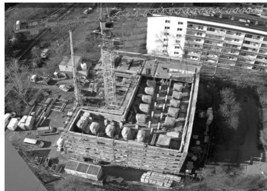
Abbildung 9: Neubau studentisches Wohnen Storkower Str. 205a (Draufsicht vom Nachbargebäude)
