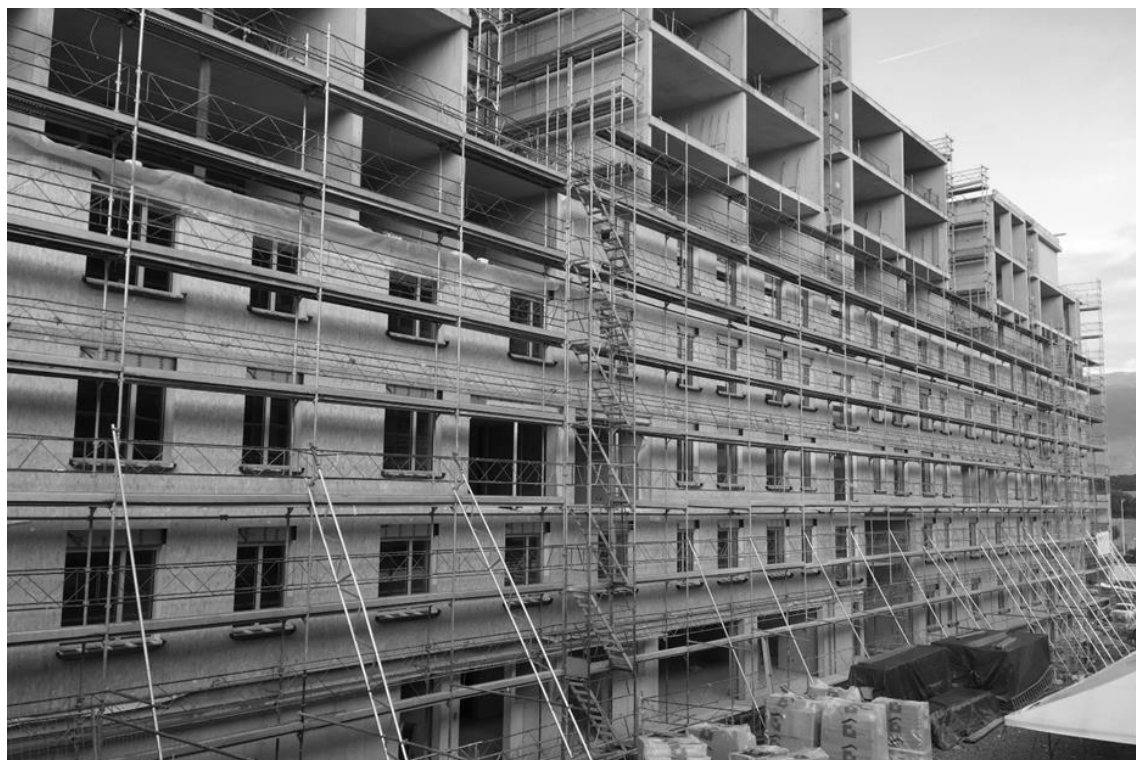
Abbildung 1: Fassadeneinbau beim Projekt Les Vergers in Meyrin/Genf
