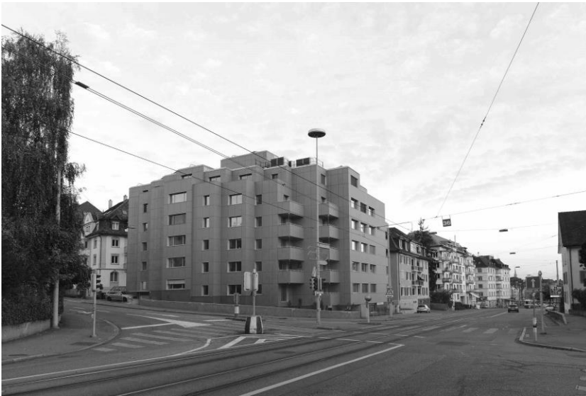
Abbildung 2: Modernisierung mit „Aktiver Glasfassade“
