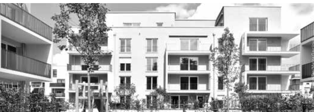
Wohnanlage Max-Bill-Straße, München
