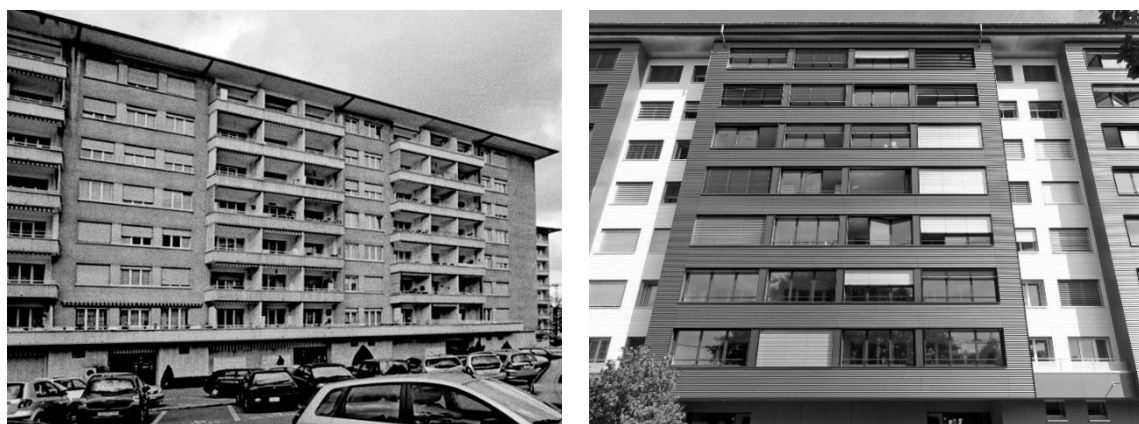
Abbildung 8: Wohnhaus La Cigale, Genf – vor und nach der Fassadensanierung
