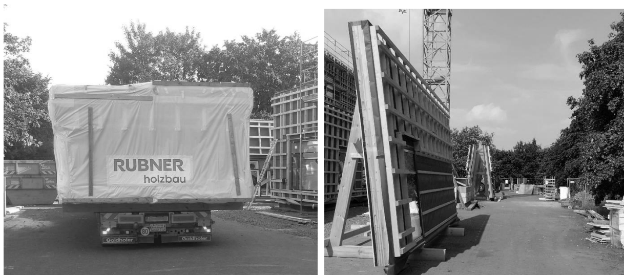
Abbildung 7 und 8: Sondertransport Fassadenelemente und A-Bock zur Fertigmontage
