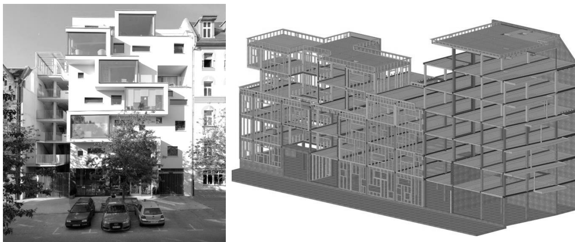
Abb.19: C13 in Skelettbauweise mit Unterzug-Stützenkonstruktion und nichttragenden Aussenwänden in Rahmenbauweise (5-geschossigen Teil) und in Brettsperrholzbauweise (7-geschossiger Teil).
