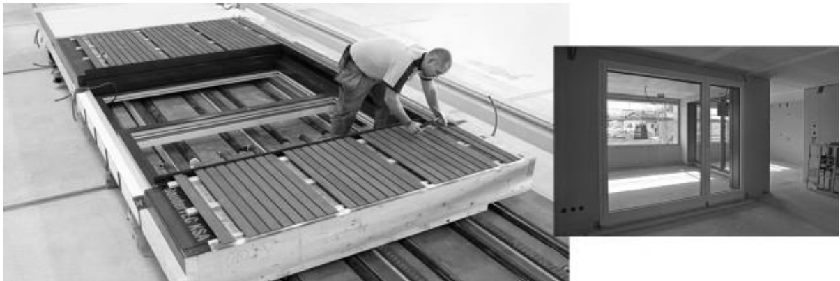
Abbildung 11: Die Skelett-/Rahmenbauweise erlaubt eine weitgehende Vorfertigung in den klimatisierten Hallen der Holzbauer und damit kurze Montage- und Ausbauezeiten auf der Baustelle.
