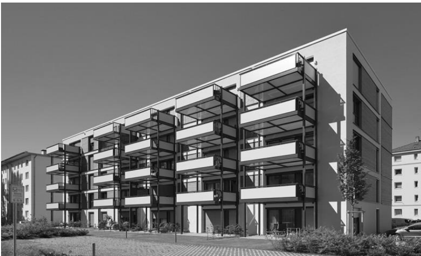
Abbildung 9: Blick vom Innenhof
