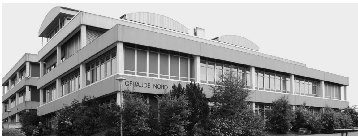
Abbildung 1: Das Bestandsgebäude (Baujahr 1972-78) vor der Sanierung
