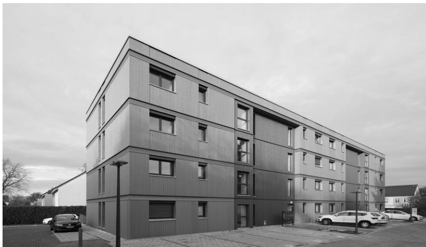
Abbildung 11: Ansicht vom Innenhof
