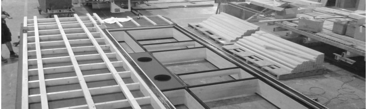
Abbildung 4: Vorfertigung mit integrierter Pfosten-Riegel-Fassade
