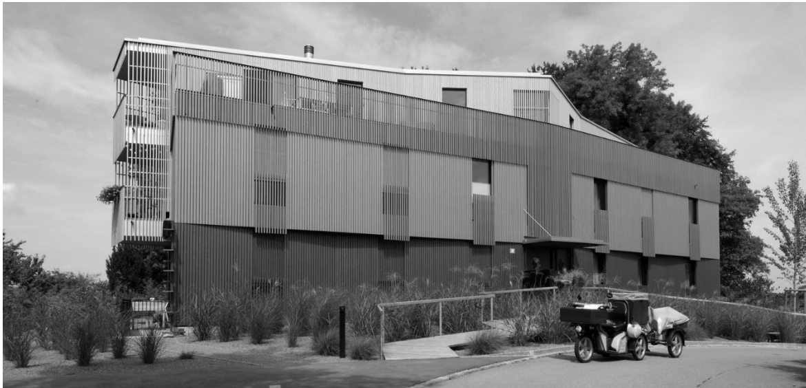
Abbildung 5: Modernes, innerstädtisches MFH in Holz „Arche Noah“, Zürich Altstetten
