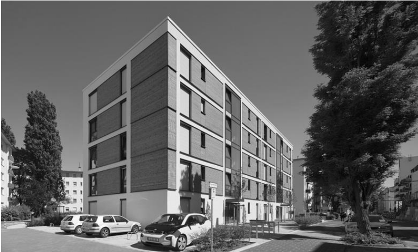
Abbildung 8: Blick von der Taunusstraße
