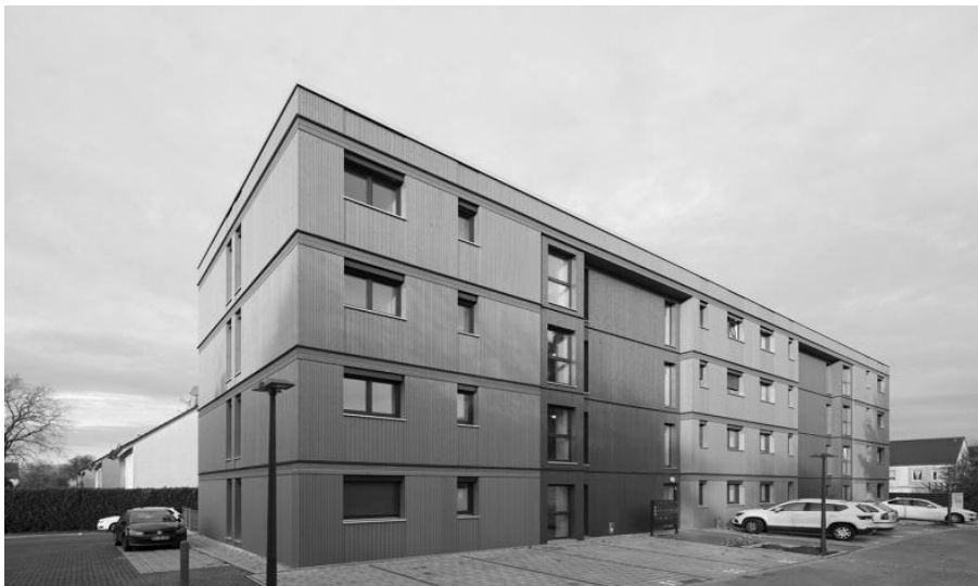
Abbildung 1: Systemhaus Hanau, Lenbachstraße
