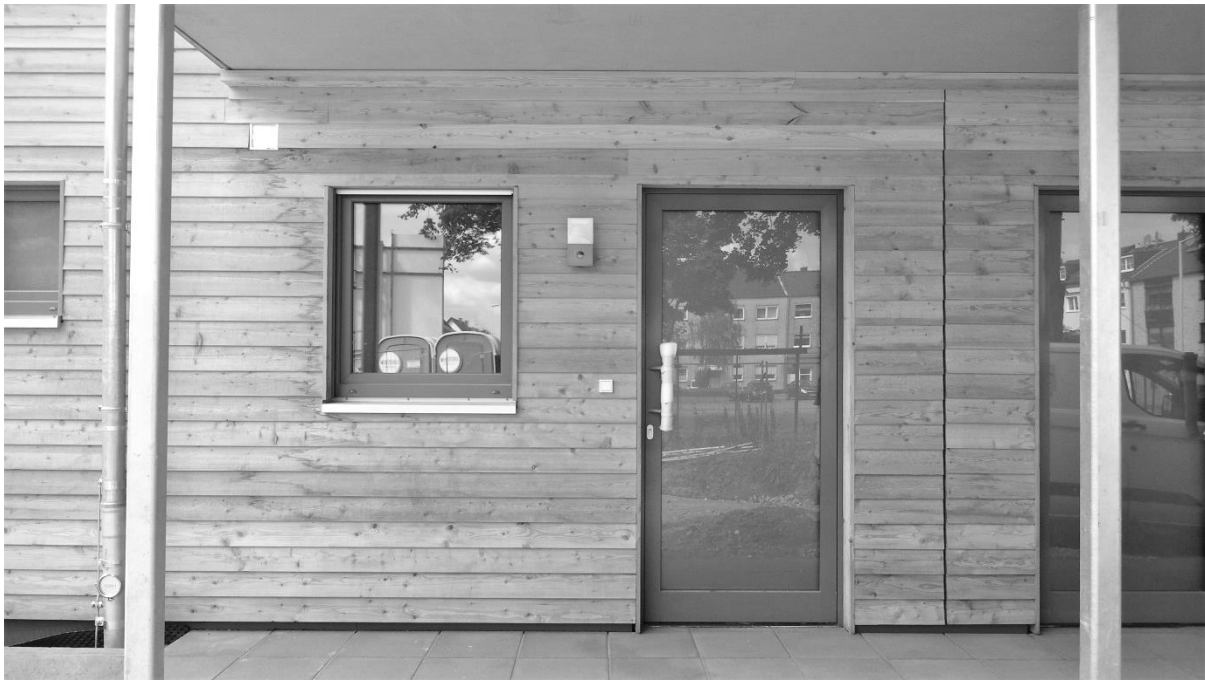
Abbildung 10: Detailansicht – Wohnungseingang mit Fenster der Wohnküche
