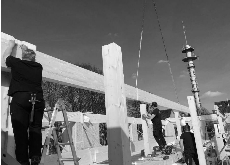
Abbildung 15: Montage der Überzüge
