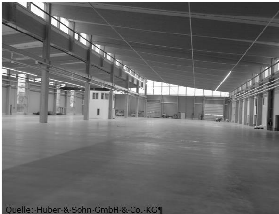
Abbildung 1: Gewerbebau in Holzbauweise
