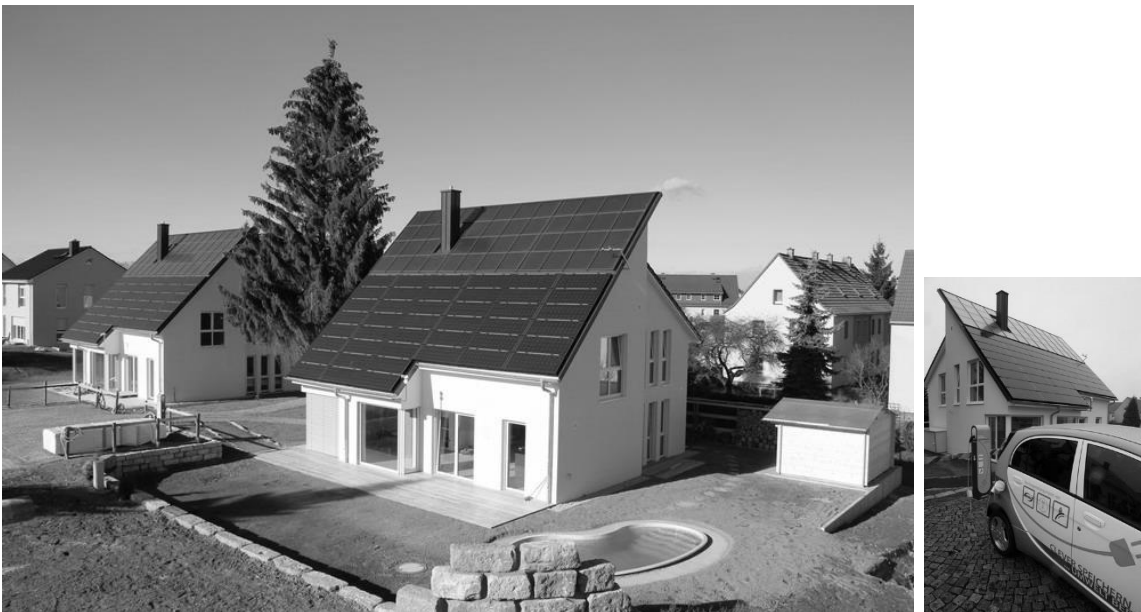
Abbildung 4: Intelligente Eigenversorgung mit Wärme, Strom und Mobilität aus der Sonne. Das Haus wird zur Tankstelle. Es hat eine Wohnfläche von 161 m 2 , Solarthermie 46 m 2 mit 9 m 3 Langzeitwärmespeicher, 8,4 KWP Photovoltaik mit 58 kWh Akku. Die ersten beiden bewohnten energieautarken Einfamilienhäuser Europas in Freiberg/Sachsen, errichtet von der HELMA Eigenheimbau AG Baujahr 2013. Drei Jahre lang werden diese beiden Häuser durch die TU Bergakademie Freiberg messtechnisch untersucht. Primärenergiebedarf: 7 kWh/m 2 a, Stromverbrauch 2.100 kWh/a, Holzbedarf 2-3 rm/a.
