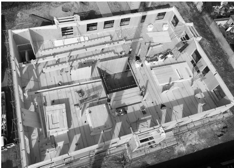
Abbildung 13: Obergeschoss des Bürogebäudes während der Montage
