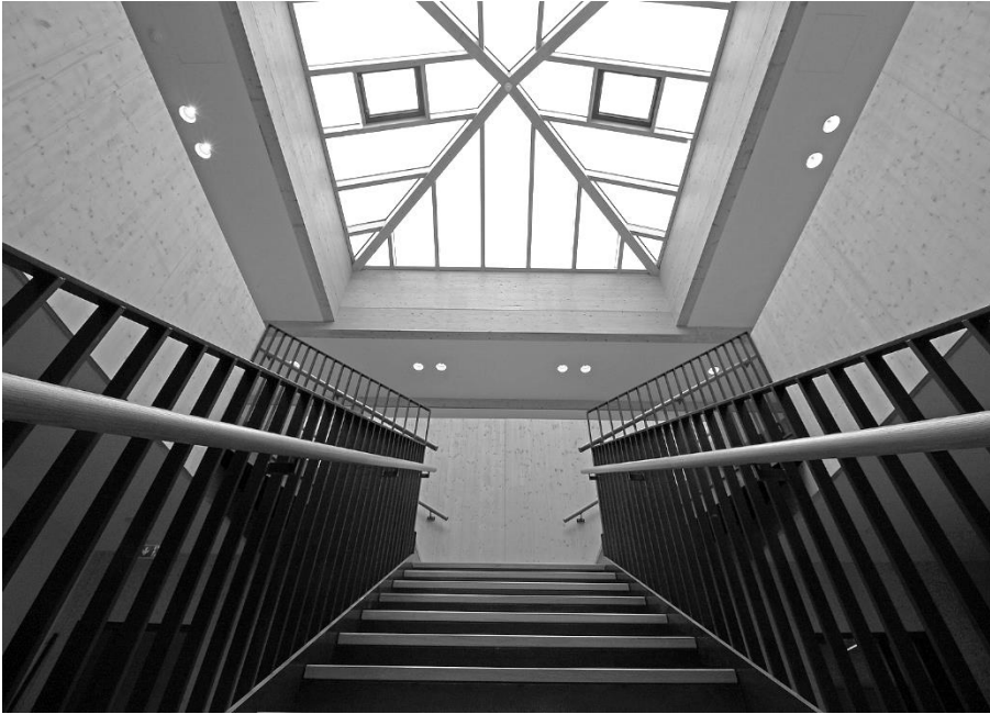
Abbildung 19: Innentreppe und Lichtkuppel nach Fertigstellung
