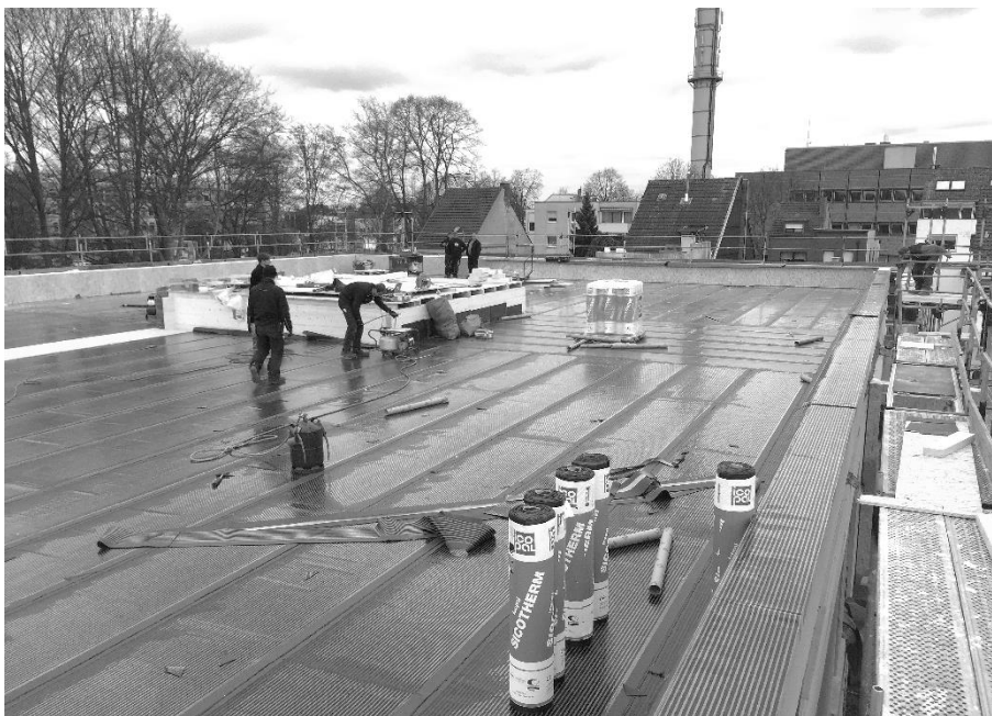
Abbildung 18: Verlegung der Notabdichtung und Anbringen der Attika
