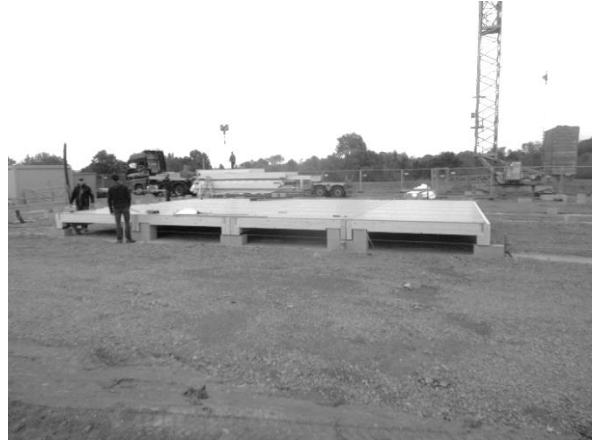
Montage Bodenelemente
