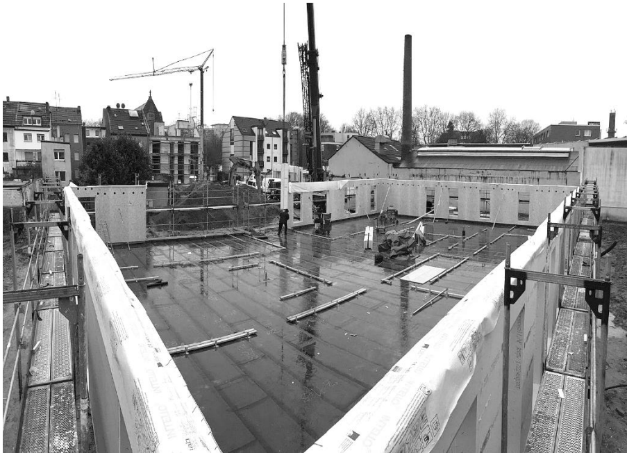
Abbildung 10: Montage der Außenwände
