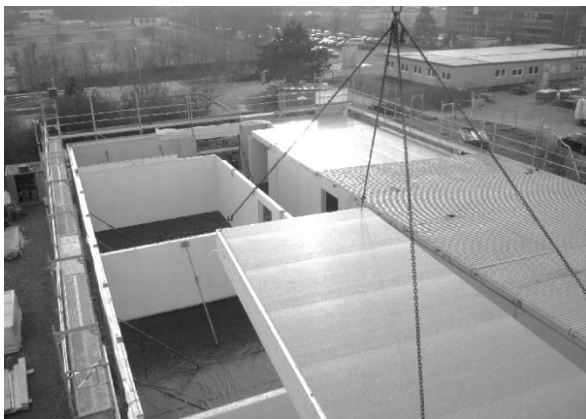
Montage Deckenelemente
