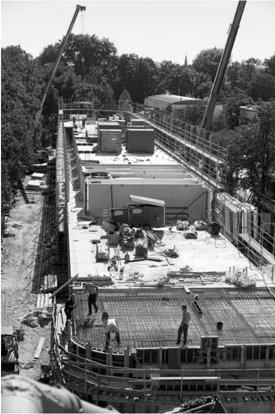
Abbildung 8: Enge Taktung von Beton- und Holzbau
