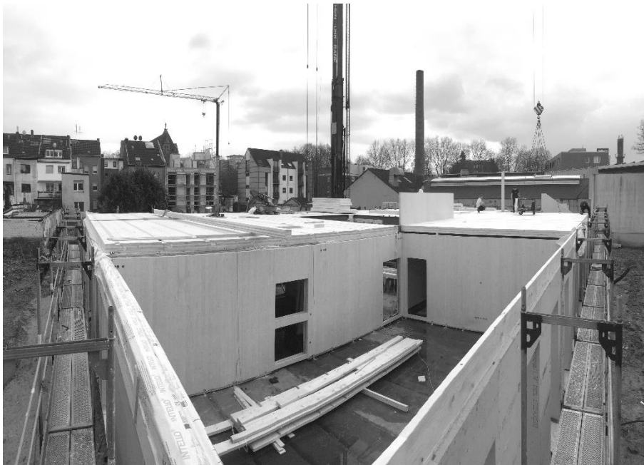
Abbildung 11: Montage der BSP-Decken
