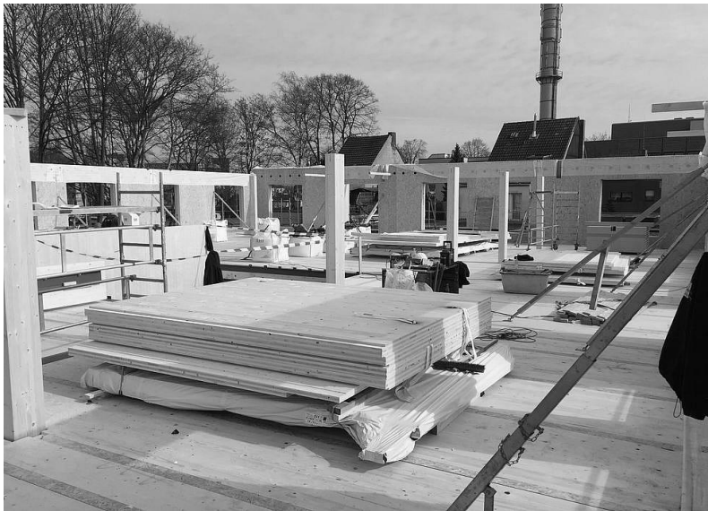
Abbildung 12: Montage der Obergeschosswände
