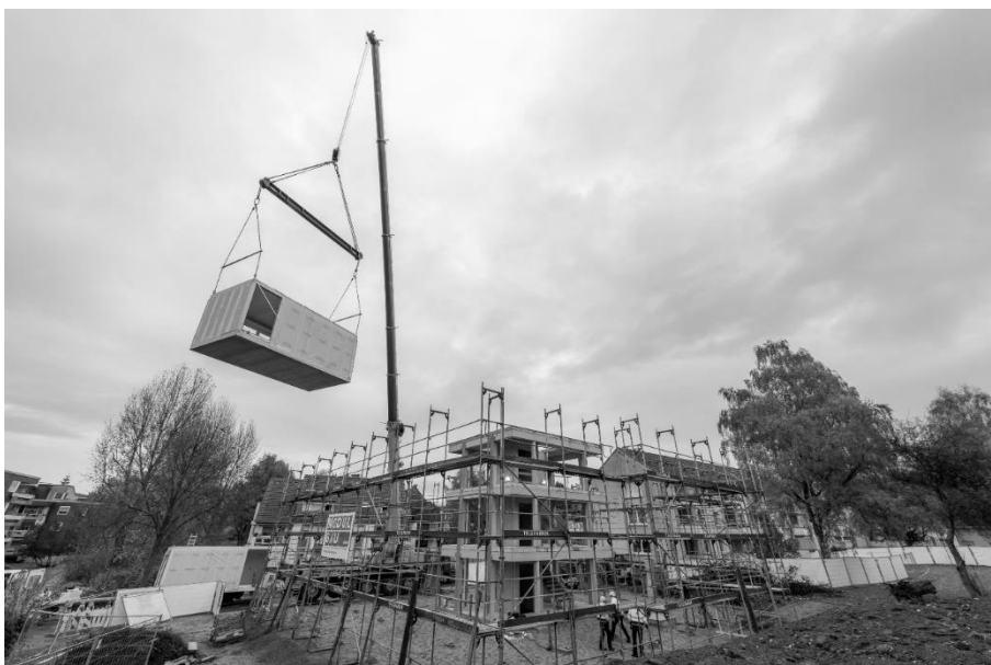
Abbildung 5: Baustelle in Bochum-Hofstede © Simon Bierwald/Vonovia
