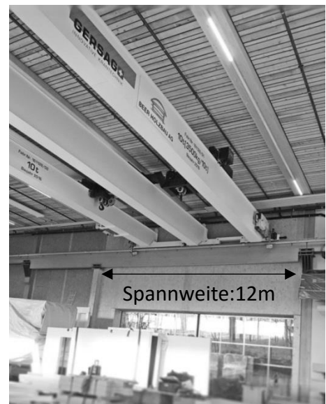
Kranbahn aus Baubuche
