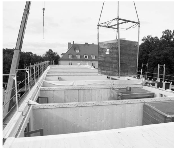
Abbildung 7: Montage von Sanitärmodulen
