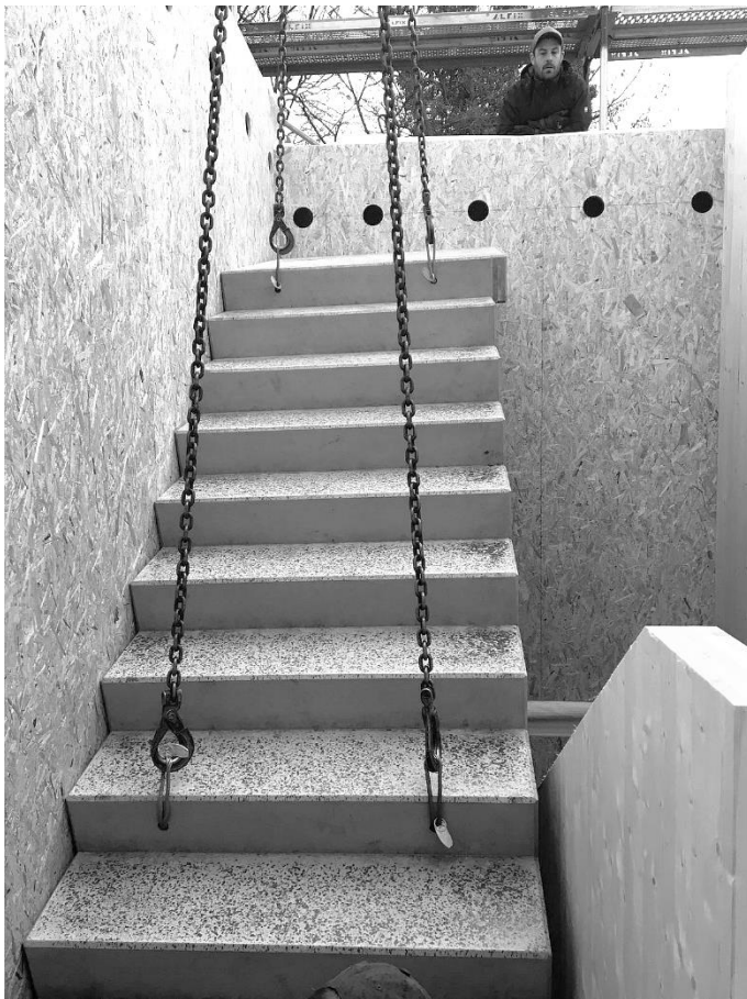
Abbildung 16: Einbau der Stb.-Fertigteiltreppen
