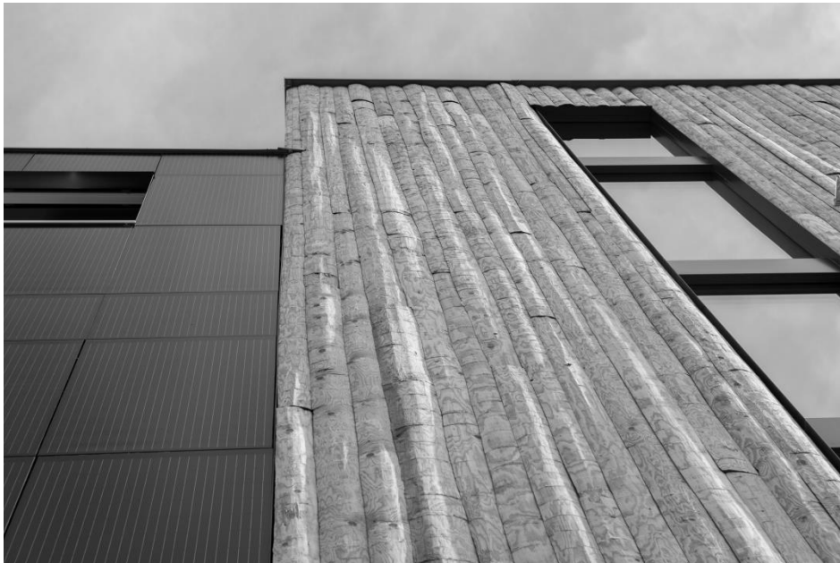
Fassade mit Schwartenschalung
