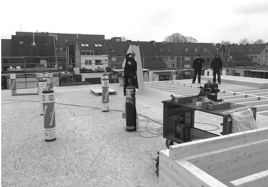
Abbildung 17: Aufbringen der Beplankung (Dachtafel)
