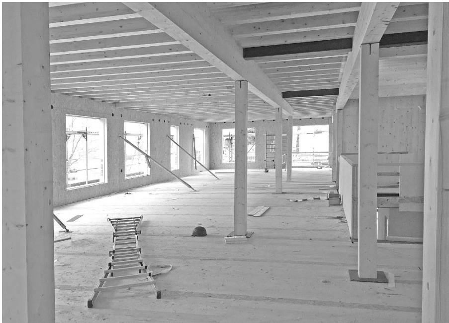
Abbildung 4: Flexibilität in der Innenraumgestaltung durch wenige Tragelemente
