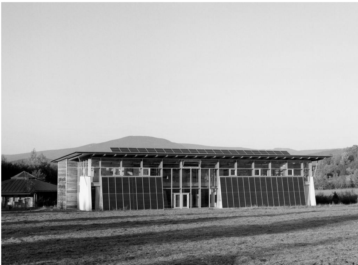
Abbildung 8: Besucherzentrum im Bayerischen Wald, Baujahr 2001 mit einer Nutzfläche von 763 m 2 und einem Primärenergiebedarf von 7,5 kWh/m 2 a. Auch dieses gewerblich genutzte Gebäude beheizt sich seit 2001 mittels Solarthermie und Langzeitwärmespeicherung ganzjährig zu 100% nur mit der Sonne. Außerdem erzeugt es noch Solarstrom, hauptsächlich zur Eigennutzung. Es ist über ein kleines Nahwärmenetz mit den Nachbarhäusern verbunden und gibt vom Frühjahr bis Herbst Wärme ab. Quelle: Sonnenhaus Institut e.V.
