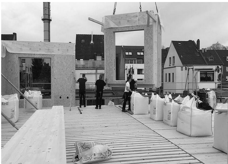
Abbildung 14: Einbau der vorgefertigten Balkone in die Außenwände des Obergeschosses
