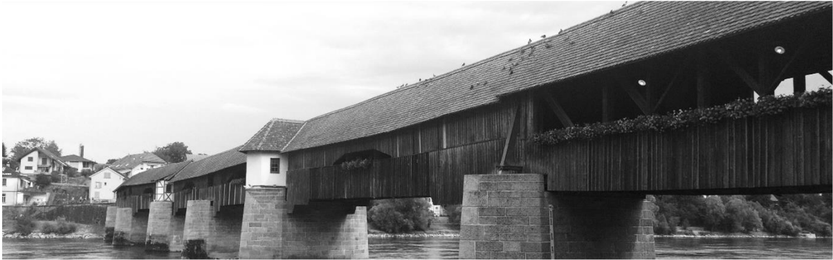
Abbildung 2: Holzbrücke über den Rhein in Bad Säckingen (D)
