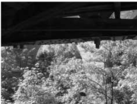
Abbildung 8: Verankerung der Hänger an der Unterseite
