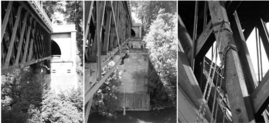
Abbildung 10: Bauwerksprüfung durch Klettertechnik
