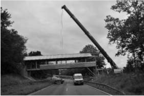
Abbildung 16: Montage 1. Segment, Quelle: HSW-Ingenieure
