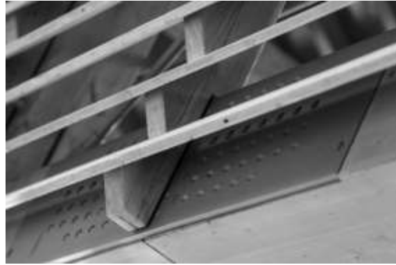
Abbildung 11: Fertiger Zuganschluss, Quelle: Markus Ruf
