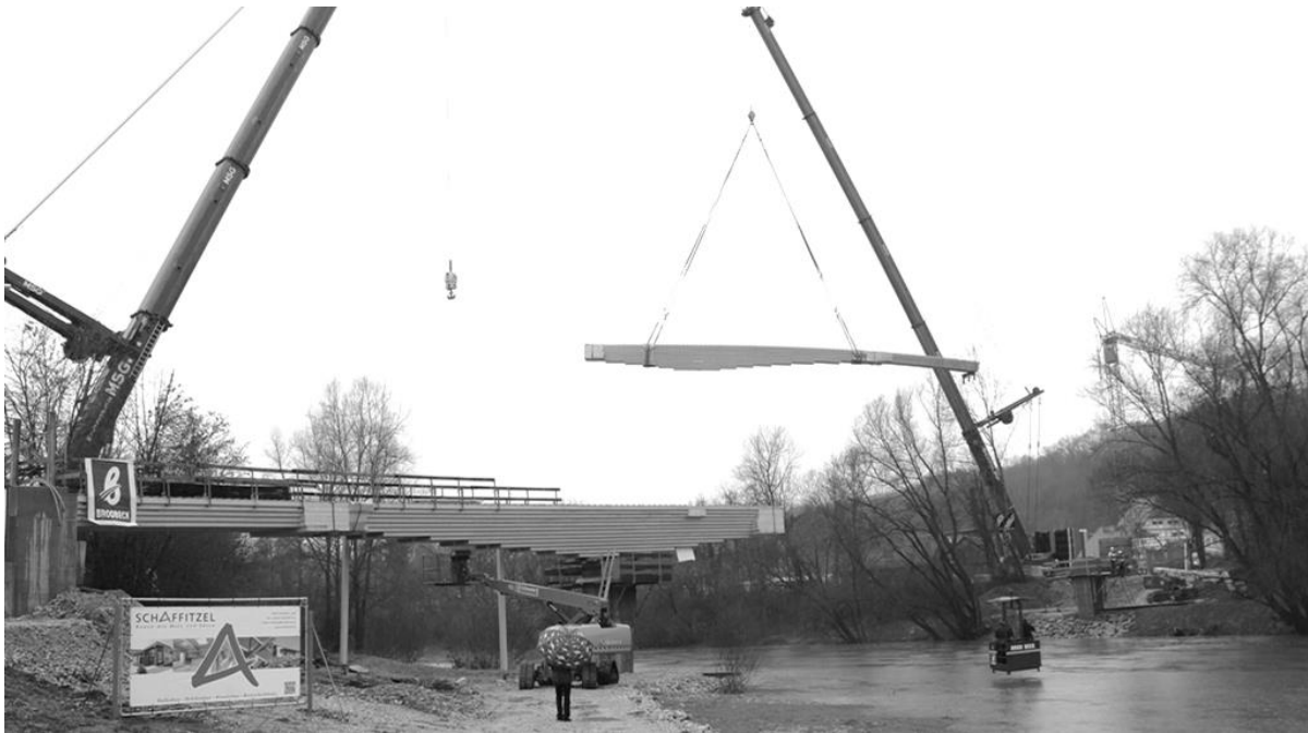
Abbildung 16: Einheben eines gebogenen Brückenelementes
