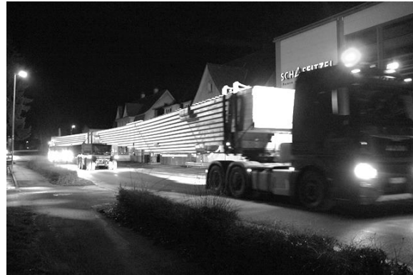
Abbildung 13 und 14: Verladen und Transport eines gebogenen Elementes
