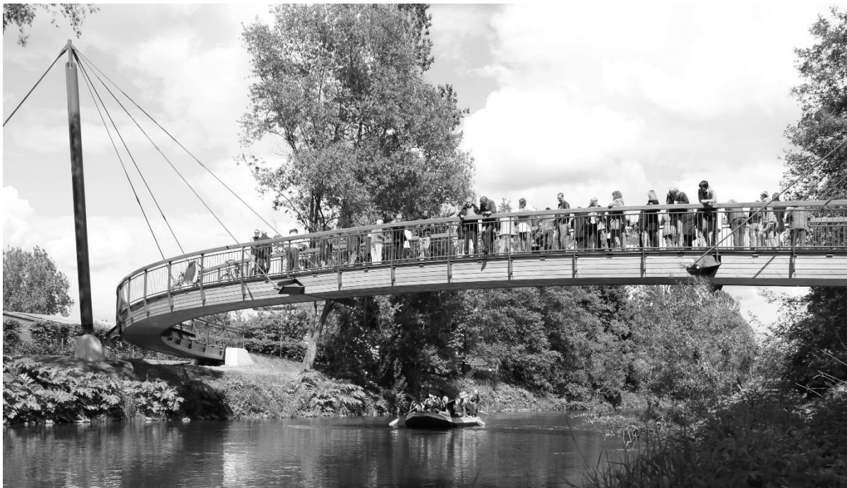
Abbildung 3: Holzbrücke «Aggerbogen» bei Lohmar (Foto: Ilona Schmitz)
