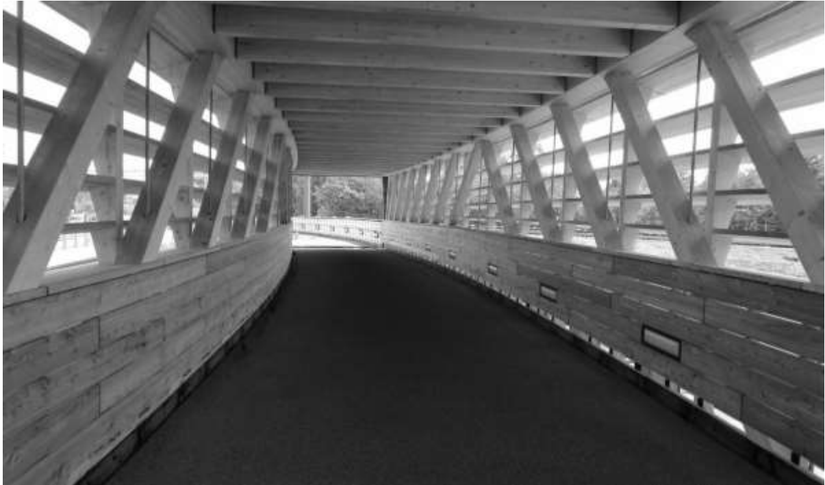
Abbildung 4: Das sichtbare Fachwerk mit den in ihrer Neigung variierenden Diagonalen sowie den Zugstangen aus Stahl lädt zum Verständnis des statischen Systems und seiner Wirkungsweise ein (Quelle JP. Ammann).
