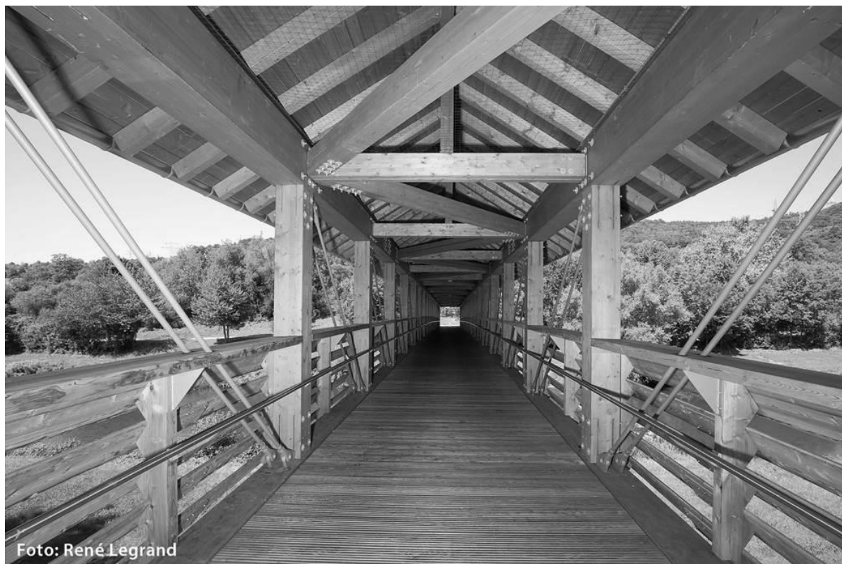
Abbildung 2: Konstruktiver Holzschutz Fachwerkbrücke Lörrach
