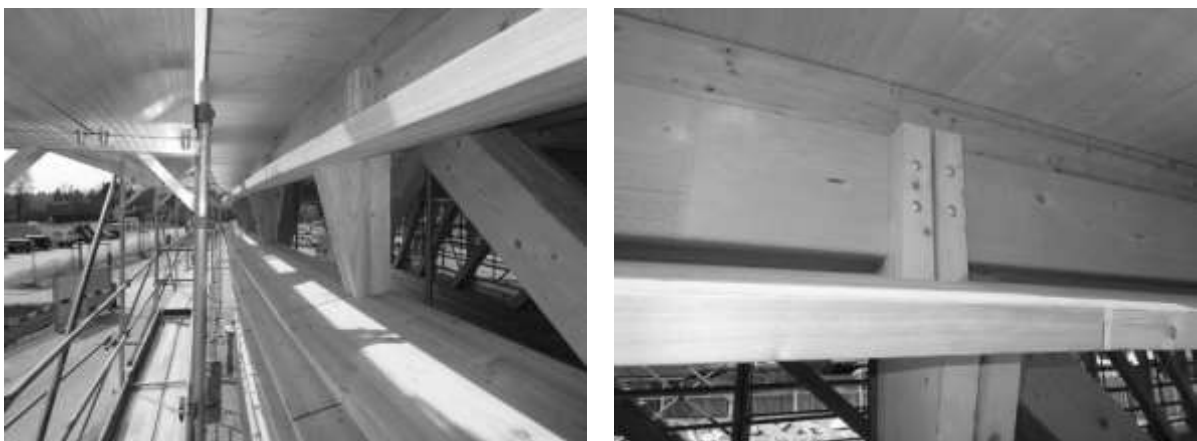
Abbildung 12: Montage der Fassadenelemente in Modulbauweise (Quelle JP. Ammann).
