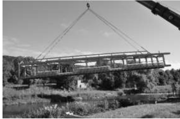
Abbildung 17: Montage 3. Segment, Quelle: HSW-Ingenieure
