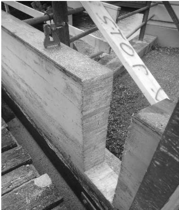
Probeschnitt am Auflager
