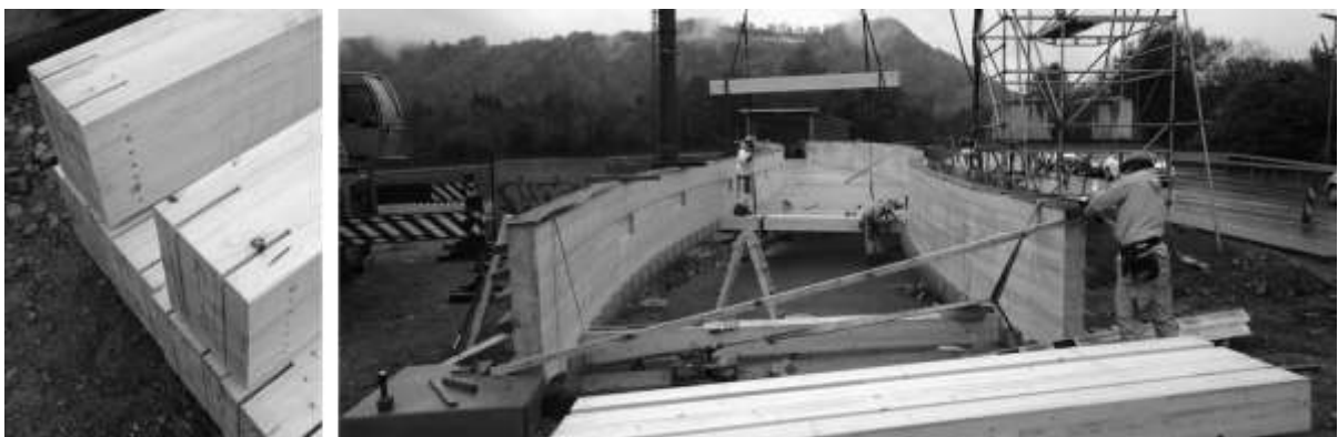
Abbildung 14: Einbau der Querträger im Bereich der Vorlandstege (Quelle JP. Ammann).
