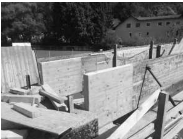
Betonprothesen an allen 4 Auflagern
