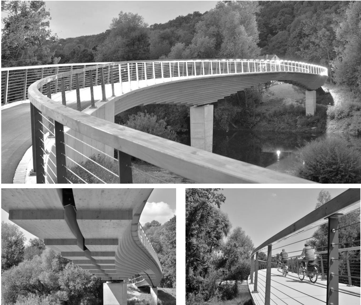
Abbildung 19 bis 20: Fertiggestellte Fußgänger- und Radwegbrücke in Neckartenzlingen (Fotos: Schaffitzel Holzindustrie / Burkhard Walther)
