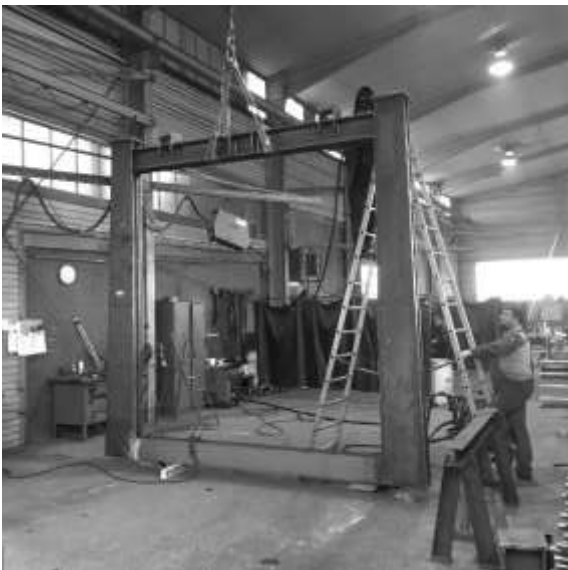
Abbildung 12: Fertigung Stahlbau, Quelle: Schmees & Lühn
