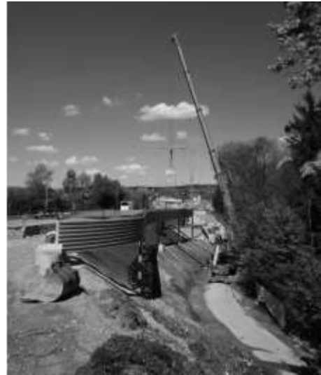
Abbildung 15: Erstellung der PBD-Abdichtung (links), Erstellung der Stege im Bereich Mühle Hunziken (rechts) (Quelle JP. Ammann).
