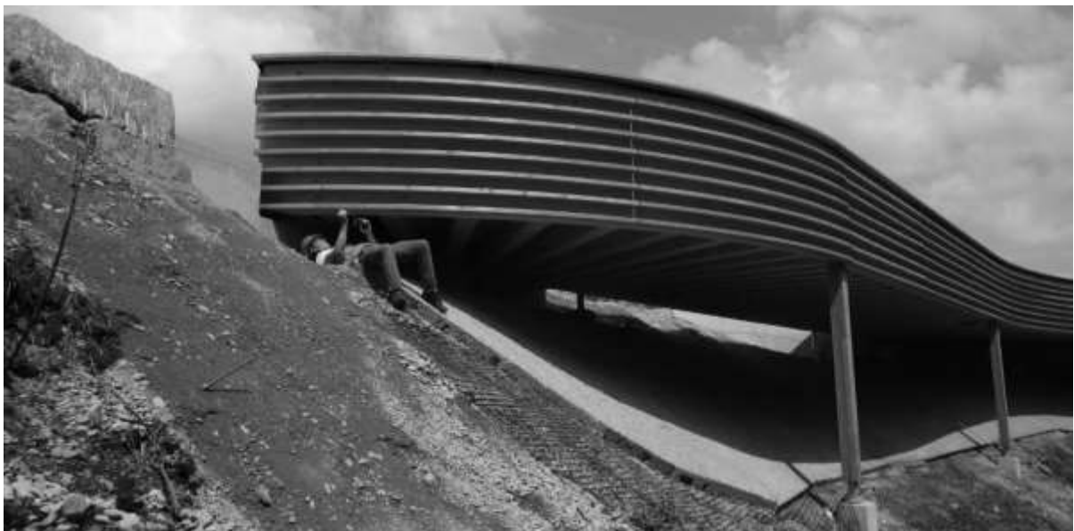
Abbildung 5: Der Trogquerschnitt nimmt teilweise enge Radien auf. Die Tragkonstruktion wird durch Lärchenkeile vor der Witterung geschützt (Quelle JP. Ammann).
