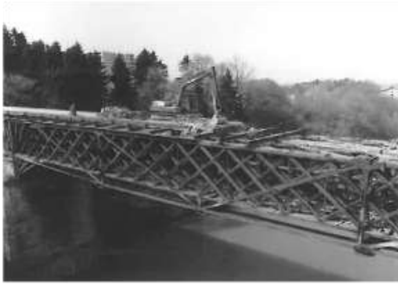
(a) Abräumen der Fahrbahn
