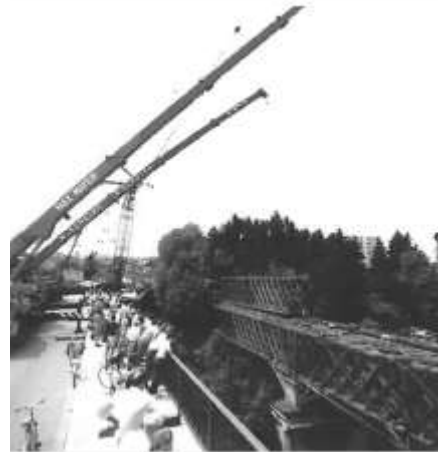
(b) Ausheben der Träger
