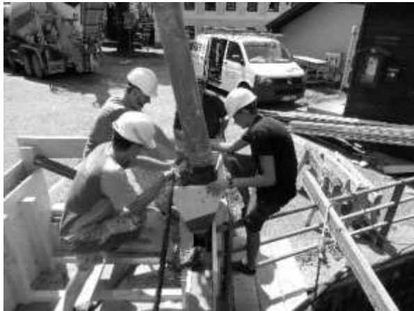
Die Betonage
