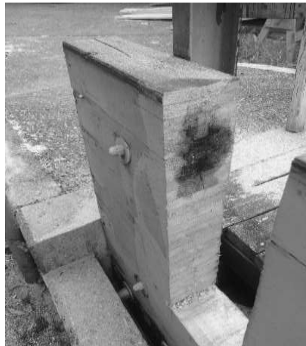
Die wetterabgewandte Seite ist wesentlich besser, nur geringe Schädigung
