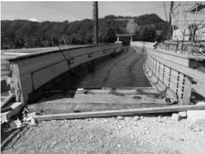
Abbildung 16: Handeinbau des Gussasphalts (Quelle JP. Ammann).
