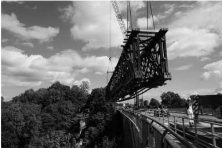
Abbildung 16: Aushubvorgang des mittleren Felds
