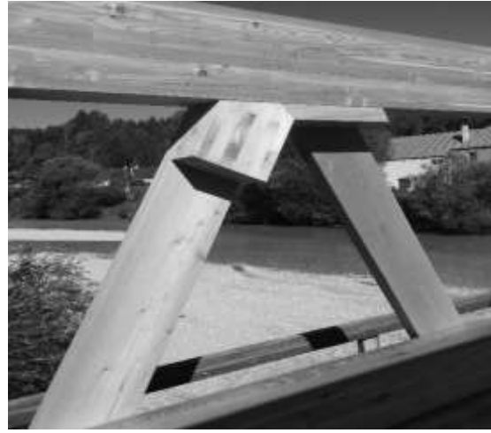
Druckstab Anschlussverstärkung
