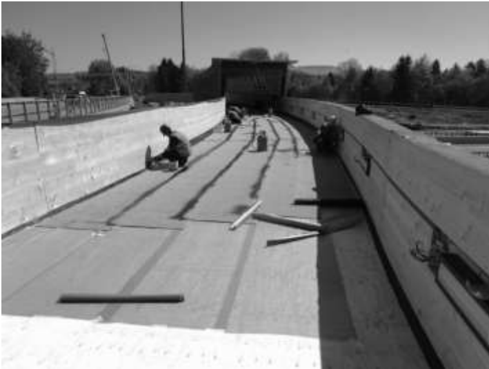
Abbildung 15: Erstellung der PBD-Abdichtung (links), Erstellung der Stege im Bereich Mühle Hunziken (rechts) (Quelle JP. Ammann).
