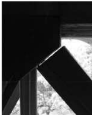
(b) Anschluss der Diagonale an die Schwelle
