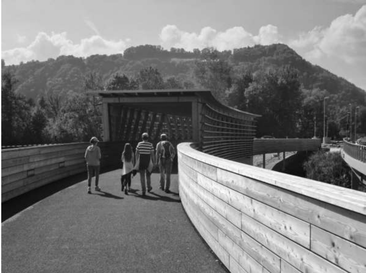
Abbildung 18: Die Holzbrücke Rubigen wird seit Juni 2017 rege von Spaziergängern benutzt (Quelle JP. Ammann).
