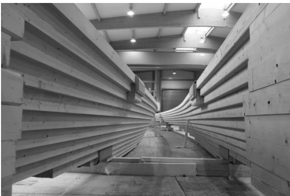
Abbildung 11 und 12: Abbund der Neckartenzlinger Brücke
