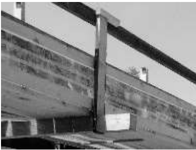
Trägersanierung d. Einkleben von neuem Holz
