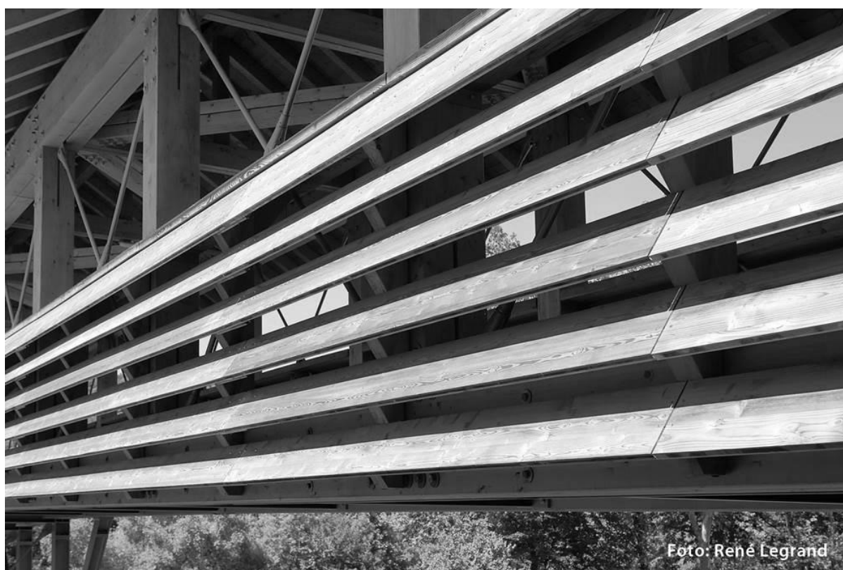
Abbildung 4: Konstruktiver Holzschutz bei der Fachwerkbrücke Lörrach
