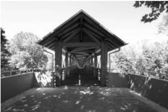
Abbildung 20: Eingang Brücke, Quelle: Markus Ruf
