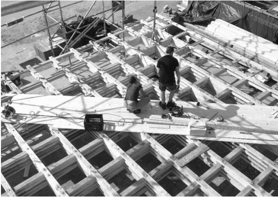
Abbildung 35: Trägerrost aus Altholz
