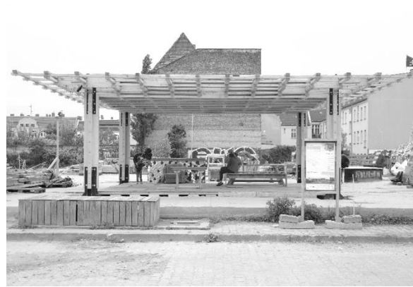
Abbildung 36: Rohbau Holztragwerk aus Altholz
