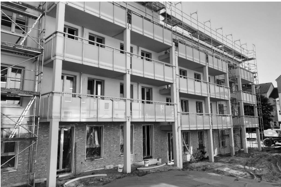
Abbildung 4: Gartenansicht im Bau; Foto: B&O
