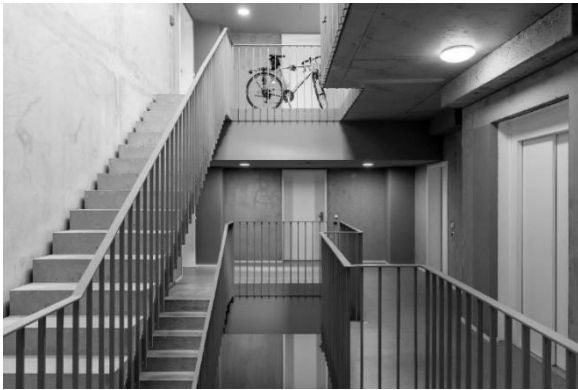
Abbildung 4: Die Erschließungskerne mit Treppen und Fahrstuhl bestehen aus Sichtbeton mit farblich unterschiedlichen Akzenten. Oberlichter in allen Treppenhäusern sorgen für eine natürliche Belichtung. (Bildquelle: Erik-Jan Ouwerkerk)
