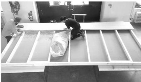
Abbildung 16: Holzrahmen mit Ständern, Einbringen der Einblasdämmung
