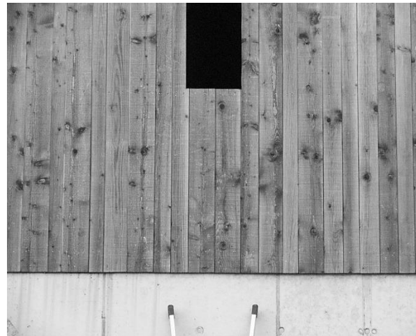
Abbildung 17: Vorvergraute Fassade (westexpnirt) nach 5 Jahren Nutzungsdauer, das Erscheinungsbild ist relativ gleichmässig und vermittelt den natürlichen Holzcharakter (Volkmer und Höltschi 2008)
