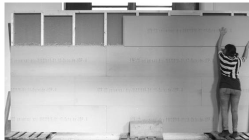
Abbildung 17: Befestigung der Holzweichfaserplatten (aussenseitig)
