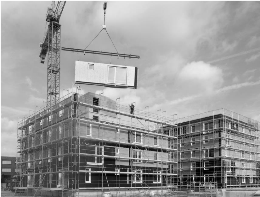
Abbildung 7: Montage Brettsper Holz
