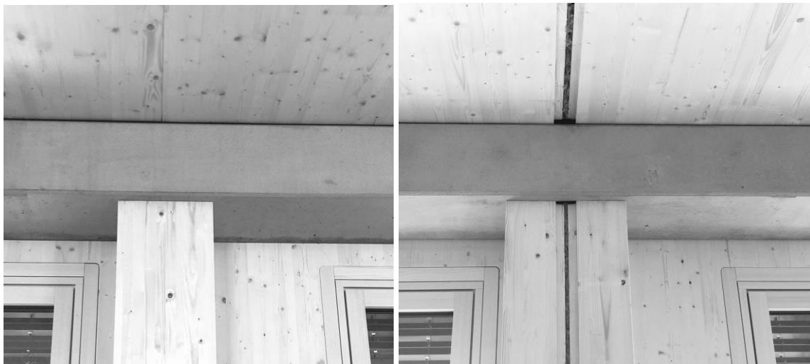
Abbildung: Fotos: Ausführung ohne/mit Schalltrennfugen
