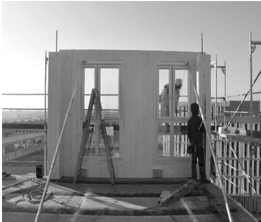
Abbildung: Montage Fassadenelement
