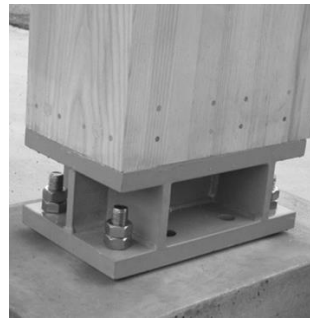
Abbildung 21: Geschraubte Verbindung Stütze - Fundament
