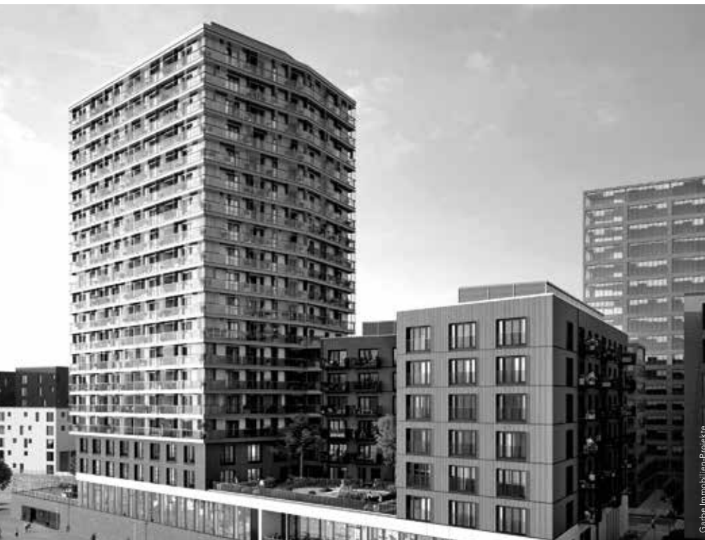
Deutschlands höchstes Holzhaus „Roots“, Hamburg (DE). 65 m, 20 Etagen, 16 in Holzbauweise.
