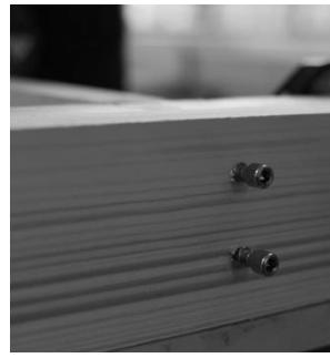
Abbildung 20: Geschraubte Verbindung Fassadenelement
