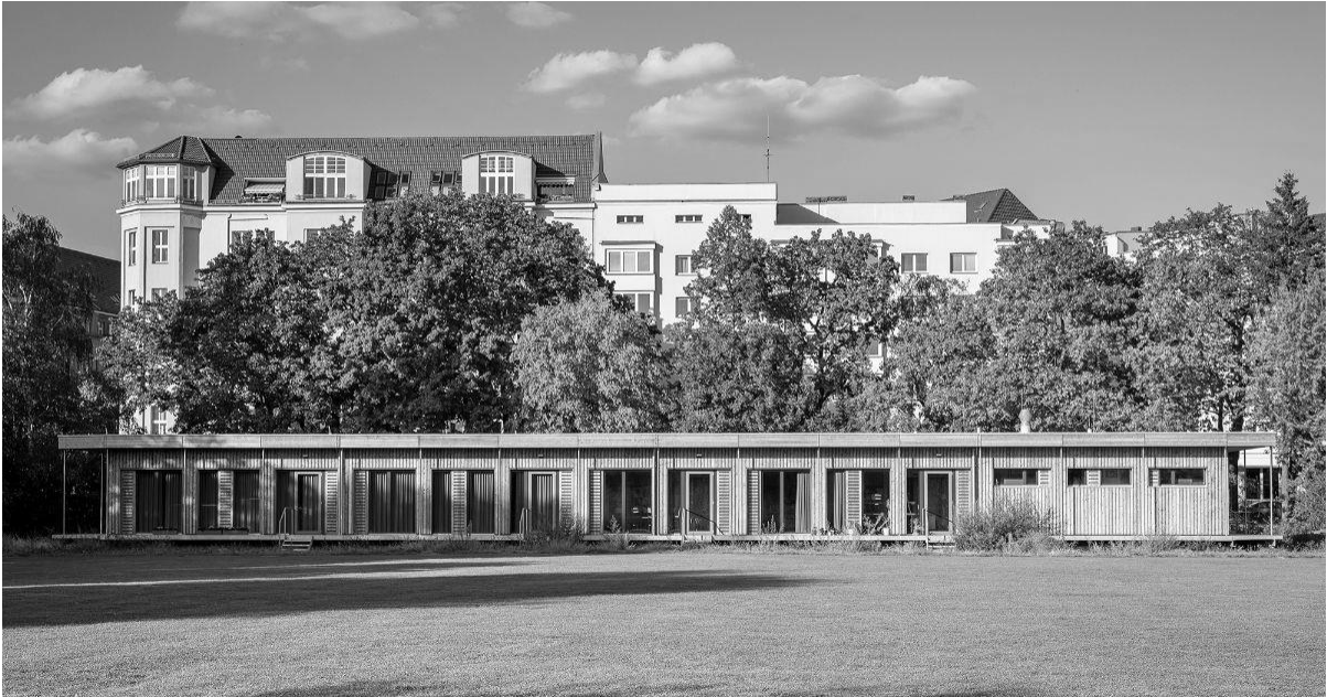
Abbildung 5: DFK1.0 – Nach Fertigstellung (© Lehmann Gruppe)
