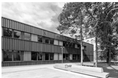
Abbildung 32: Neubau mit Bestandsgebäude und Außenanlagen
