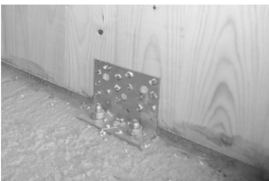
Abbildung 5: Vollholzwand mit Schallschutzlager und ohne schallentkoppelten Befestigungsmittel
