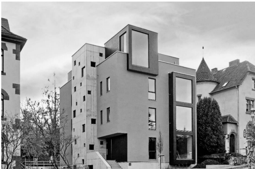
Abbildung 1: Auskragungen und Vorsprünge des Mehrfamilienhauses in Weimar als moderne Antwort auf die benachbarten Jugendstilbauten mit Türmchen und Erkern. Eine besondere Gestaltungsqualität erhält der Holzbau durch das entkoppelte Treppenhaus aus Sichtbeton. (Bildquelle: UTB Projektmanagement GmbH)
