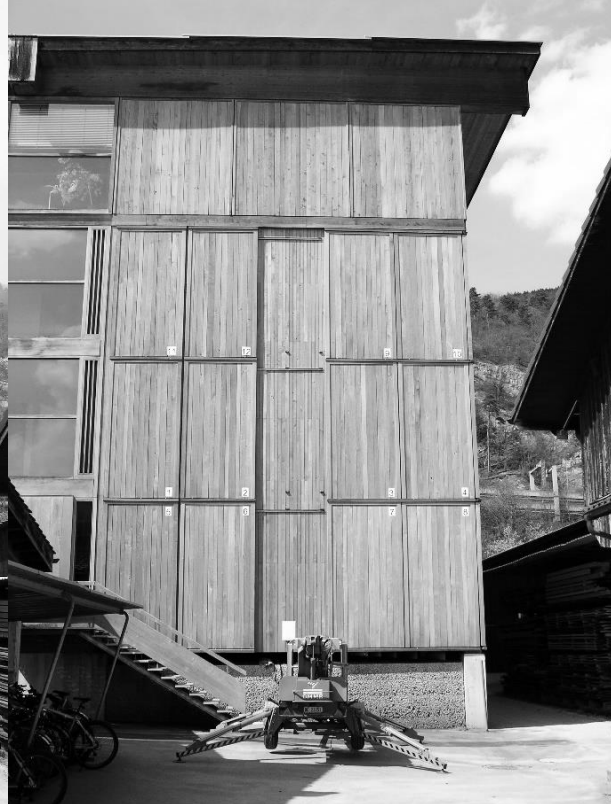
Abbildung 6: Südseite der Fachhochschule in Biel/Bienne nach 9 Jahren Bewitterung und anschließender Reinigung
