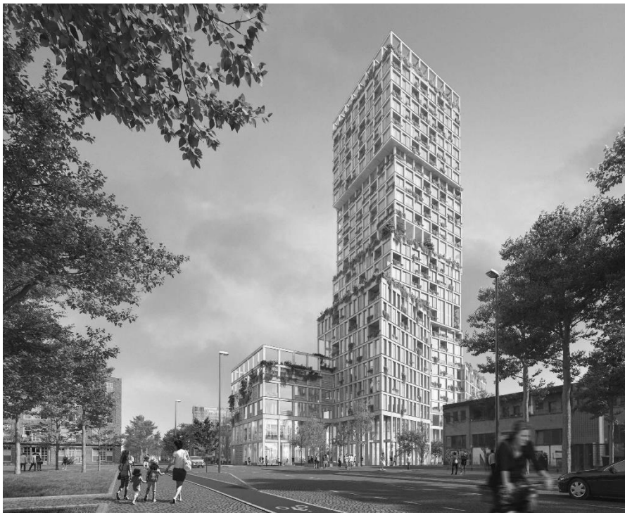
Abbildung 7: Die Fassaden des WoHo in der Schöneberger Straße sind repetitiv durch ein Grundraster. Die Module werden in unterschiedlichem Umfang mit Glas und anderen Fassadenmaterialien gefüllt und modular vorgefertigt. Für die Erstellung der Fassade gibt es 9 Grundmodule, was eine hohe Varianz bei gleichzeitiger Standardisierung und Kostenoptimierung ermöglicht. (Bildquelle: Mad arkitektur)
