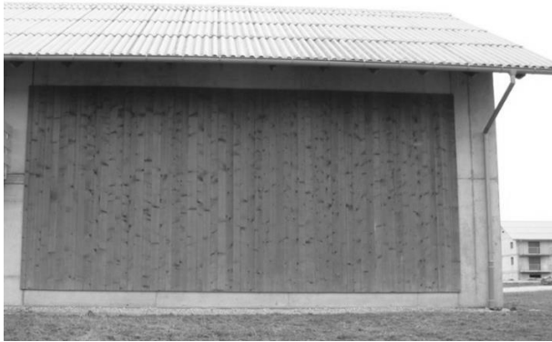
Abbildung 7: Druckimprägnierte Fassade nach 6 Jahren Nutzungsdauer (ostexponiert), das Erscheinungsbild ist sehr gleichmässig (Volkmer und Höltschi 2008)
