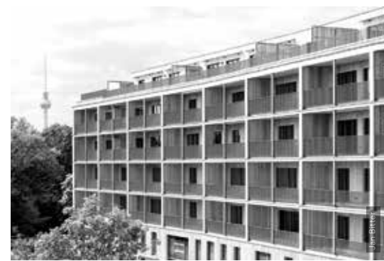
Mehrgeschossiger Holzbau, Walden 48, Berlin (DE)
