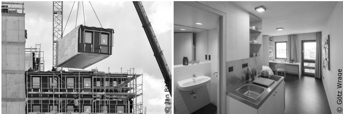
Abbildung 4: Vorgefertigte Holzmodule werden auf der Baustelle an die entsprechende Position eingehoben
