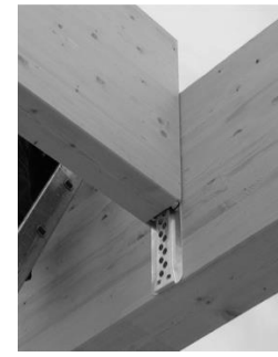
Abbildung 22: Reversibler Balken- schuh (© Sherpa)
