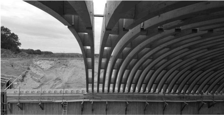
Abbildung 16: Untersicht Bogenbinder zwischen den Achsen 20 und 30
