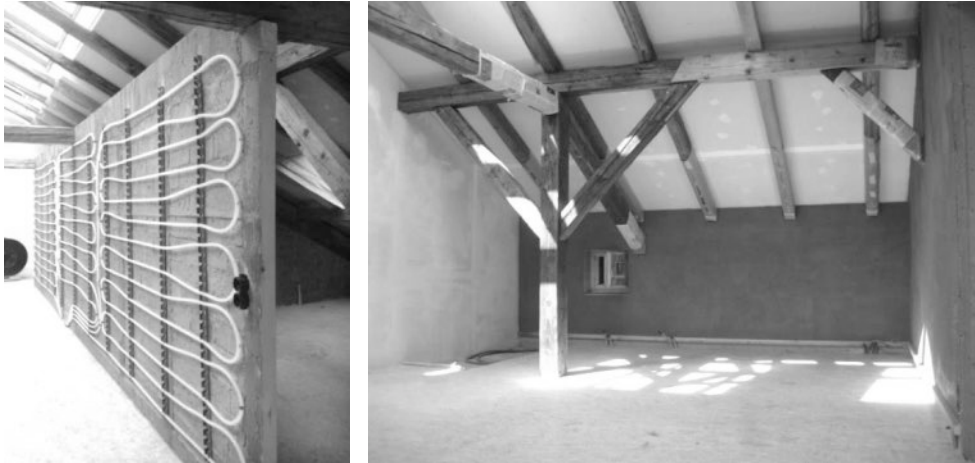
Abbildung 30: Bauprozess Innenwände mit Lehmsteinen und Lehmputzen
