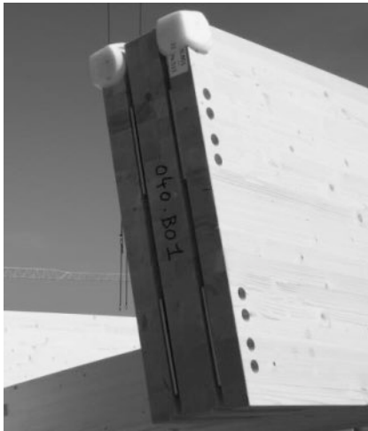
Abbildung 11: Längsstoss
