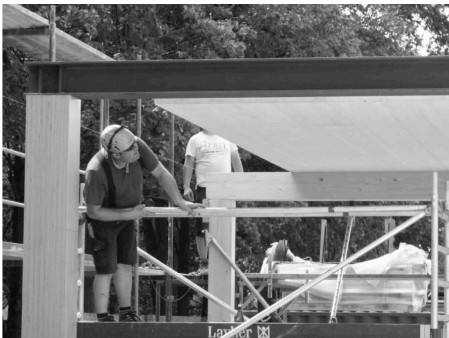
Abbildung 3: Montage der Deckenelement auf den Unterzügen
