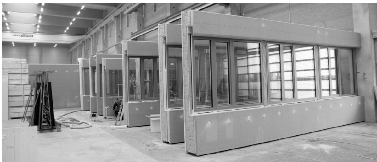
Abbildung 14: Vorfertigung der Elemente
