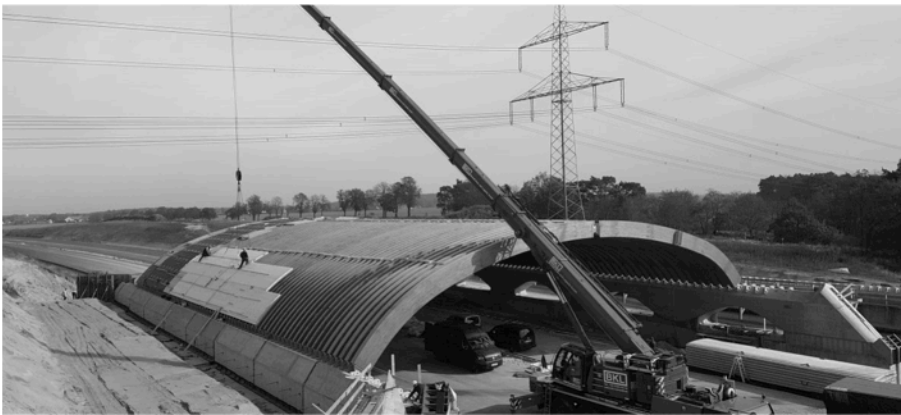
Abbildung 17: Auflegen der BSP-Elemente auf die Bogenbinder zwischen Achse 20 und 30
