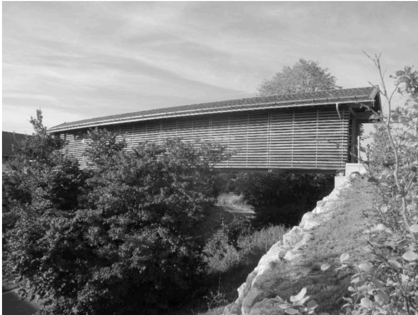
Abbildung 17: Brücke nach dem ersten Jahr
