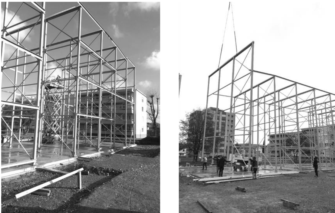
Abbildung 8: Das Stahltragwerk wird in Lenzburg aufgebaut.
