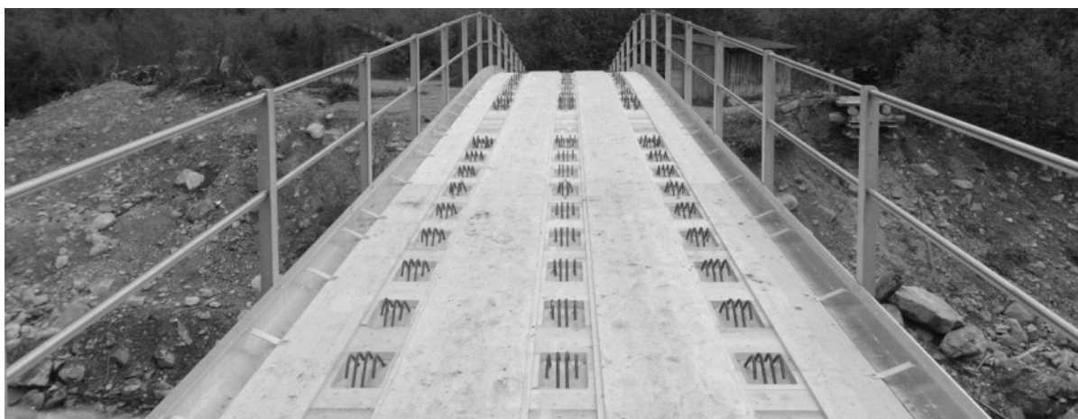
Abbildung 5: Vorgefertigte Schalungselemente und eingeleimte Schubverbinder
