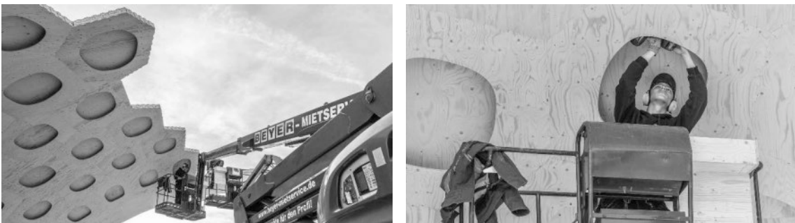
Abbildung 11+12: Aufbau der Schalenkassetten im freien Vorbau. Fugen zwischen den Kassetten werden durch das Anziehen der Bolzen geschlossen, bis alle Kassetten direkt aneinanderstoßen.
