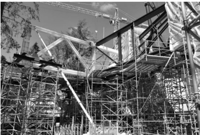
Abbildung 9: Ausführung Gerüste, Quelle: ZÜBLIN Timber/ © Achim Birnbaum
