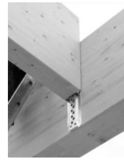
Abbildung 23: Reversibler Balken- schuh (© Sherpa)
