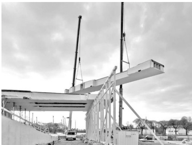
Abbildung 13: Montage Hohlkastenelemente
