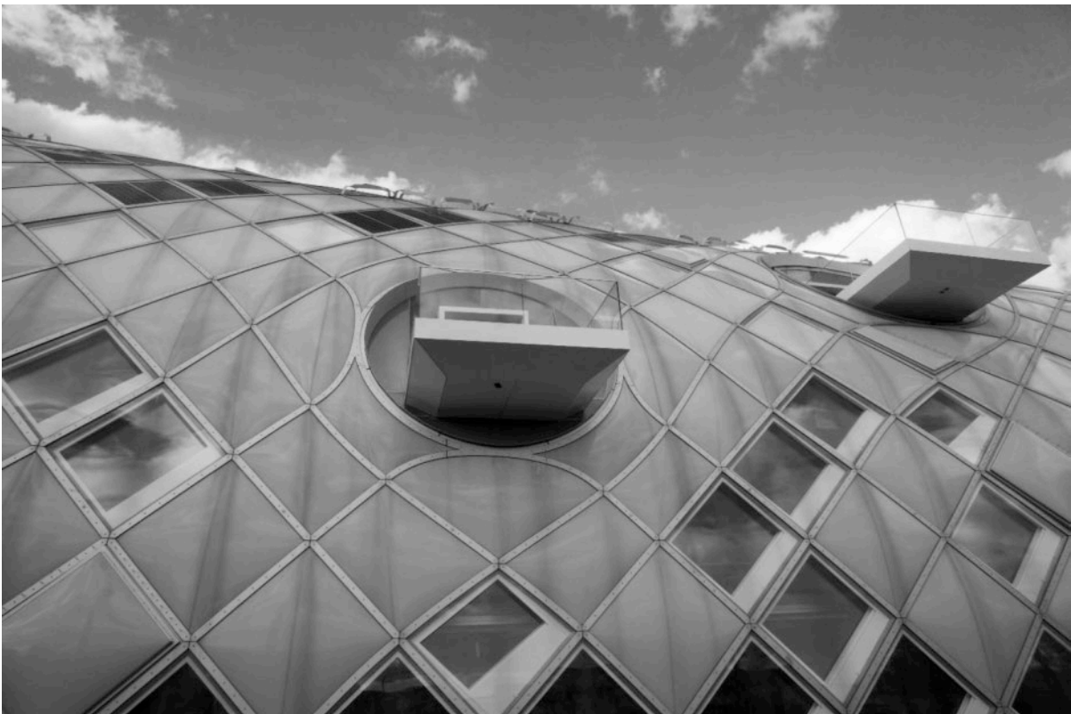
Abbildung 16: Vier der neun Elementtypen (ETFE, Glas, Opak, PV, öffentbare ETFE) und die Balkone in der Fassade.
