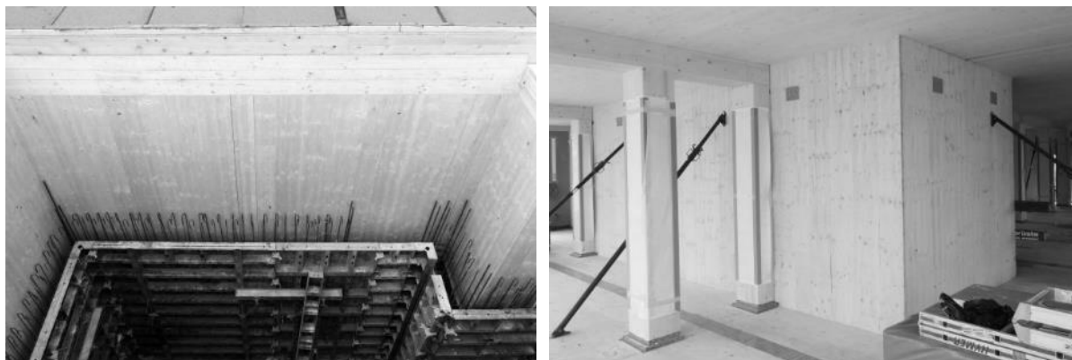
Abbildung 7: Die Dreischichtplatten sind gleichzeitig die Innenwand auf der Rauminnenseite und die (verlorene) Schalung für den Treppenhauskern aus Beton. Und: Die Treppenhauswand wird nicht dicker als in Massivbauweise. (Aufbau Monolithisch 25 cm, hier nur 20cm Beton 42 mm DSP, 15 mm Gips zum Abdecken der Bindelöcher).
