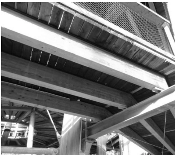
Abbildung 6: 60° – Regel richtig angewandt (von WIEHAG ausgeführt)
