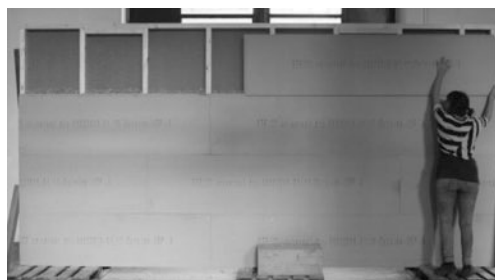
Abbildung 18: Befestigung der Holzweichfaserplatten (außenseitig)
