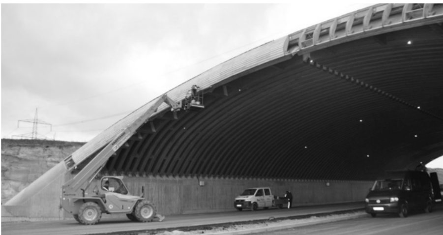
Abbildung 20: Anbringen der Verschalung und der Regenrinnen am Portalbogen
