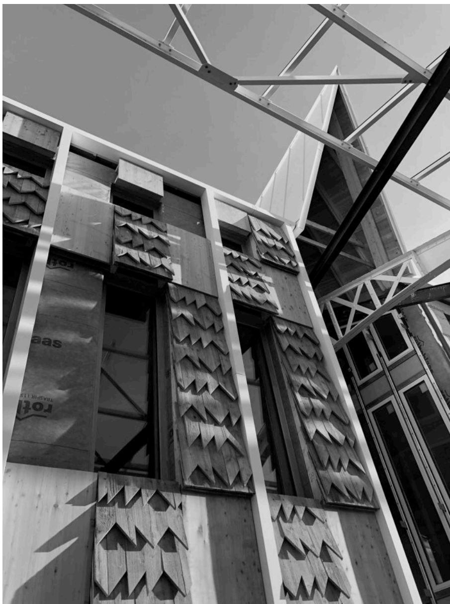
Image 2 : Bardage bois en bardeaux et panneaux 3 plis mélèze Crédits : Bastien Lechevalier / Construire
