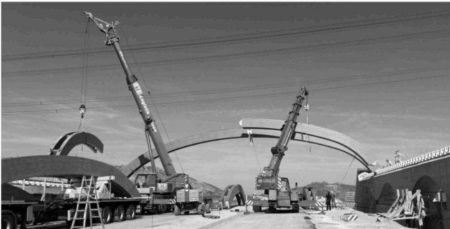
Abbildung 13: Aufrichten der Bogenbinder (Doppelgebände) zwischen den Achsen 20 und 30
