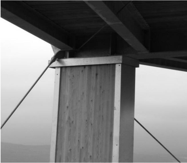
Abbildung 16: Stütze allseitig verkleidet (von WIEHAG ausgeführt)
