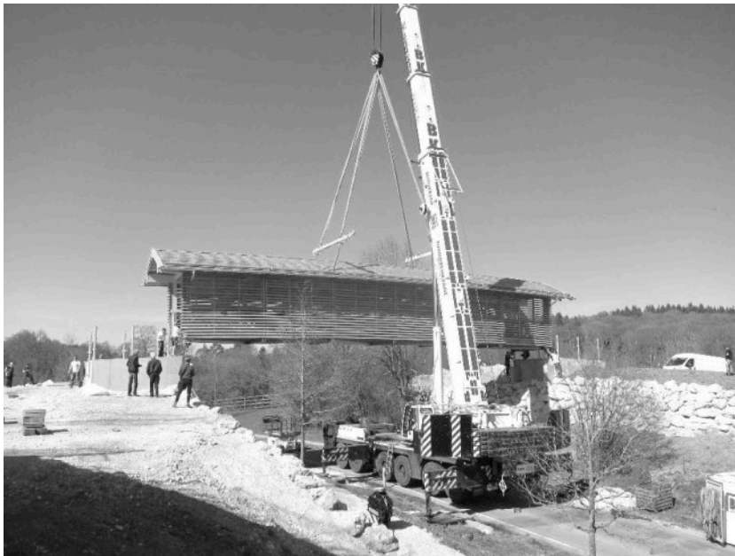
Abbildung 14: Positionierung der Brücke. Einsenken der Einbauteile in die (im Widerlager vorgesehenen) Köcher Abhängen...fertig...Richtfest!
