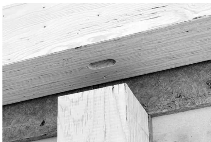
Abbildung 8: Montage Träger auf Stütze
