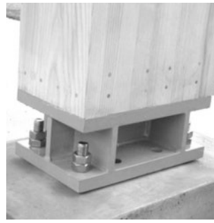
Abbildung 22: Geschraubte Verbindung Stütze - Fundament
