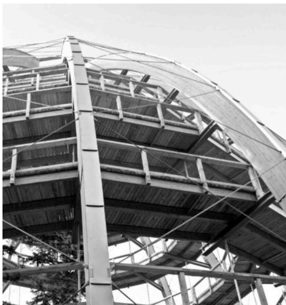
Abbildung 14: Abdeckungsregel konsequent angewandt (von WIEHAG ausgeführt)
