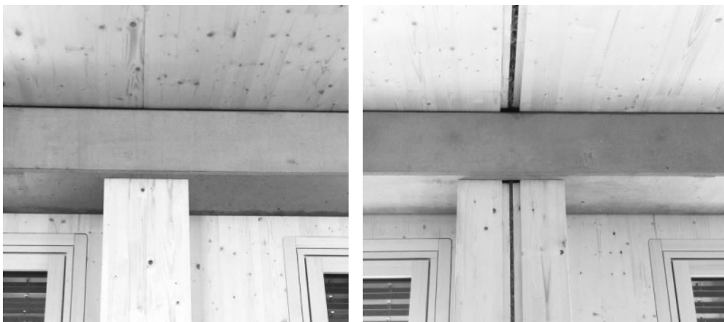
Abbildung 15: Fotos: Ausführung ohne/mit Schalltrennfugen
