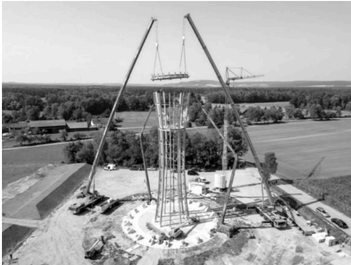
Abbildung 10: Tandemhubmontage oberes Podest Innenturm
