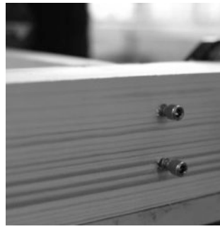
Abbildung 21: Geschraubte Verbindung Fassadenelement
