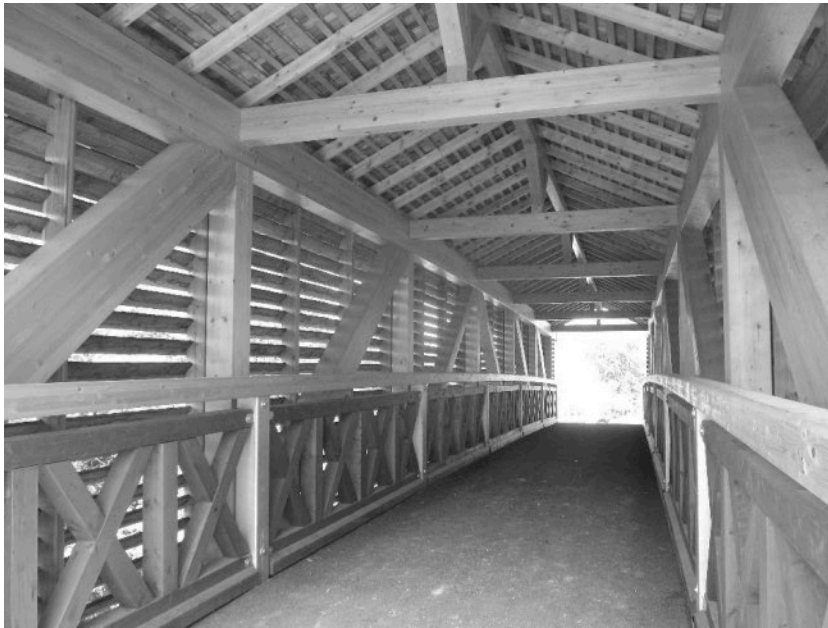
Abbildung 15: Innenansicht «Lichtspiel», Belag aus Gussasphalt
