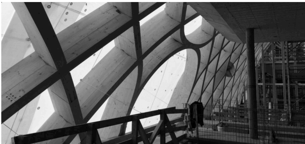
Abbildung 14: Gitterschale mit Balkonöffnung während der Montage, Blick von Innen. SkewLap-Knoten und verschiedene Installationsausschnitte sind gut zu sehen (März 2017)
