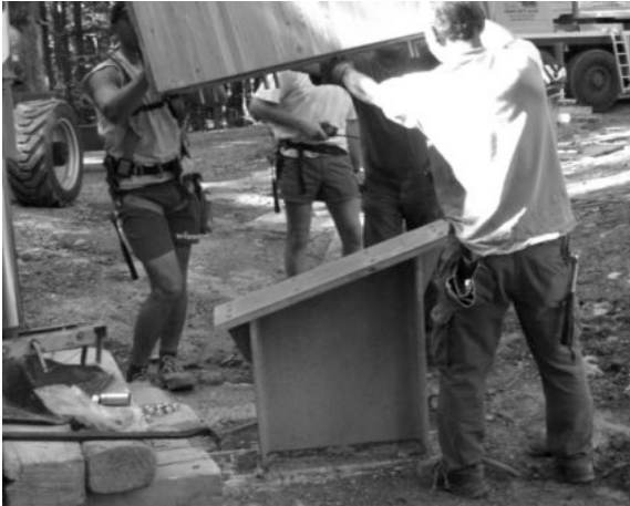
Abbildung 8: Genügend Abstand (von WIEHAG ausgeführt)
