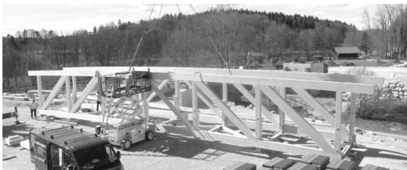
Abbildung 11: Hauptträger – über die Querjoche miteinander verbunden
