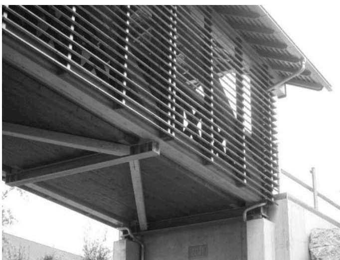
Abbildung 7: Widerlager ohne klassische «Schmutzecken»
