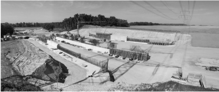
Abbildung 12: Blick auf die Baustelle von der Nordseite, Überlandleitung gut erkennbar
