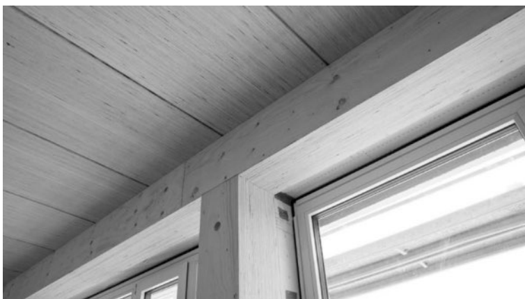
Abbildung 12: sichtbare GLVL Oberflächen
