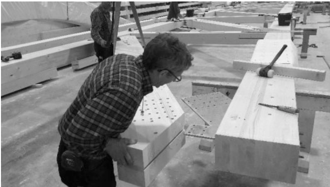
Abbildung 8: Zusammenfügen der einzelnen Stäbe mit Schlitzblech, Stabdübel und Vollgewindeschrauben
