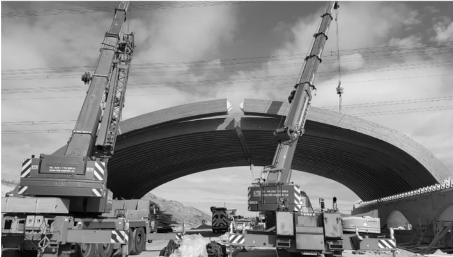
Abbildung 4.1: Firstgelenk zwischen Achse 20 und Achse 30
