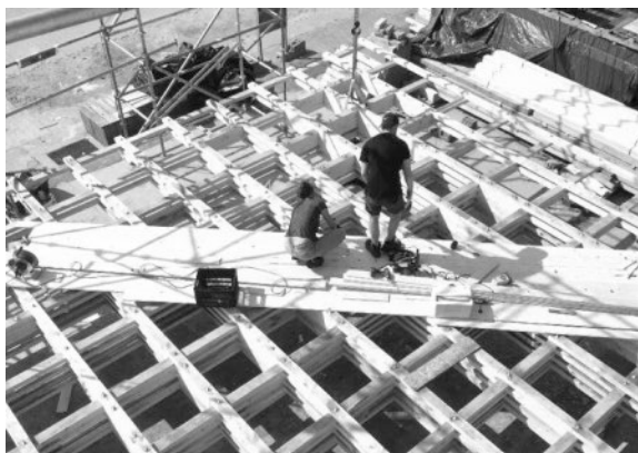
Abbildung 31: Trägerrost aus Altholz
