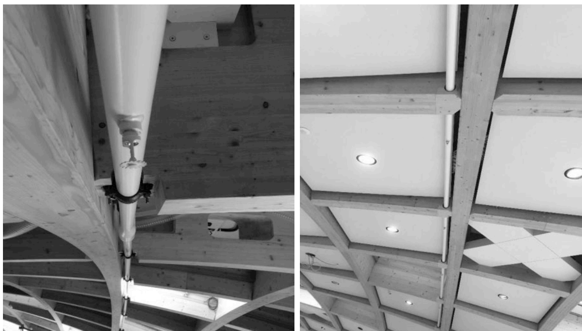
Abbildung 8: Ausschnitte für Sprinklerrohre entlang eines Trägers. Nach der Montage der Rohre wurden die Ausschnitte mit individuell CNC-gefertigten Deckeln verschlossen, so dass die Stossmuffen der Rohre versteckt sind (rechts).
