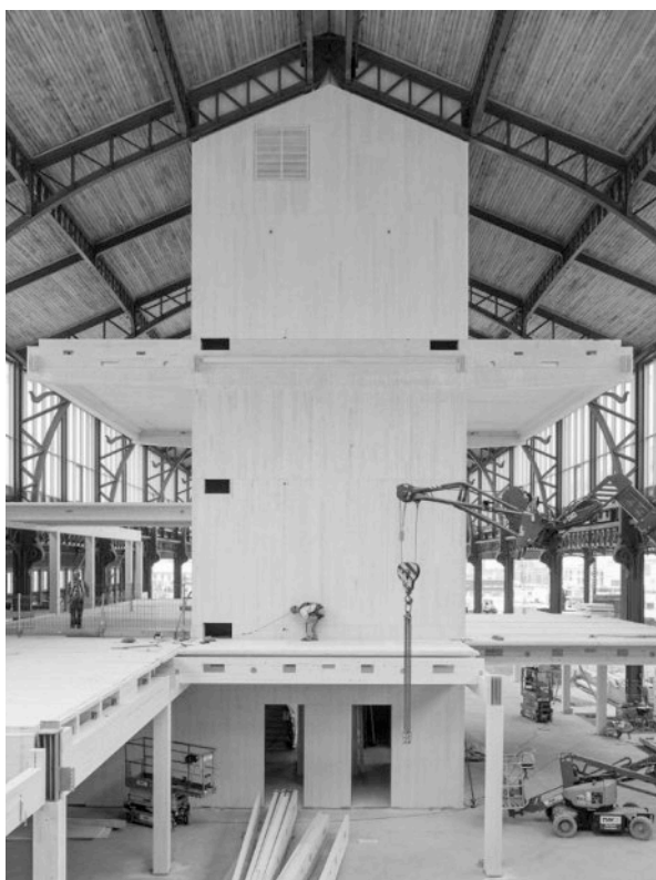
Abbildung 9: viergeschossiger BSP-Kern (Quelle: ZÜBLIN Timber)
