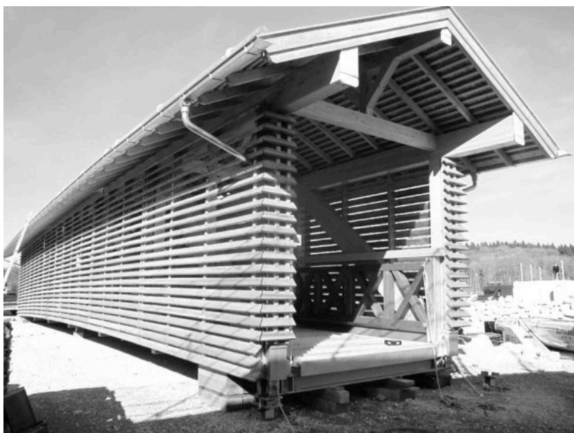
Abbildung 12: fertig vormontierte Brücke
