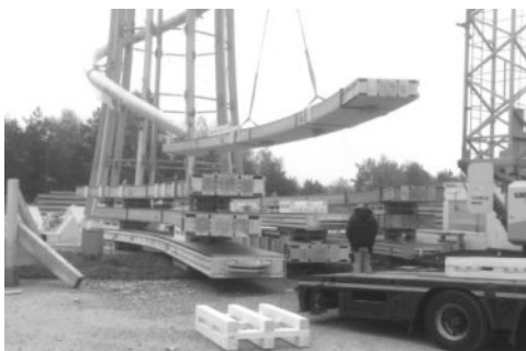
Abbildung 11: Zwischenlagerung Bogenbindersegmente auf der Baustelle
