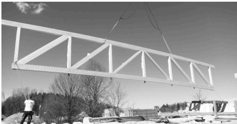
Abbildung 10: Montage auf dem Vorplatz
