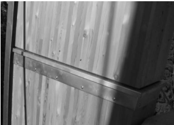
Abbildung 10: Korrekt ausgeführter Stützenstoß (von WIEHAG ausgeführt)
