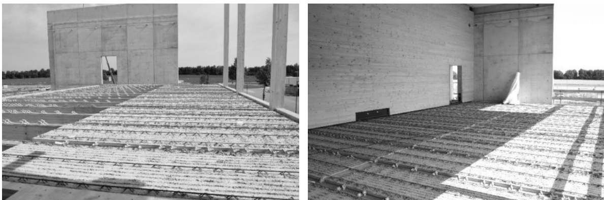
Abbildung 12: HBV-Decke im Montagezustand vor dem betonieren.
