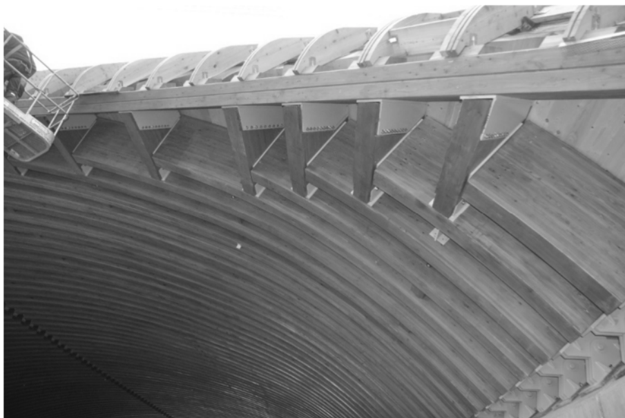
Abbildung 5: Schifterbereiche zwischen Achse 20 und Achse 30
