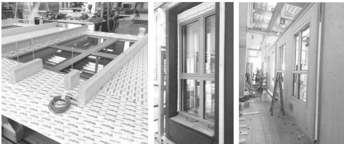
Abbildung 12: Vorfertigung der BSP-Wände
