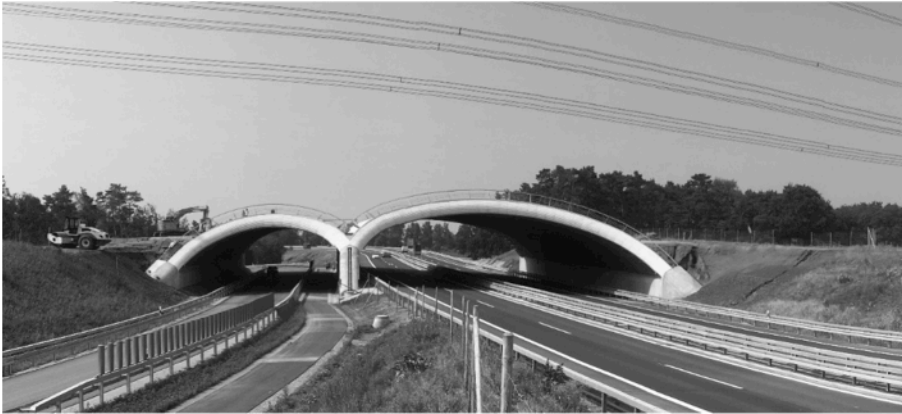
Abbildung 22: Verschalte Portalbögen, aufgebrauchte Abdichtung und Anfüllen
