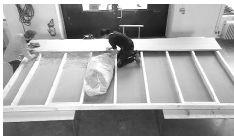
Abbildung 17: Holzrahmen mit Ständern, Einbringen der Einblasdämmung
