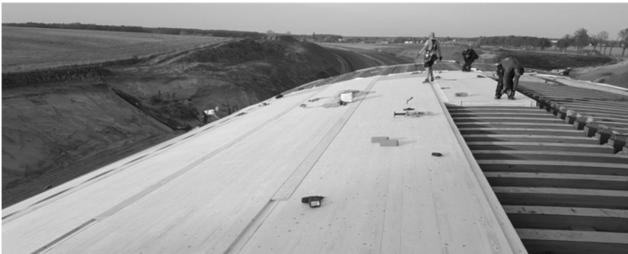
Abbildung 18: Verbinden der BSP-Elemente auf der Konstruktion und untereinander
