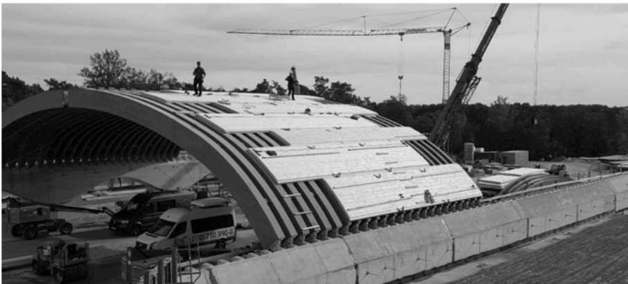
Abbildung 14: Abdecken des ersten Bauabschnitts mit BSP-Elementen
