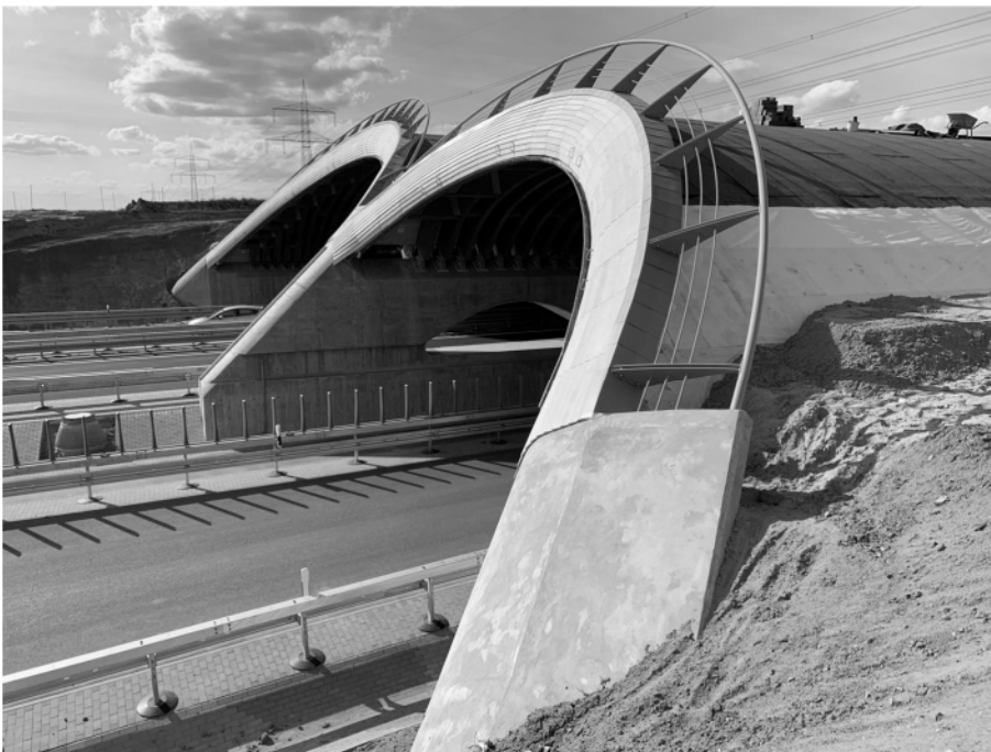
Abbildung 21: Verschalte Portalbögen, aufgebrachte Abdichtung und Anfüllen
