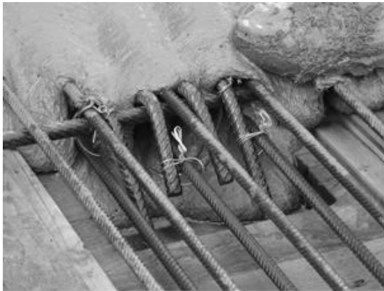
Abbildung 7: Schubverbinder mit Bewehrung
