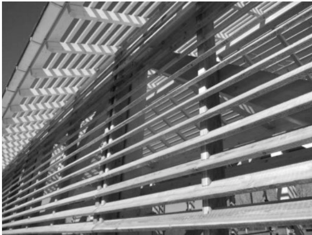
Abbildung 5: Fassadenschalung aus Lärche – Schlagregenneigung 65°
