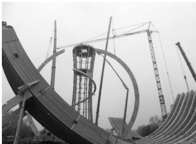
Abbildung 14: parallel versetztes Richten der Kugelbinder
