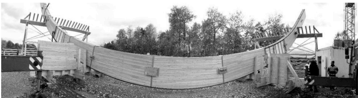
Abbildung 13: vormontierter Kugelbinder im Montagebock
