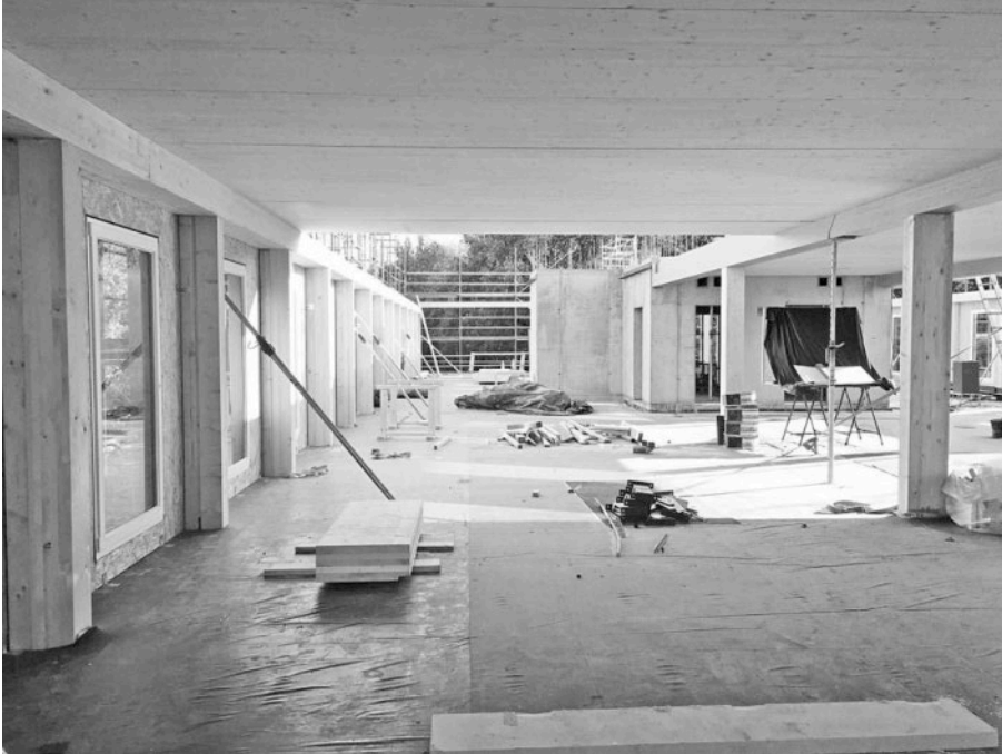
Abbildung 2: Rohbau mit Skelett aus Stützen und Trägern.
