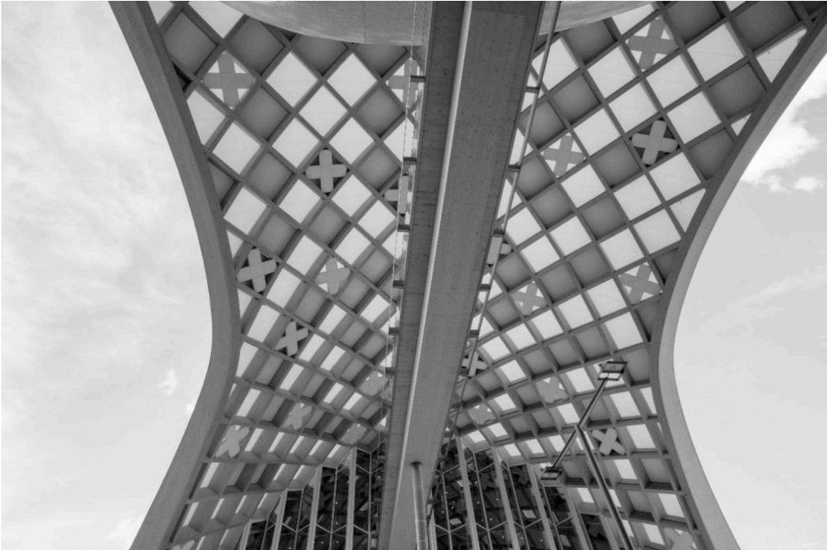
Abbildung 15: Blick von unten in das Dach über der Strasse. Die «Schweizerkreuze» sind nicht nur Ornament sondern wirken im Innenraum auch als Akustik-Paneele.
