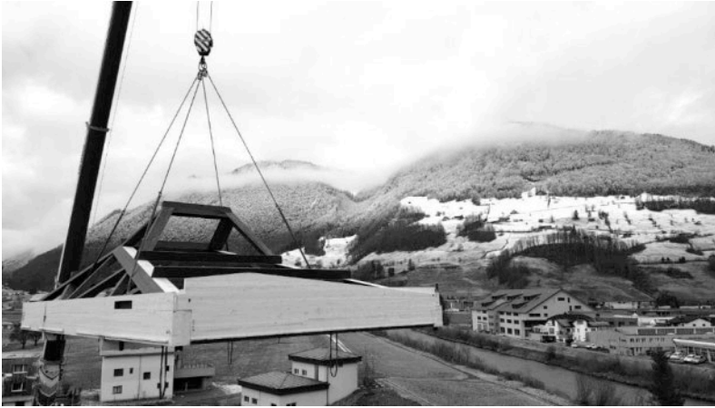
Abbildung 8: zusammengesetzte Dachhaube Fotografie: Pirmin Jung AG, Rain
