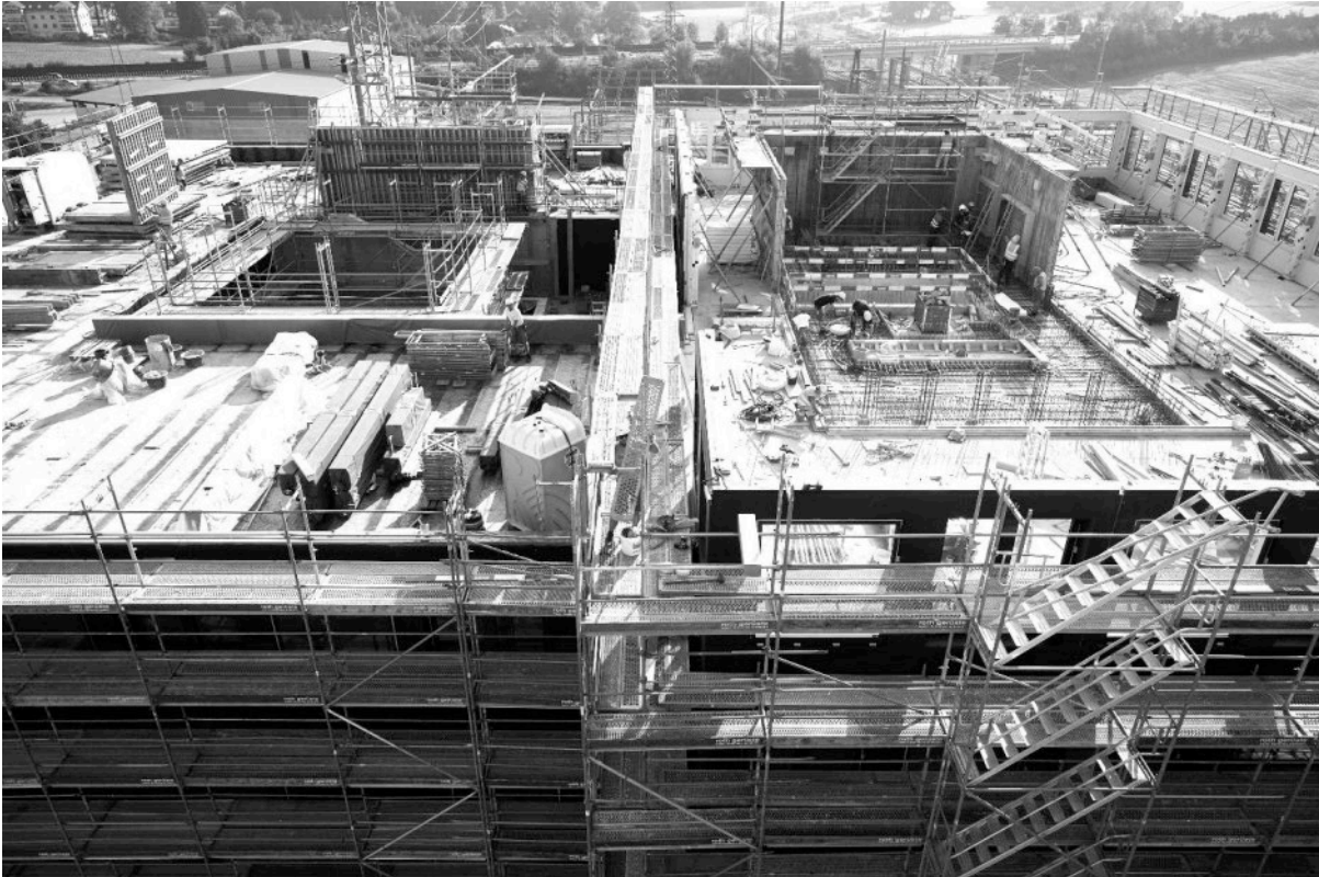
Paralleles Bauen, Holzbau gibt Position der Schalung vor, Wandelemente sind Regendicht
