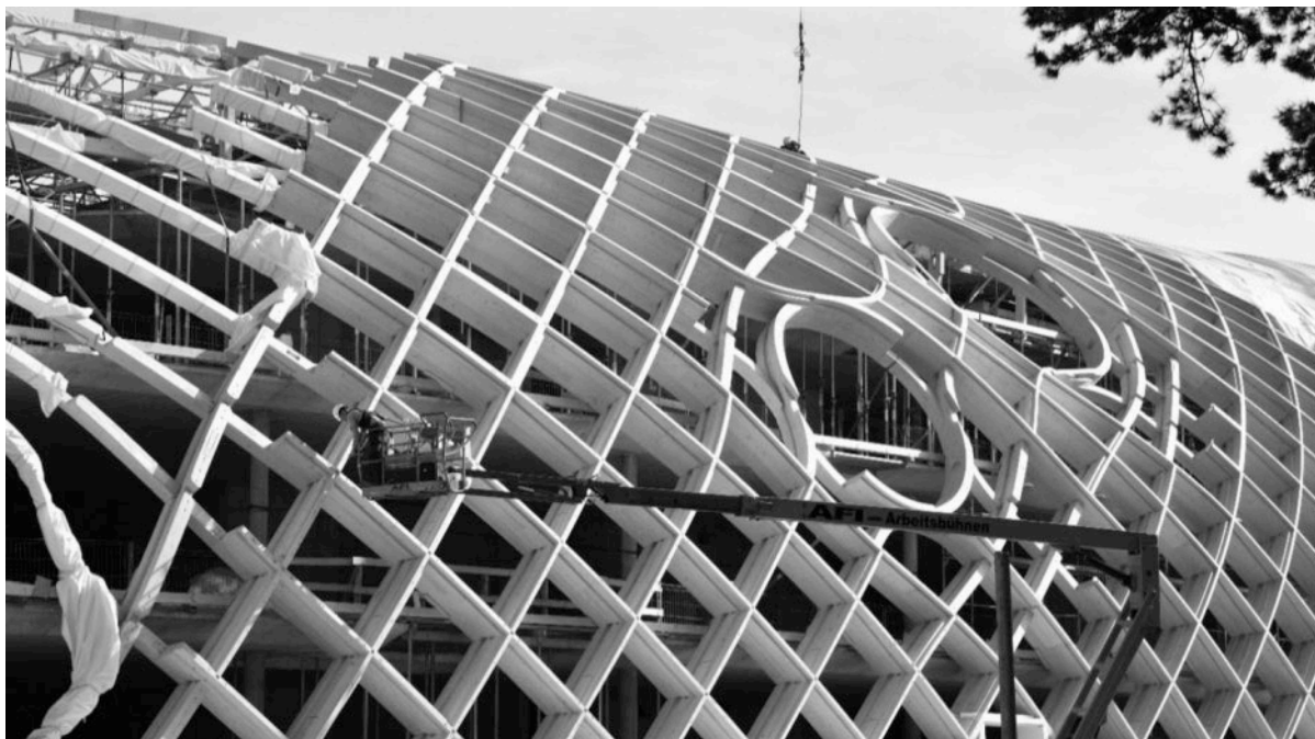
Abbildung 13: Gitterschale während der Installation (Mai 2017)
