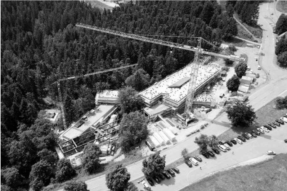
Abbildung 6: Luftbild Baufeld, Quelle: ZÜBLIN Timber
