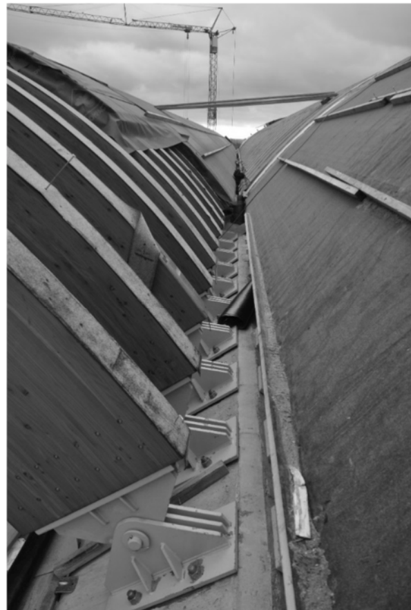
Abbildung 4.2: Auflagerpunkte Achse 20 – rechter Bereich unmittelbar nach Montage der Konstruktion mit aufgelegter Notdichtung
