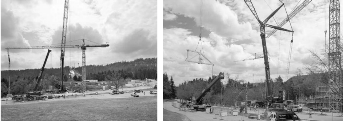
Abbildung 6 und 7: Montageeinsatz mit Mobilkran, Quelle: ZÜBLIN Timber / © Achim Birnbaum
