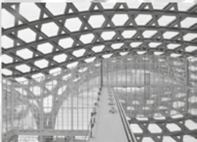
Komplexe Holztragwerke complex timber-structures
