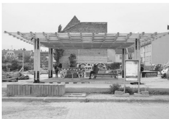
Abbildung 32: Rohbau Holztragwerk aus Altholz
