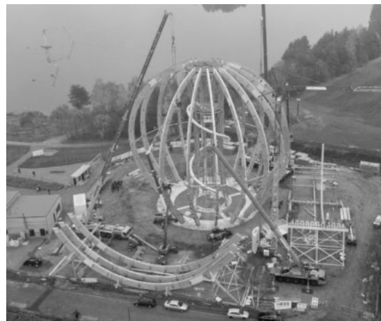
Abbildung 15: Montage Kugelbinder
