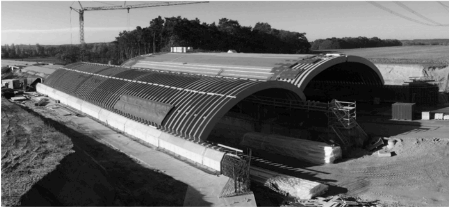
Abbildung 19: Blick auf die gerichteten, parallel verlaufenden Bogentragwerke
