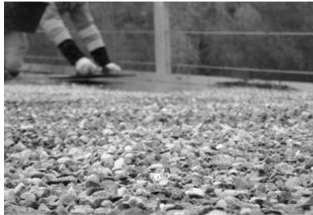
Abbildung 8: Splitt-Einstreuung in UHFB Schlämme
