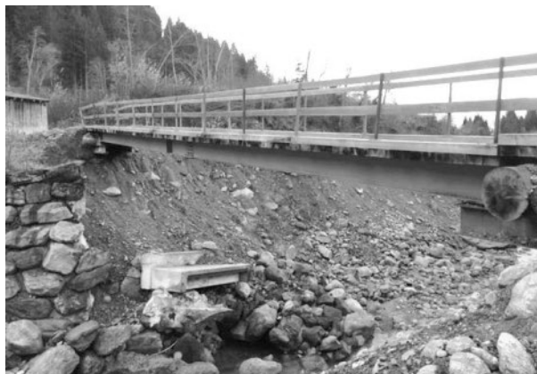
Abbildung 2: Zu ersetzendes Brückenprovisorium
