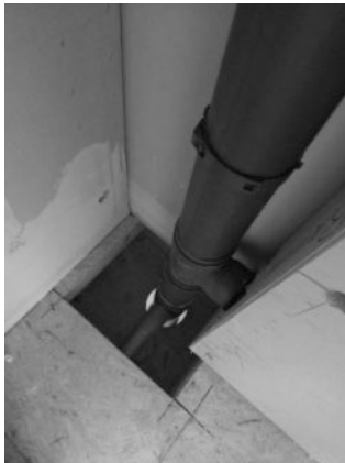
Abbildung 3: Abwasserfallleitung in vorgefertigter Deckenauswechslung
