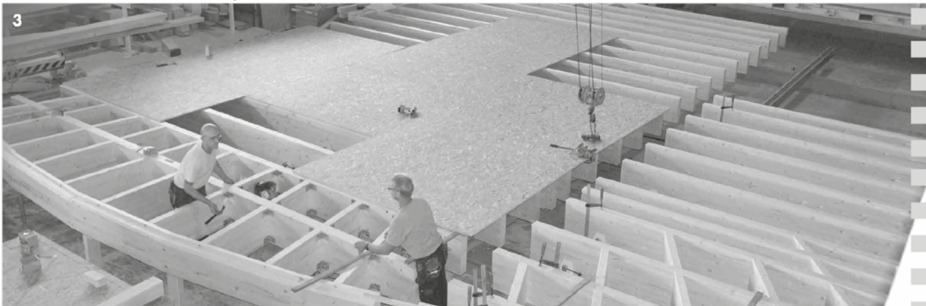
3 / Restaurant: 40 cm hohe Geschosdecke mit gekrümmtem Randträger und ausgespartem Unterzug auf tectofix 3000
