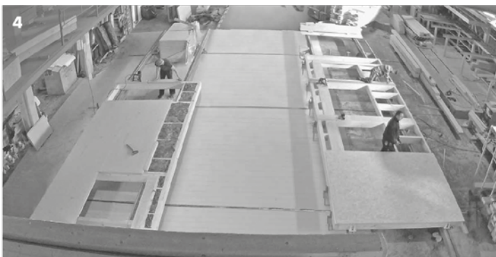
4 / Wandfertigung in idealer Arbeitshöhe: Auch beim Einlegen schwerer Ständer ergonomisch perfekt, da der „Tisch begehbar“ ist
