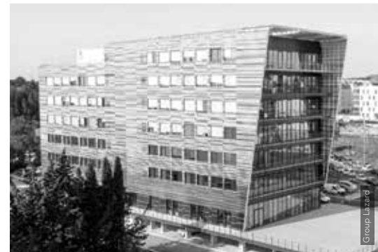
Bürogebäude NEOS, Montpellier
