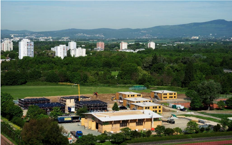
Abbildung 5.: Feldfabrik direkt auf dem Baugrundstück in Frankfurt Ginnheim
