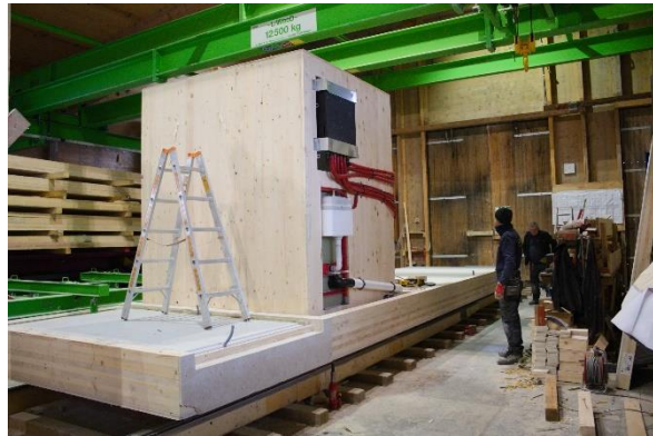
Abbildung 8: Das Badmodul wird auf den vorgesehen Modulen platziert.
