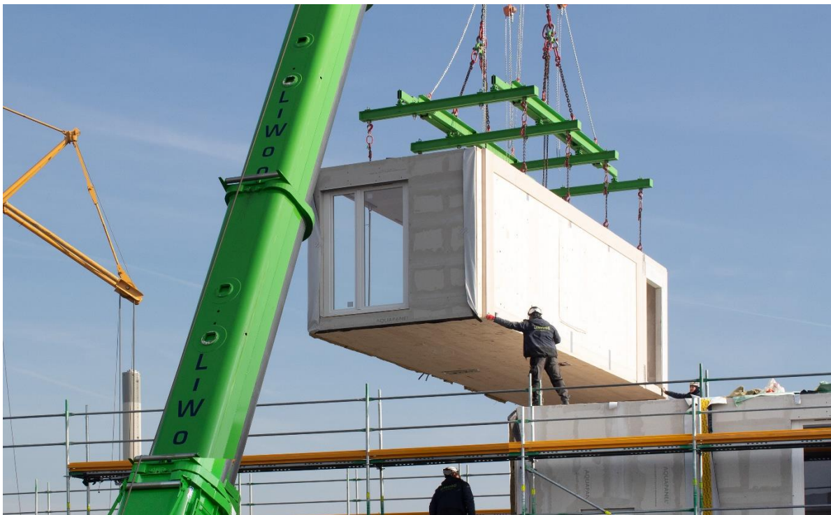
Abbildung 10: Versetzen eines Moduls mit Hilfe eines Autokrans
