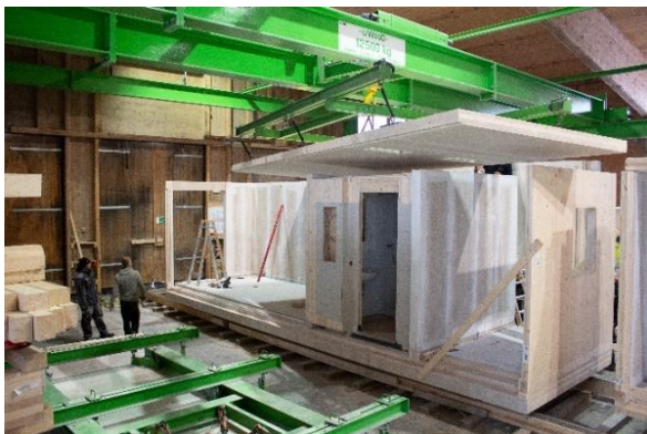
Abbildung 11: Die Decke wird auf das Modul gesetzt
