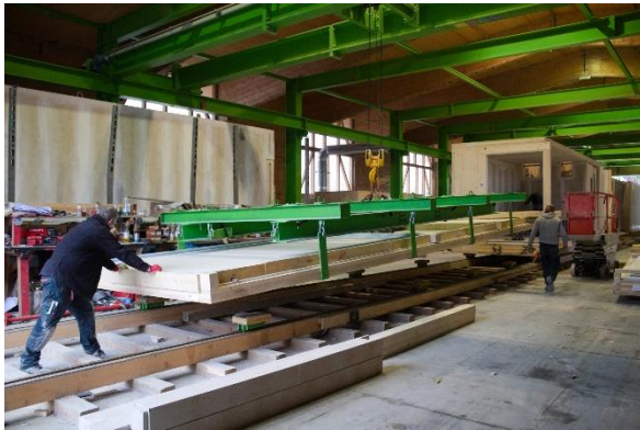
Abbildung 7: Die Bodenplatte wird mittig auf dem Schienensystem positioniert.
