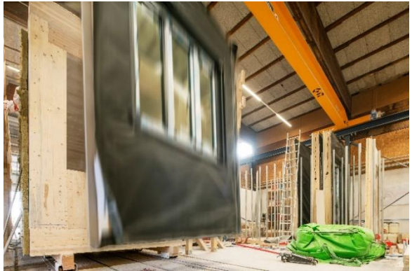
Abbildung 10: Fassadenmontage mit bereits eingebauten Fenstern
