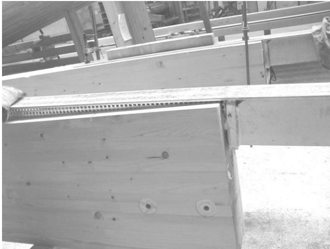
Abbildung 10: Eingespannte Holzstütze bei der Vormontage der HSK-Verbindung
