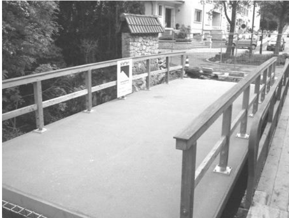
Abbildung 7: Holz-Beton-Verbundbrücken in Kayl (L) und Purkersdorf (A)
