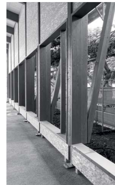
◀ Die Wand- und Dachelemente kamen fix und fertig gedämmt per Lkw. Stützen und Streben wurden im Liegen an die Binder vormontiert, was bei dem engen Platzangebot sehr schwierig war
