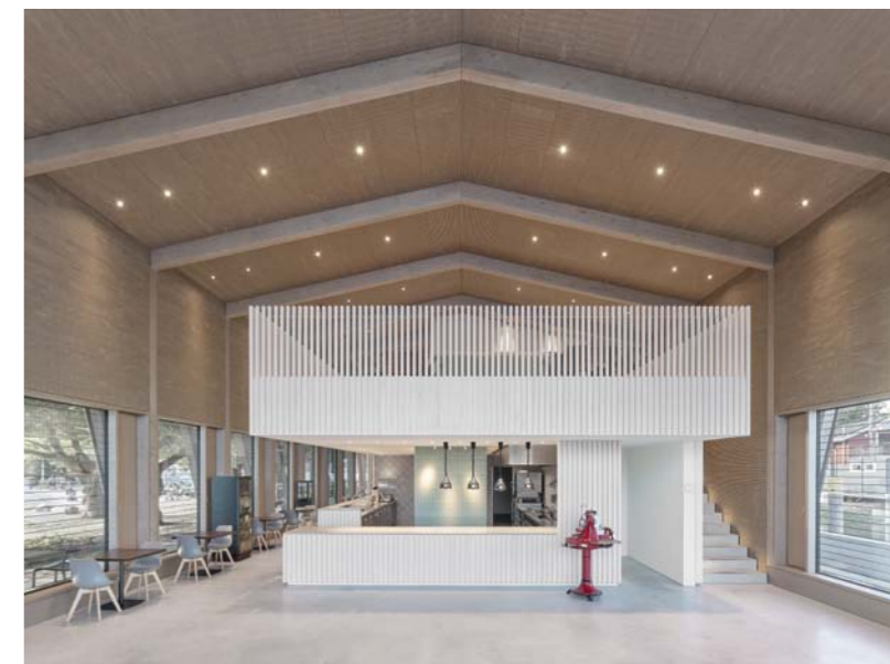
▲ Das gewählte Holztragwerk macht die konsequent nach wirtschaftlichen Gesichtspunkten geplante Halle maximal flexibel. Inspiriert wurde das Gebäude von Schiffshallen
