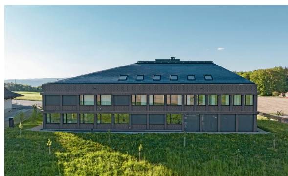
Das Krüpelwalmdach orientiert sich an alten Bauernhäusern.
