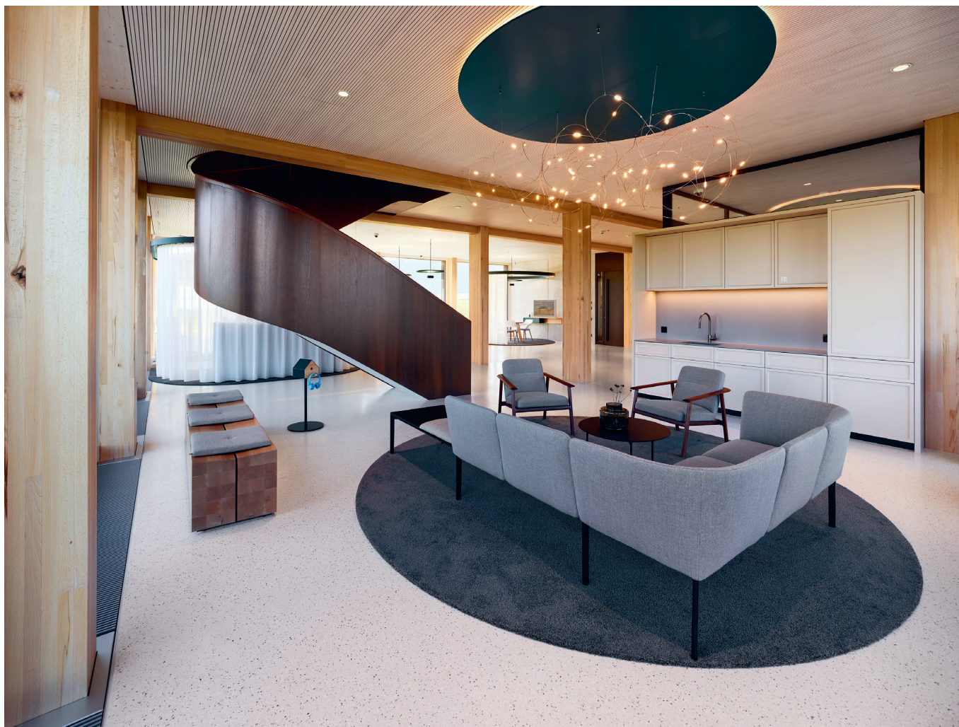
Das sichtbare Primärtragwerk des Holzbaus besteht aus Buchen-Stabschichtholz. Die Oberflächen sind mit einem UV- und Feuchteschutz versehen.
