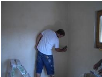
Abbildung 2: IQUH, Innenbekleidung mit Lehmbauplatten und Kalkputz
