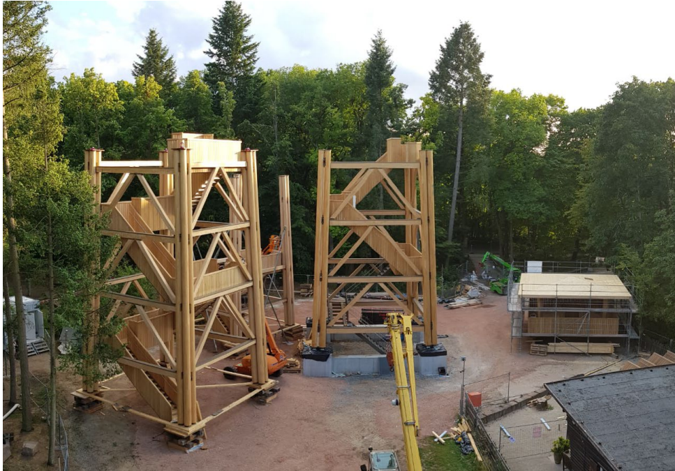
Abbildung 16: Zusammenbau der Turmsegmente
