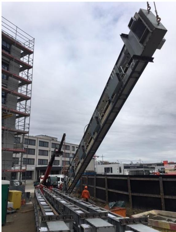
Abbildung 8: Montage der vorgefertigten Steigzone (METHABAU, CH-8580 Amriswil)
