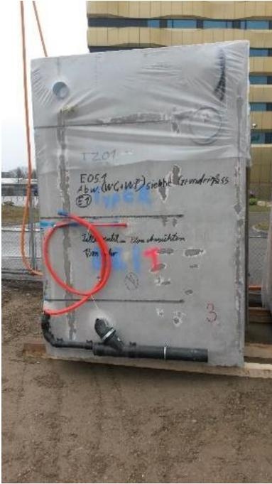
Abbildung 3: Anlieferung der vorgefertigten Sanitärzelle (Bild: ZURFLUH LOTTENBACH GMBH, Luzern)
