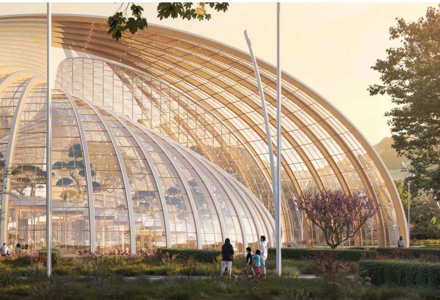
▲ Der Architekt setzt bei der Tragstruktur auf CLT
