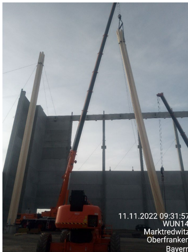
Abbildung 6: Aufstellen der 36 m hohen Stützen
