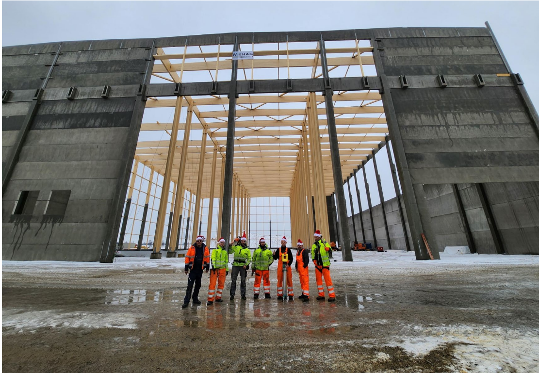
Abbildung 9: Bilder von der Montage des 36 m hohen Hochregallagers
