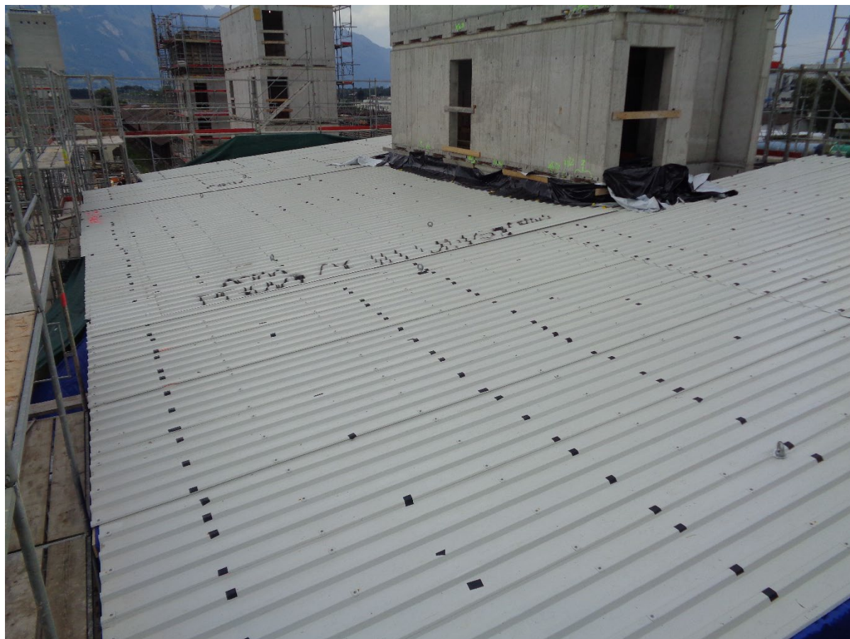
Das Notdach von aussen
