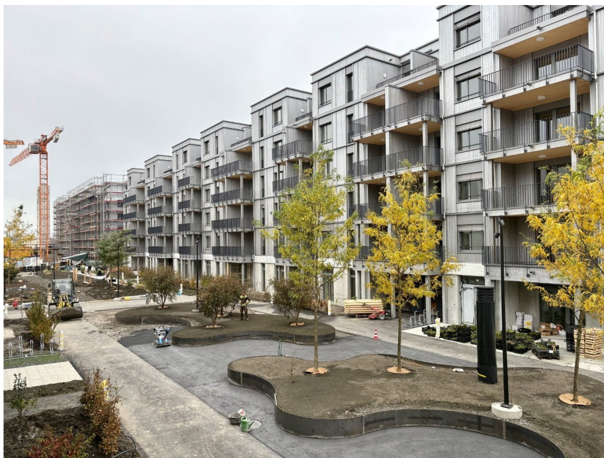
Die Westfassade mit Innenhof, im Hintergrund Etappe 2
