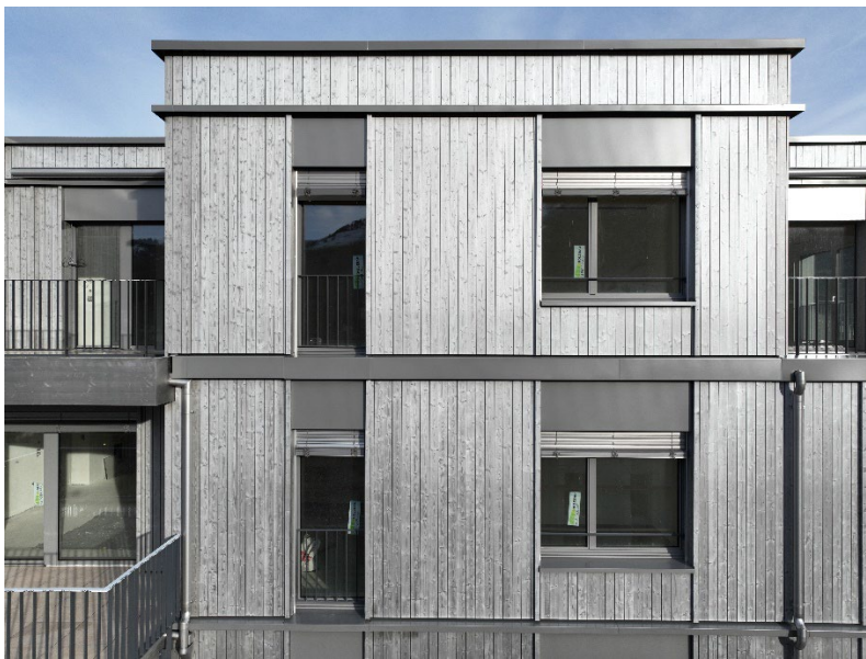
Der hohe Blechabwurf der Attika
