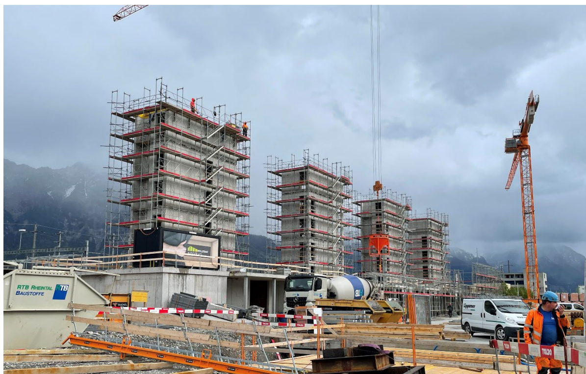
Die Treppenkerne aus Ortbeton
