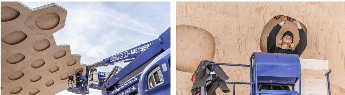
Abbildung 11+12: Aufbau der Schalenkassetten im freien Vorbau. Fugen zwischen den Kassetten werden durch das Anziehen der Bolzen geschlossen, bis alle Kassetten direkt aneinanderstoßen.
