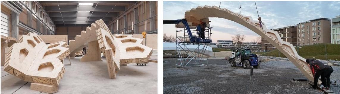
Abbildung 9+10: Vorfertigung der Halbbögen im Werk von Müller Blaustein Holzbauwerke und Aufbau vor Ort und Aufbau vor Ort
