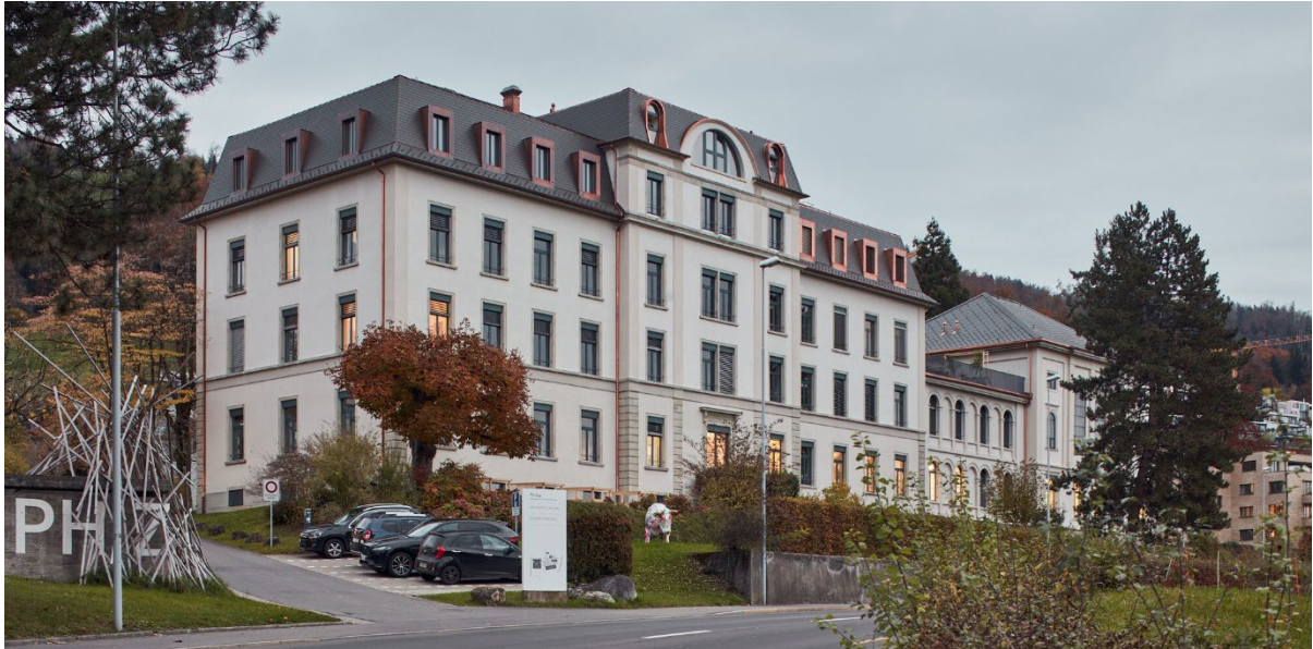
Abbildung 5: Ansicht saniertes Hauptgebäude PHZ
