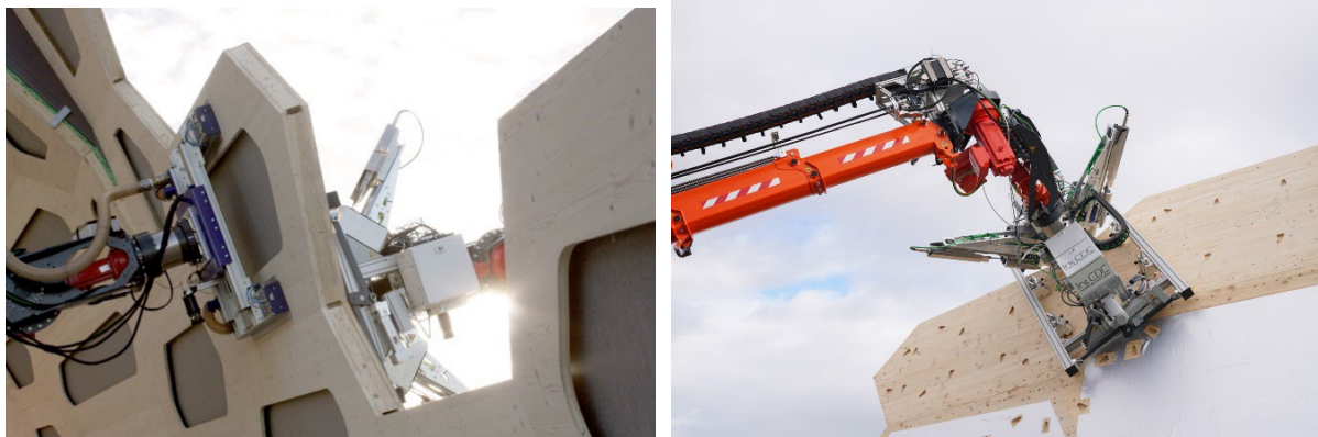
Abbildung 7: Montage der Holzkassetten auf der Baustelle mit links: Effektor zum Positionieren der Bauteile und rechts: Effektor zum Setzen der Vollgewindeschrauben. Foto: ICD/ITKE/IntCDC Universität Stuttgart
