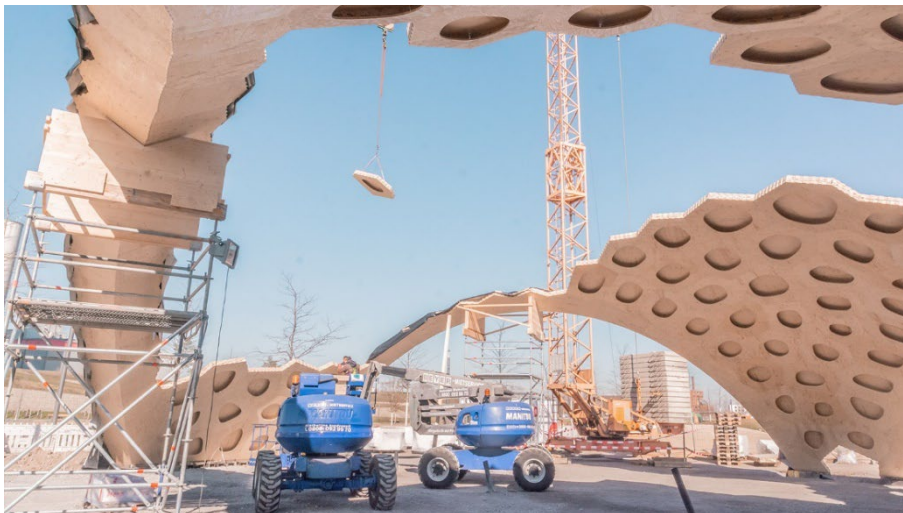
Abbildung 3: Montage BUGA Holzpavillon. Quelle: ICD/ITKE Universität Stuttgart
