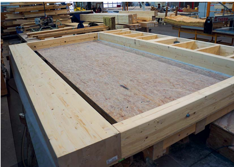
◀ Im Werk erfolgte die Fertigung der Alufenster-elemente und der Holz- sowie Stahlbauteile
