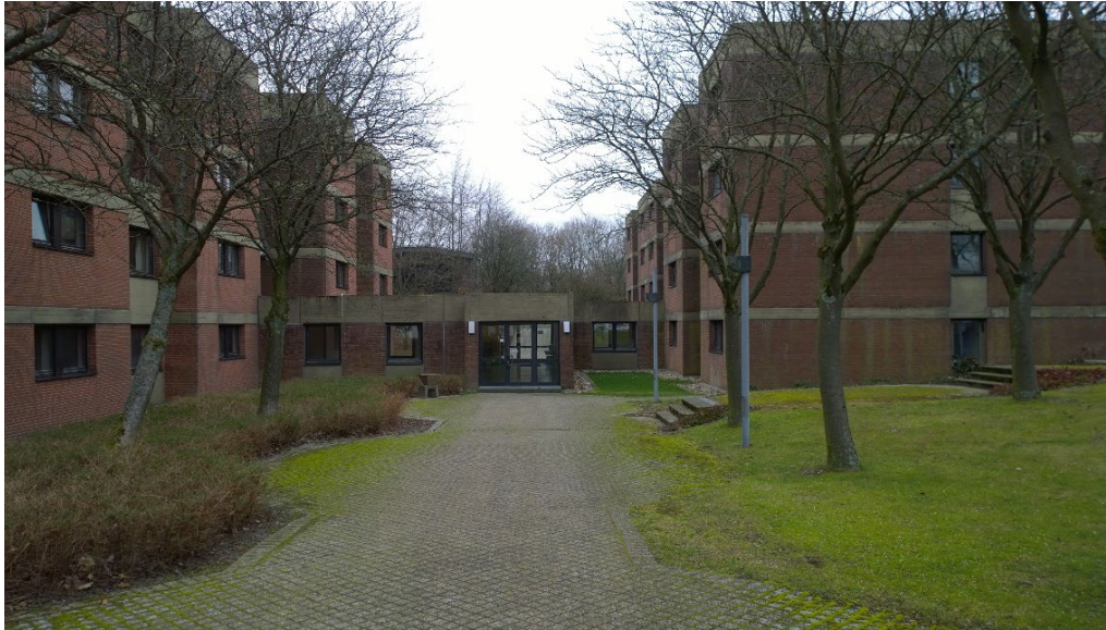
Abbildung 4: Ehemalige Internate C und B des BGZ vor dem Abriss, Blick in Richtung Walter-Bachmann-Straße
