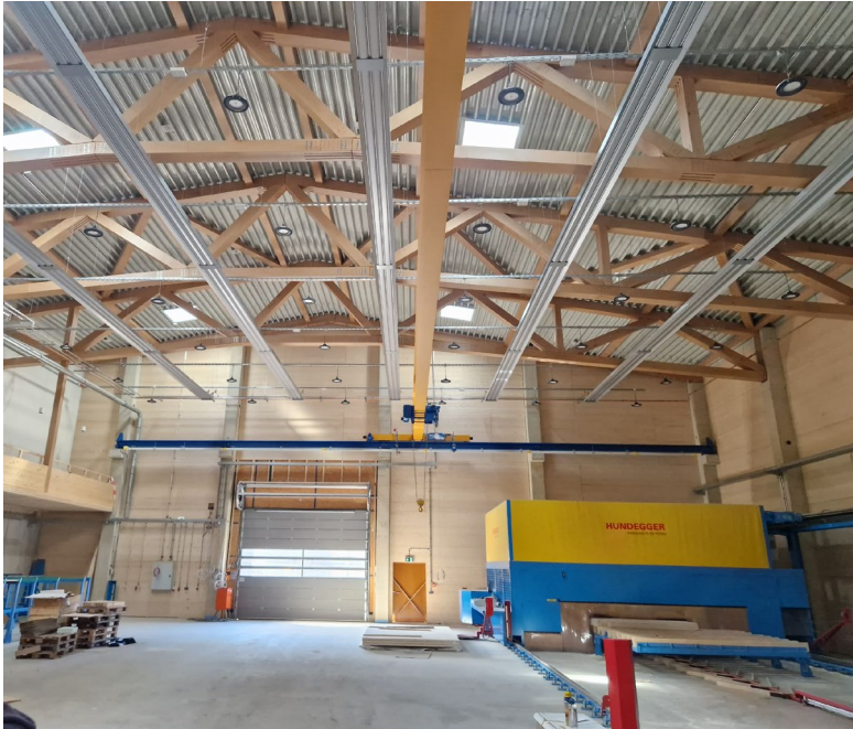
Abbildung 10: Abbundhalle (Halle II) mit Portalbearbeitungsanlage (rechts im Bild)
