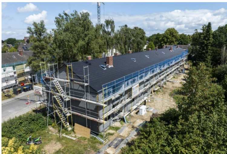
Abbildung 7: Sanierungsprojekt im Mönchengladbach-Hardt
