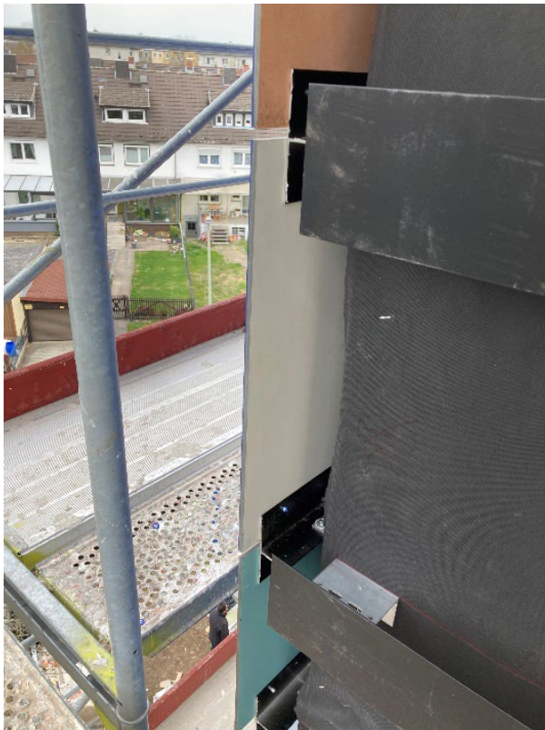
Abbildung 9: Fassadenplatten Eckausbildung (Rückseite) mit UK aus Aluminium
