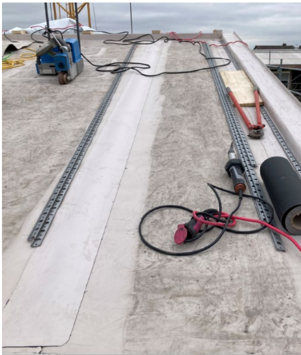
Abbildung 7: Dachbahn kombiniert alt / neu
