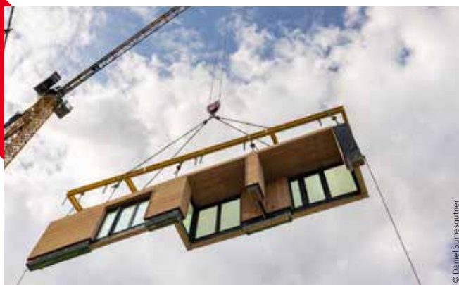
2.770 vorgefertigte Holzbauelemente lassen das Projekt emporwachsen.
