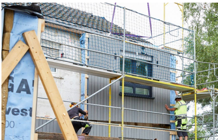
Abbildung 8: Montage Fassadenelement
