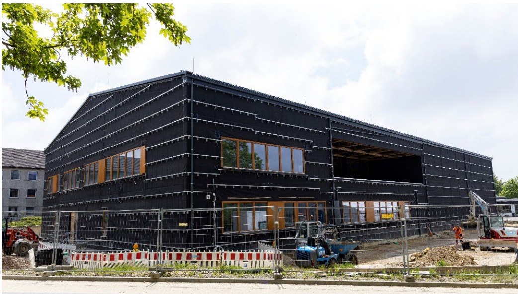
Abbildung 6: Gebäude des AZH während der Bauphase (Aufnahme: Gottschalk, FH Aachen)
