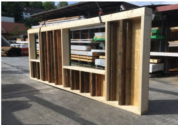
Abbildung 6: Außenwand mit neuem und recyceltem Holz
