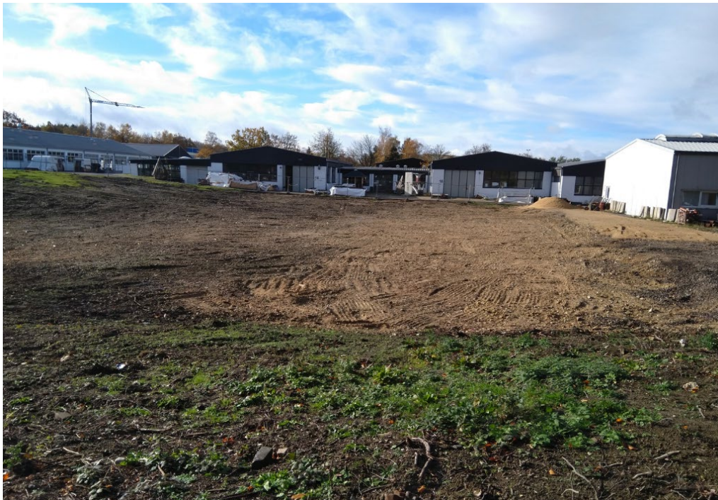
Abbildung 5: Bauplatz für das AZH nach Abriss der Internate B und C, Blick von der Walter-Bachmann-Straße
