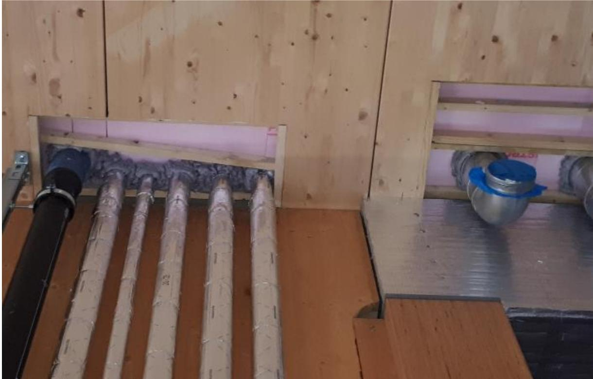
Abbildung 7: Abschottung mit mineralischem Verschluss. Deutlich erkennbar sind Halteleisten, Schalung und Abdichtung mit Bauschaum. Finaler Zustand wird erst nach Trocknung sowie Rückbau der Hilfsmaßnahmen erreicht.
