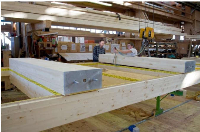
Abbildung 8: Wandfertigung im Werk
