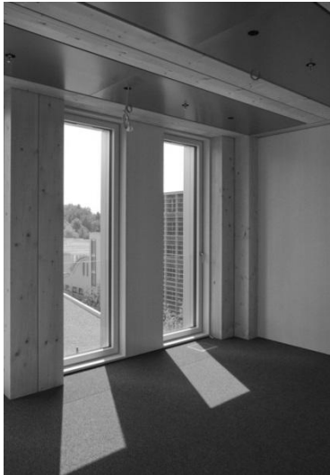
Abbildung 4: Innenraum mit sichtbaren Deckenbalken und Stützen
