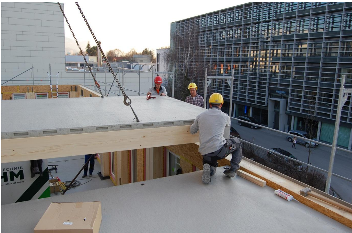
Abbildung 6: Versetzen der Deckenelemente
