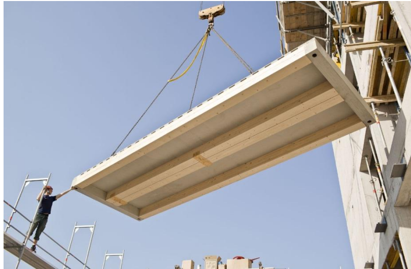
Abbildung 5: Versetzen der Deckenelemente
