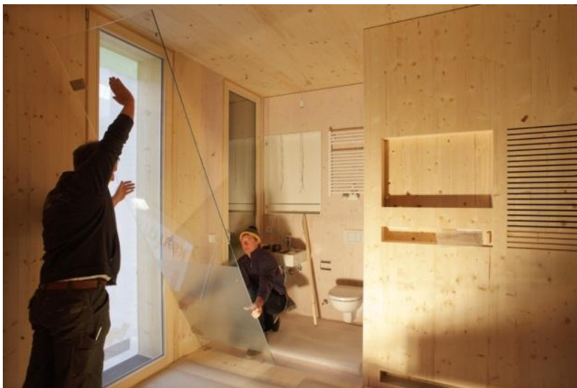
Abbildung 14: Montage der Einrichtung im Werk
