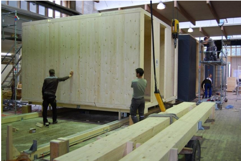
Abbildung 15: Fertigungsstraße auf Schienen im Werk
