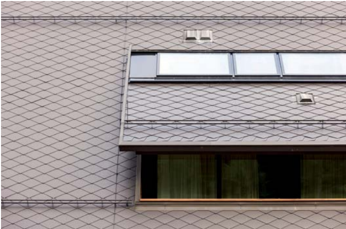
▲ Um das Oberlichtband montieren zu können, wurde die Unterkonstruktion durch Brettsper Holzplatten ersetzt. Die Anschlüsse mussten besonders präzise angearbeitet werden
