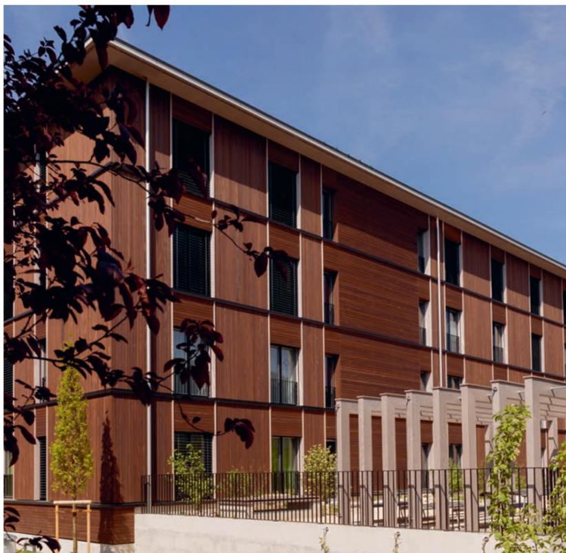
Auch die druckimprägnierte, geölte Fassade aus Weisstannenholz ist in Vorfabrikation entstanden.
