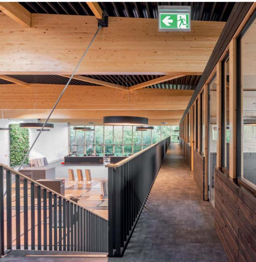
◀ Die Unterzüge für die Brettstapeldecke wurden jeweils mit zwei Zugstangen an den Betonstützen aufgehängt
