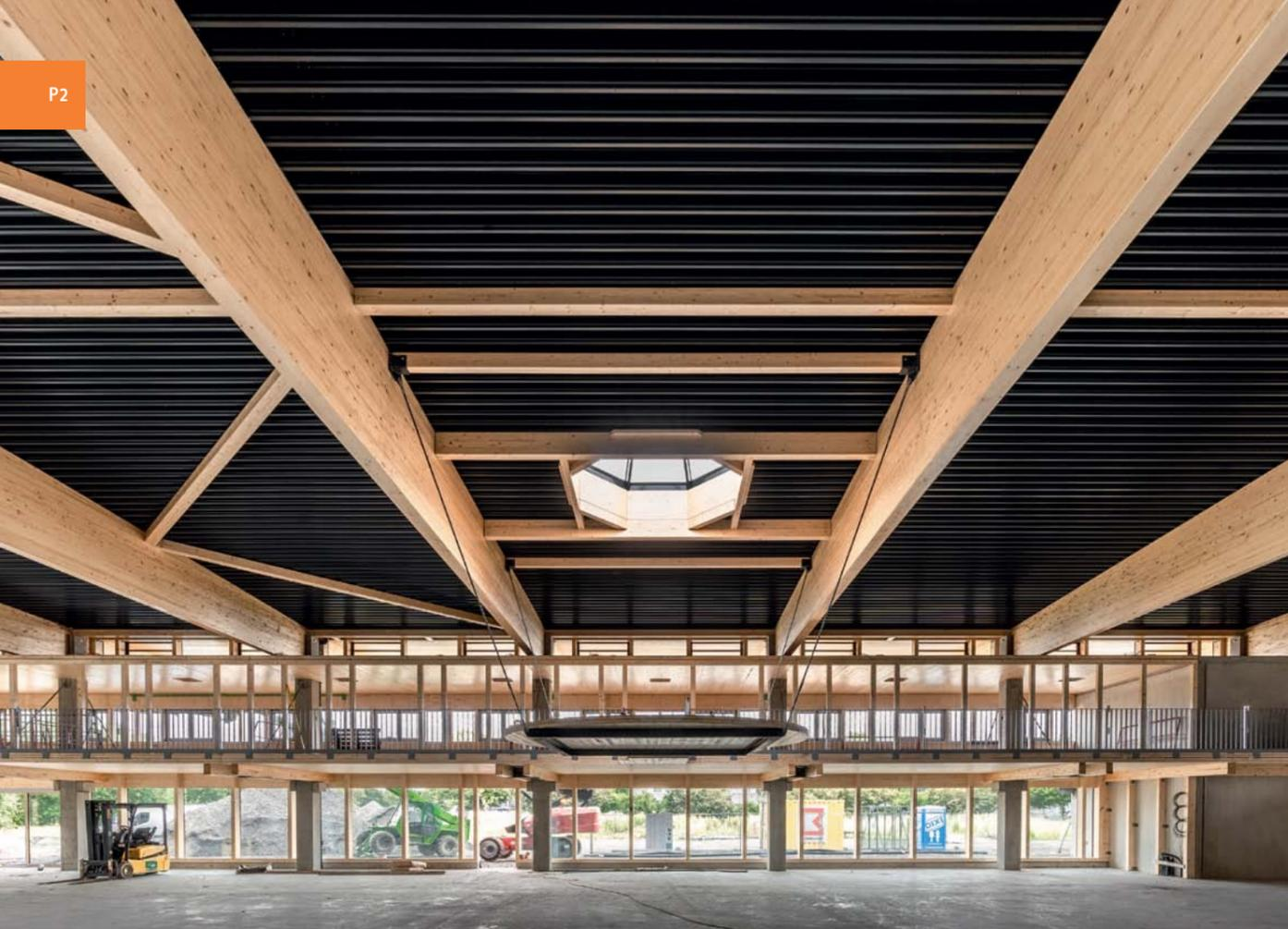
▲ Die Primärkonstruktion der Halle besteht aus einem Satteldachbinder aus Brettschichtholz auf eingespannten Betonfertigteilstützen
