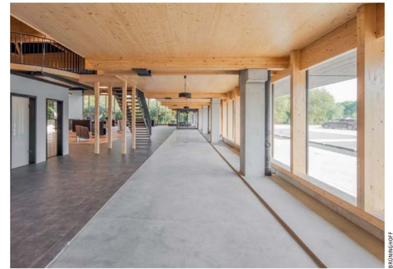
Das Satteldach bietet dabei ein hohes Maß an optischer Ästhetik und ist gleichzeitig ein konstruktives Dachelement. Das freitragende Bauteil ermöglicht dabei große Spannweiten – so sind die Satteldachbinder
