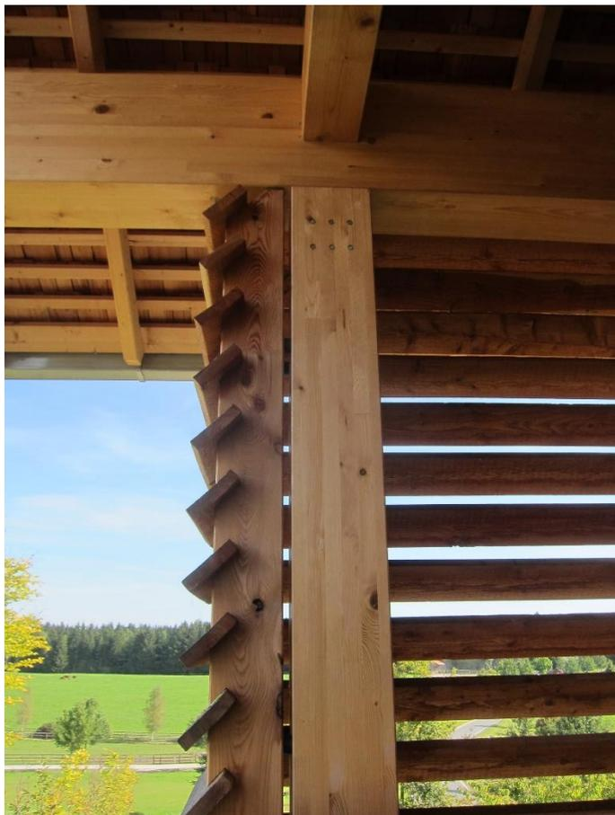
Abbildung 6: Um einen möglichen Feuchteübertrag zu verhindern, sind die Fassadenelemente nur punktuell und mit Abstand an den Fachwerkträgern befestigt.
