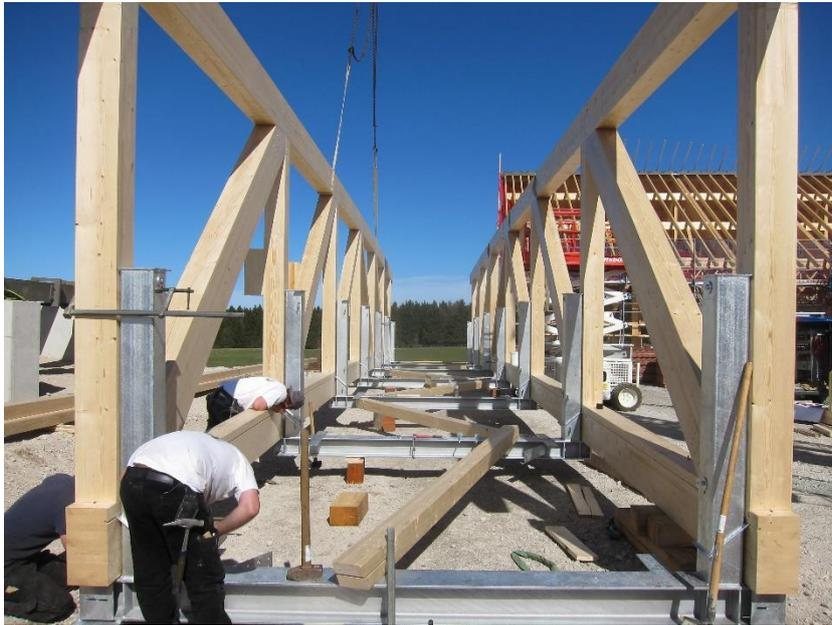
Abbildung 3: Statisches System – Fachwerkträger ausgesteift über biegesteife «U-Rahmen» aus Stahl und horizontalen Verband unter der Tragschicht
