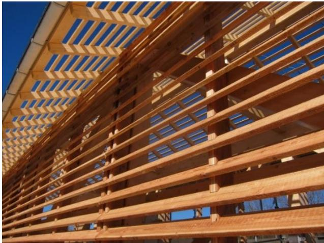
Abbildung 5: Fassadenschalung aus Lärche – Schlagregenneigung 65°
