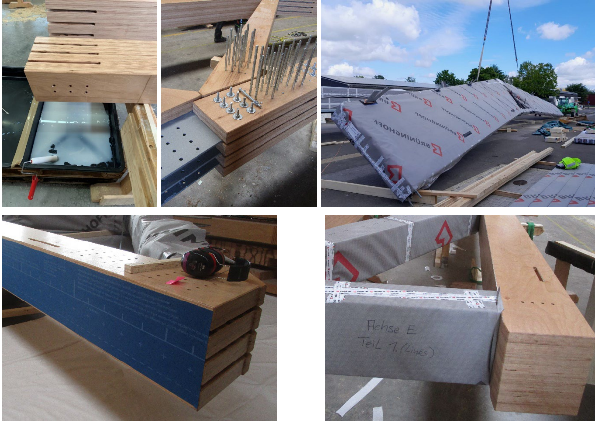
Abbildung 13: Bauteile der BauBuche-Fachwerkträger, Hydrophobierung, Montage der Verbindungsmittel und Bauteilschutz, Fotos: Brüninghoff Group, Bilder 6 a/b, 7 a/b und 8 b aus [6]
