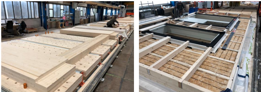
Abbildungen 12, 13: Elementfertigung Brettsperrholz, Dämmebene und Riegelwerk – Fotos: MAX Holzbau
