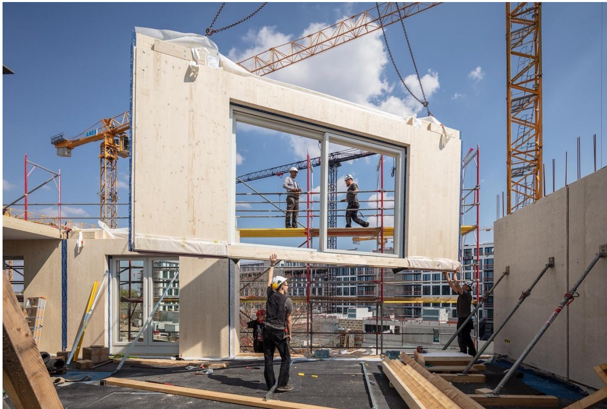
Abbildung 16: Baustelle Gotenstraße 44, Berlin Schöneberg – Foto: Andreas Meichsner, Berlin
