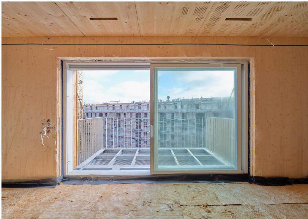
Abbildung 6: Baustelle Gotenstraße 44, Berlin Schöneberg – Foto: Andreas Meichsner, Berlin
