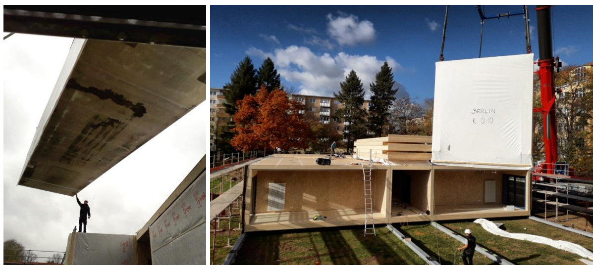
Abbildung 3 und 4: Montage der Raumzellen
