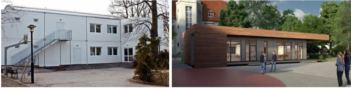
Abbildung 17 und 18: Schulersatzcontainer und Holzmodul DFK.75
