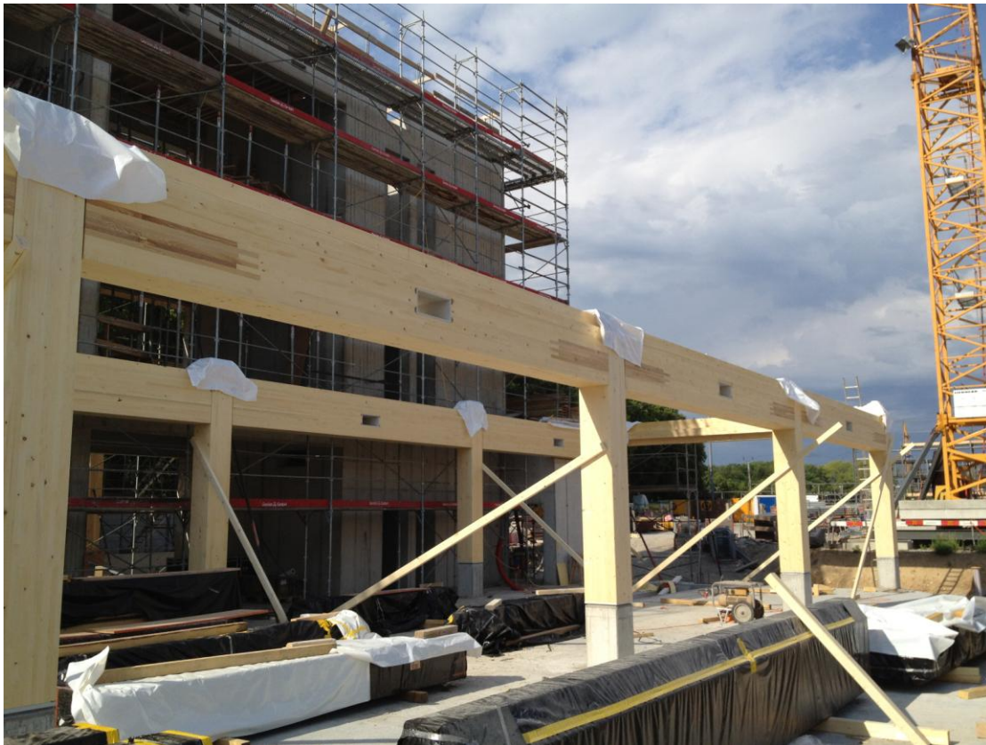
Abbildung 1: Durchbruch in Unterzug (SANO Bern)
