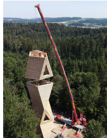
Abbildung 16, 17, 18: Aufsetzen des obersten Turmabschnittes (Fotos: Frischknecht Holzbau AG)
