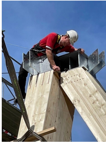
Abbildung 13, 14, 15: Vormontage 3. Turmelement (Fotos: Holzang Maeder GmbH)
