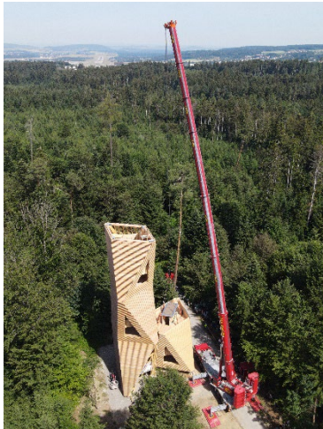
Abbildung 16, 17, 18: Aufsetzen des obersten Turmabschnittes (Fotos: Frischknecht Holzbau AG)
