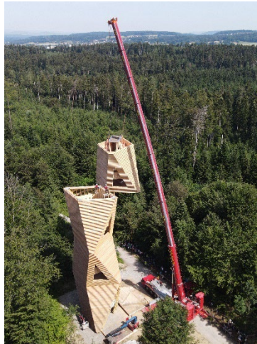
Abbildung 16, 17, 18: Aufsetzen des obersten Turmabschnittes (Fotos: Frischknecht Holzbau AG)
