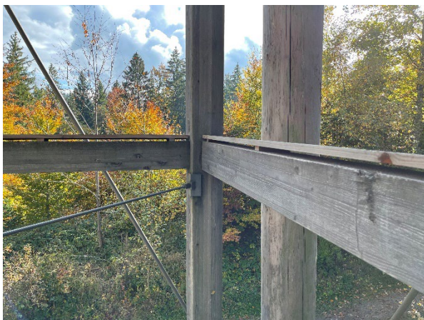
Abbildung 7: Brett als Witterungsschutz bei Horizontalbauteilen (Fotos: Holzring Maeder GmbH)
