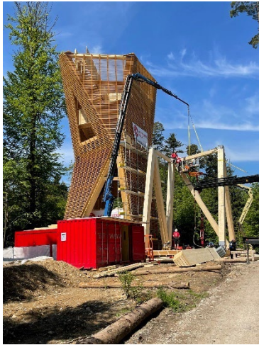
Abbildung 13, 14, 15: Vormontage 3. Turmelement (Fotos: Holzang Maeder GmbH)
