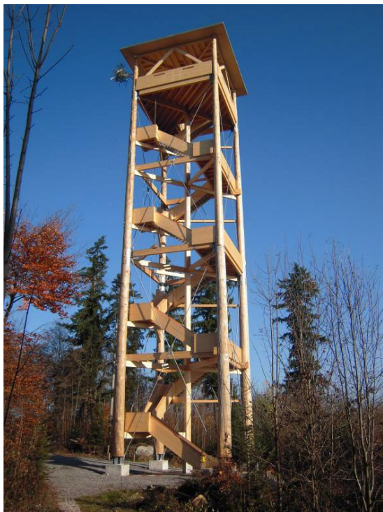
Abbildung 1: Turm nach der Fertigstellung (2009) (Fotos: Holzring Maeder GmbH)
