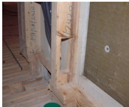
Abbildung 6: Nachträglicher Stützendurchbruch
