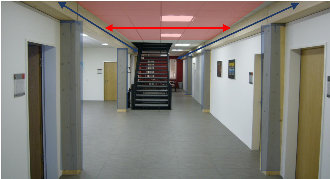
Abbildung 4: Gewerbeschule Paul Müller – Baar/CH; Darstellung des Primärtragwerks (Stützen/Unterzüge) in blauer Farbe, Darstellung des Sekundärtragwerks (Decke) in roter Farbe
