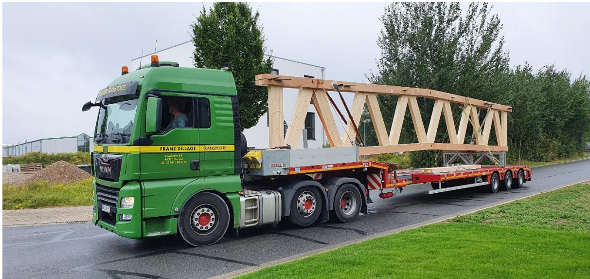
Abbildung 4: Demonstrator des entwickelten Trägers mit 16 m Länge (Bildquelle: Brüninghoff)
