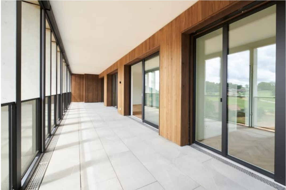
Abbildung 3: Laubengang Gebäude A
