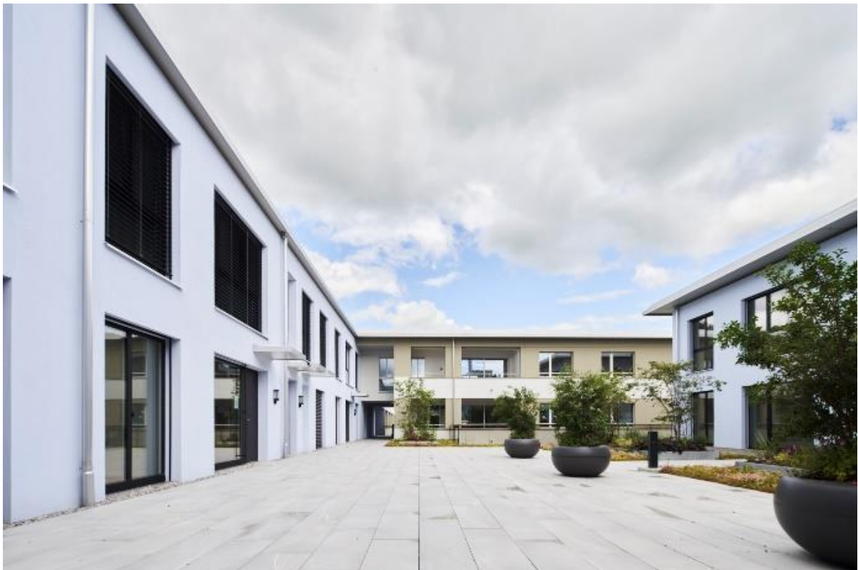
Abbildung 4: Innenhof Gebäude B
