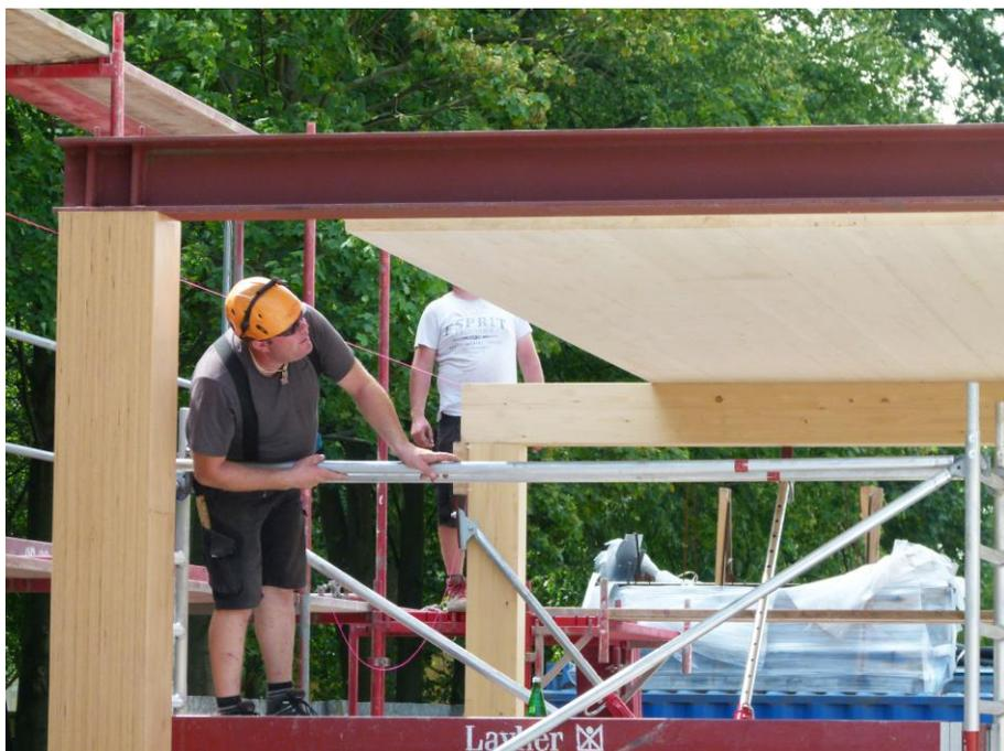
Abbildung 3: Montage der Deckenelement auf den Unterzügen
