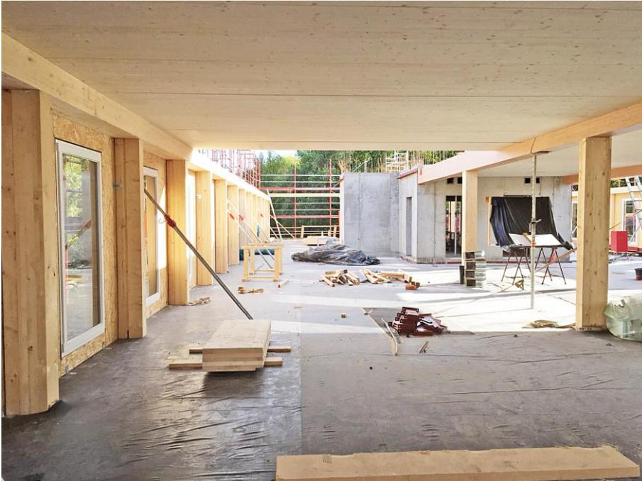
Abbildung 2: Rohbau mit Skelett aus Stützen und Trägern.
