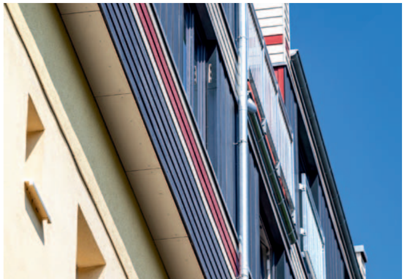
▲ Der aufgestockte Gebäudeteil bezieht seine Wirkung aus der Kombination von horizontal und vertikal angeordneten Fassadenbekleidungen sowie aus einer Farbgebung, die Akzente setzt
