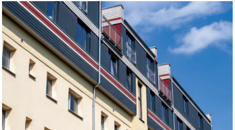
▲ Für die großen Flächen zwischen den Fenstern und Türen wählte der Planer Paneele in edlem Anthrazitgrau aus, die vertikal montiert wurden
