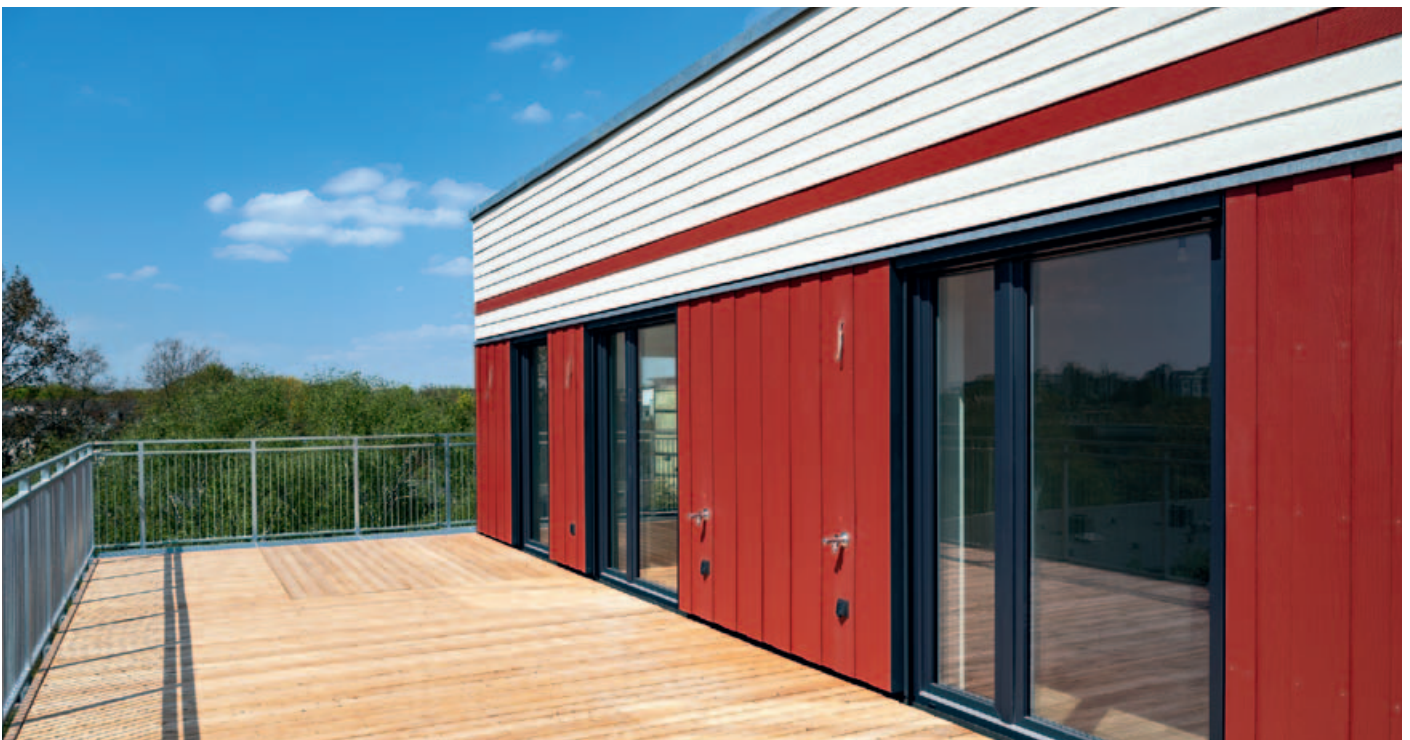
▲ Die Fassadenbereiche des Staffelgeschosses: Hier wurden Fassadenbekleidungen vertikal verarbeitet
