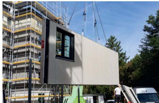
▲ Die geschosshohen Fassadenelemente wurden bei Huber & Sohn GmbH & Co. KG (Eiselfing) vorgefertigt und...
