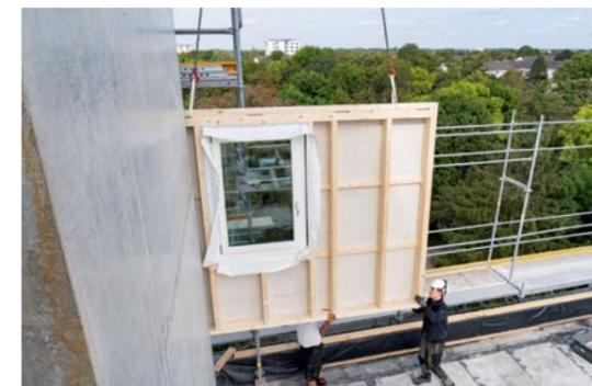
▲ Ein Hochkran versetzte die einzelnen Wandelemente, die auf Wechselbrücken mit einem Tiefbettsattelaufleger ankamen
