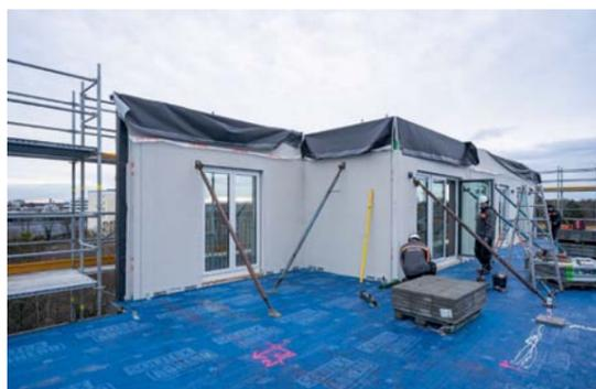
jedoch konnte in Kombination mit einer Wärmepumpe für die Häuser ein klimaneutraler Status erreicht werden. Dazu erhält die Bestandsfassade statt eines klassischen Wärmedämmverbundsystems eine neue Hülle aus Holzrahmenelementen, die bereits mit fertig eingebauten Fenstern quasi
