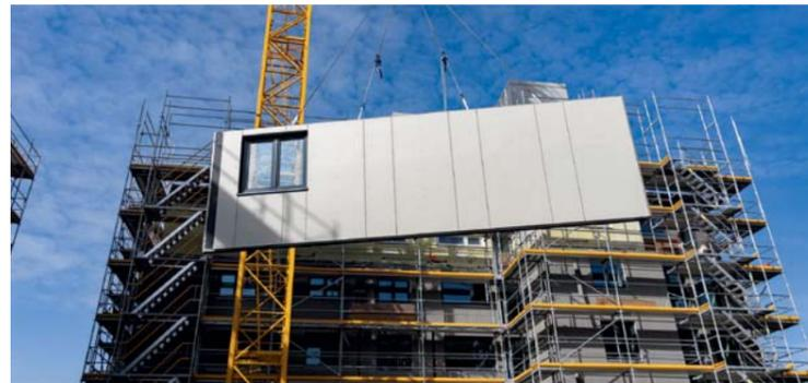
▲ ... bestehen aus einem Holzrahmenelement (160 mm) sowie einer Gefachdämmung aus Mineralwolle WLG 035, die dicht zwischen den Ständern verlegt wird
