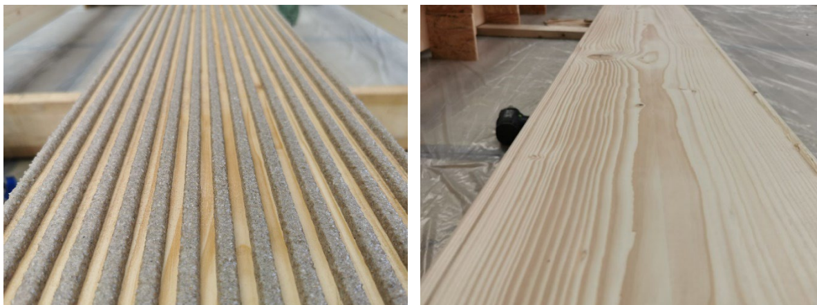
Abbildung 4: Auftrag des Klebstoffs für die Trockenverklebung und Vertiefung im Balken für den flächigen Auftrag des Klebstoffs für die Nass-in-Nass Verklebung (Bildquelle: TU Berlin)
