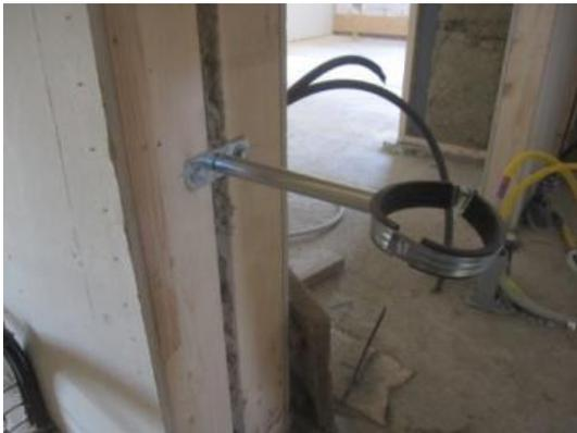
Abbildung 4: Beispiel der falschen Befestigung der Rohrschelle an der zwei-schaligen Trennwand
