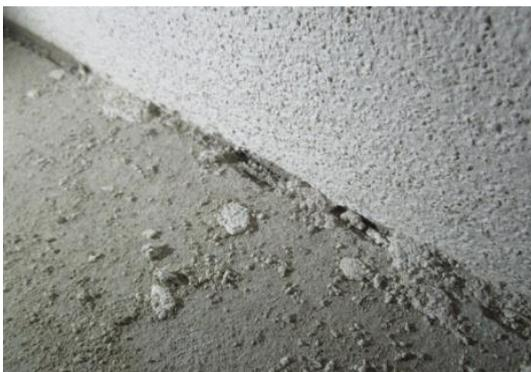
Abbildung 3: Beispiel von Fuge zwischen Wand und Zementestrich mit Abrieb
