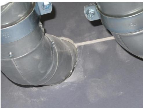
Abbildung 7: Starre Berührung zwischen Lüftungsrohre und Wand
