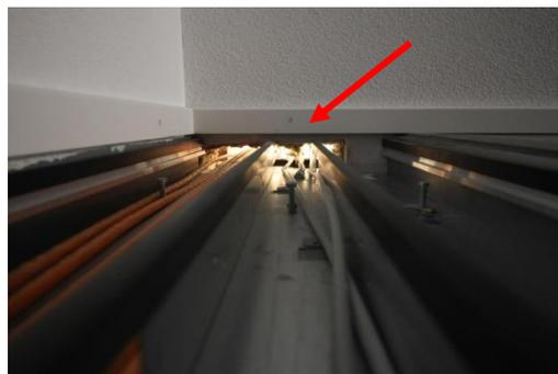
Abbildung 9: Einfluss der Schallübertragungen durch eine durchlaufende leere Elektrotrasse unter einer Trennwand
