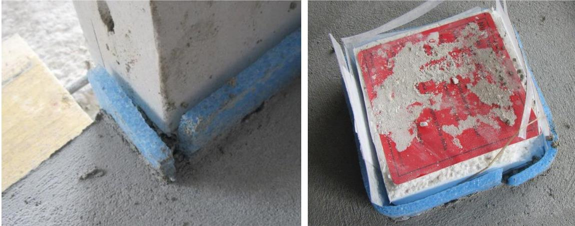
Abbildung 1: Beispiele von nicht durchgehenden Randstreifen bei einer Ecke und einem Deckendurchbruch
