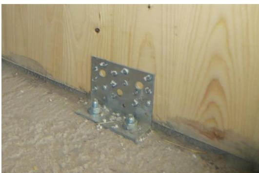
Abbildung 5: Vollholzwand mit Schallschutzlager und ohne schallentkoppelten Befestigungsmittel
