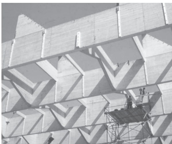
Abbildung 2: Hauptträger mit Nebentragwerk der Eishalle Bad Reichenhall [5]
