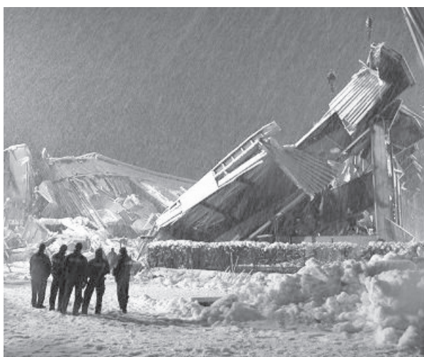
Abbildung 3: Eingestürzte Eishalle Bad Reichenhall im Januar 2006 [6]
