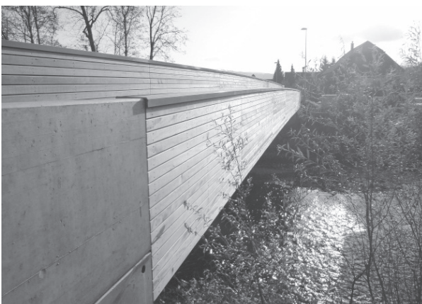
Abbildung 13: Ansicht der Obermattbrücke
