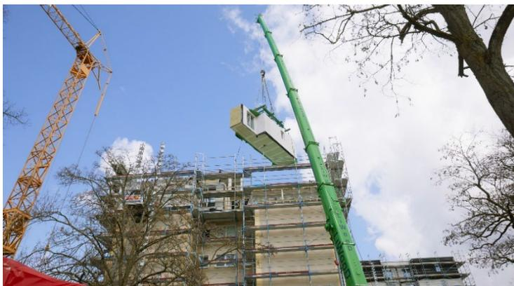
Abbildung 11: Versetzen eines Moduls am Hochbau am Beispiel der Fritz-Kissel-Siedlung Frankfurt ©skykamera
