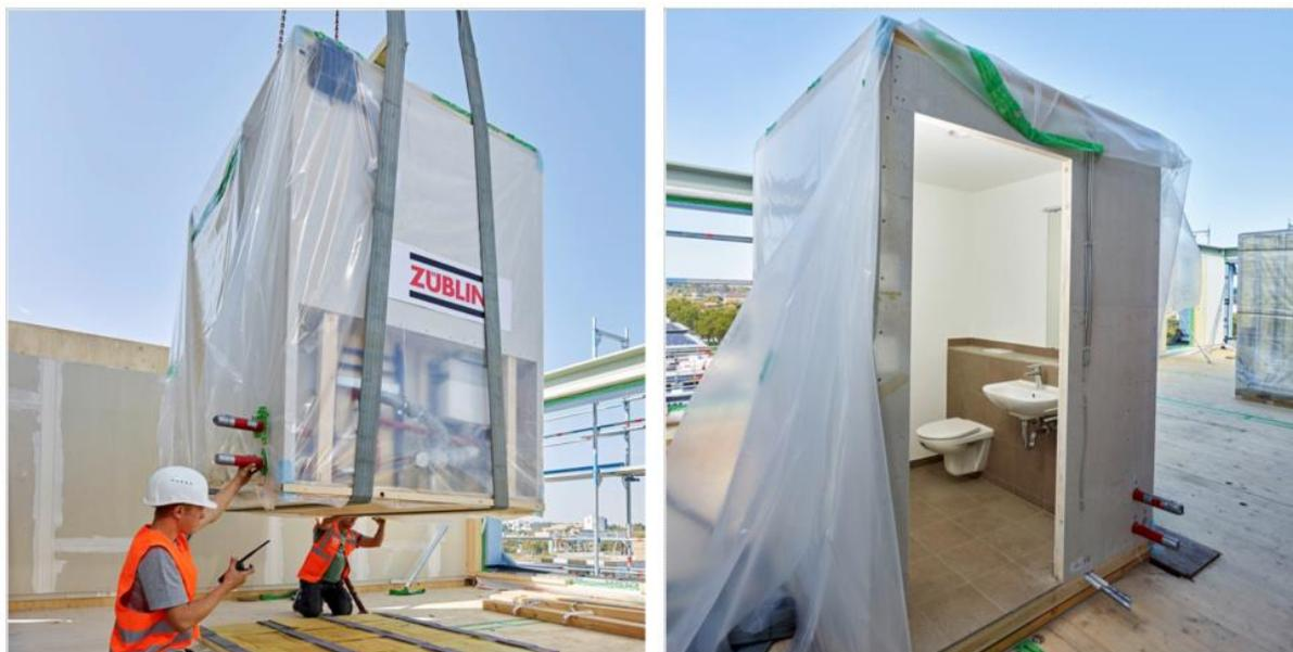
Abbildung 9: Badmodule mit Wänden aus Holz-Verbundwerkstoff
